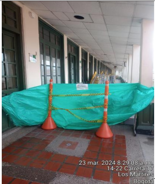
7- SEÑALIZACION EXTERNA OBRA-SST
