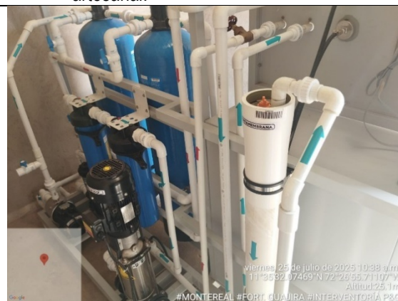
64. Seguimiento de obra. (comunidad MONTEREAL) Vista general de los componentes de la planta de tratamiento.
