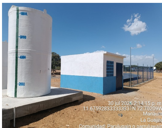
Ilustración 13. Instalación de paneles - Comunidad Parulugain.
