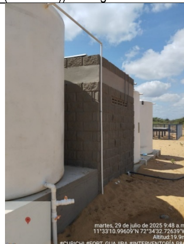
70. Seguimiento de obra. (comunidad CURICHI) Vista posterior de la caseta.
