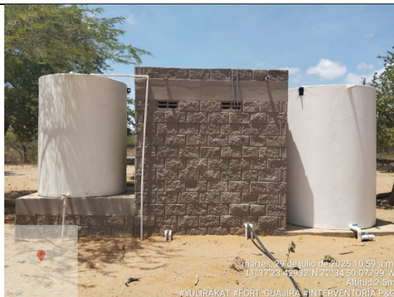
75. Seguimiento de obra. (comunidad YULIRAKAT) Vista posterior de la caseta.
