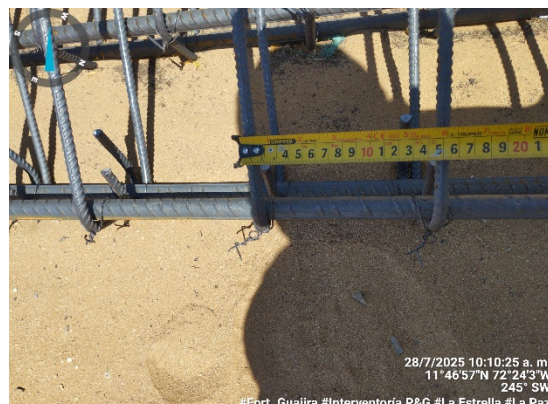
34. Verificación de acero para vigas de cimentación de placas comunidad La Paz .
