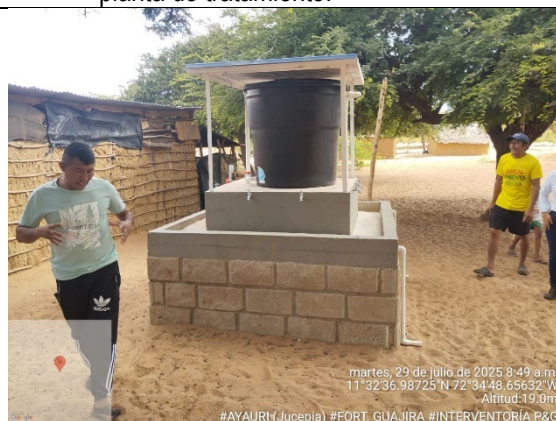
68. Seguimiento de obra. (comunidad AYAURI (JUCEPIA)) Vista general del bebedero.
