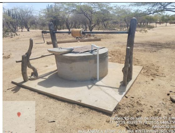
62. Seguimiento de obra. (comunidad KALANKALA) Vista externa del pozo artesanal.
