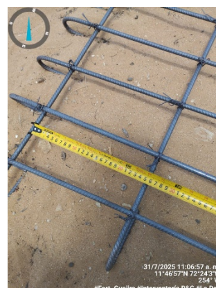
38. Se verifica el acero para placa de tanques comunidad La Paz .
