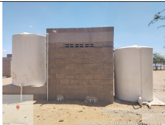
60. Seguimiento de obra. (comunidad JURIACAT) Vista posterior de la caseta.
