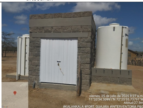
61. Seguimiento de obra. (comunidad KALANKALA) Vista frontal de la caseta.
