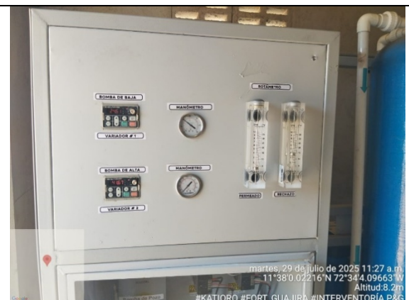
72. Seguimiento de obra. (comunidad KAGUALASH) vista del tablero superior de la planta de tratamiento.
