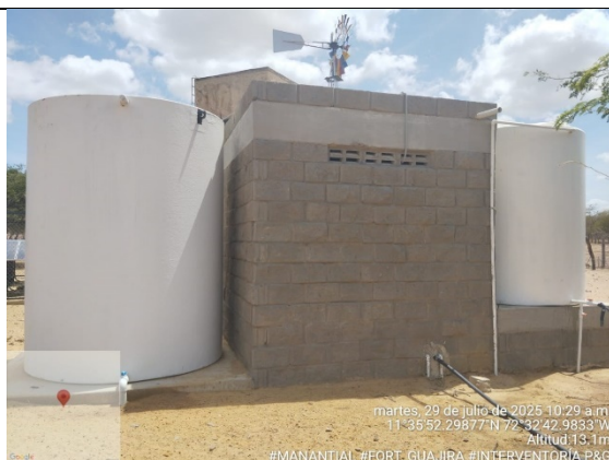
73. Seguimiento de obra. (comunidad MANANTIAL) Vista posterior de la caseta.
