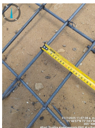
37. Se verifica el acero para placa de tanques comunidad La Paz .
