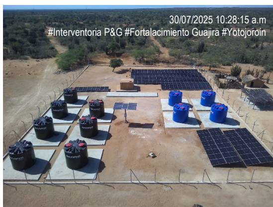
35. Vista genera de obra comunidad Yotojoroin .
