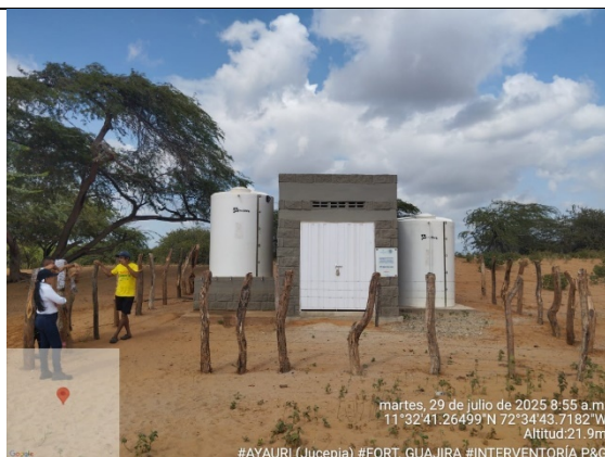
67. Seguimiento de obra. (comunidad AYAURI (JUCEPIA)) Vista frontal de la obra.
