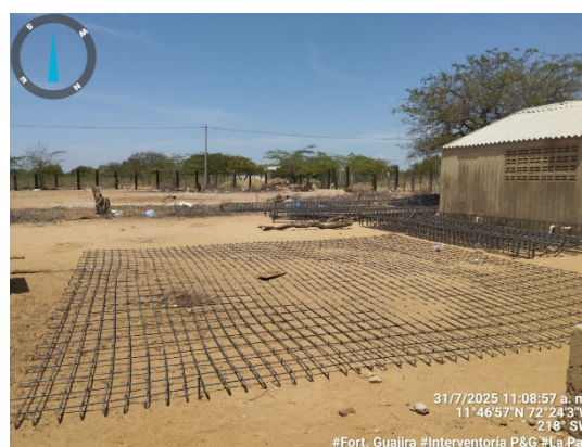
36. Figurado de acero para placa de tanques comunidad La Paz .
