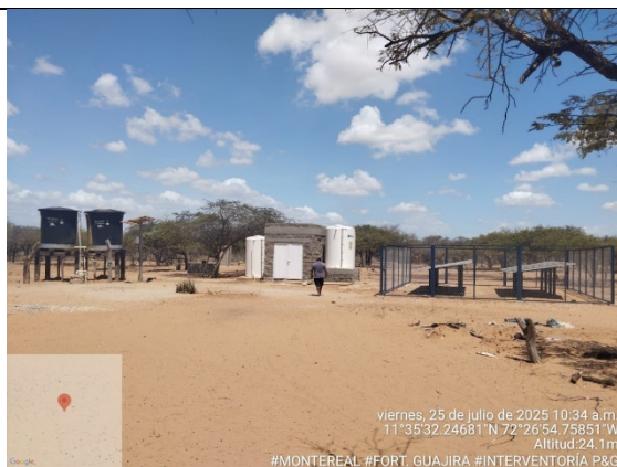
63. Seguimiento de obra. (comunidad MONTEREAL) Vista general de la obra.
