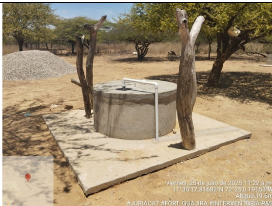
59. Seguimiento de obra. (comunidad JURIACAT) Vista externa del pozo artesanal.
