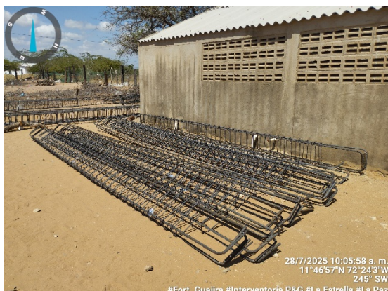
33. Figurado de acero para vigas de cimentación placa de tanques comunidad La Paz .
