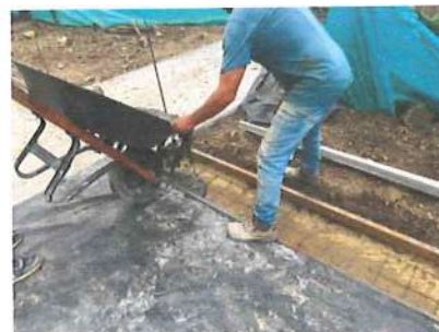
Ilustración No. 50 – Cuneta en concreto zona lateral izquierda
