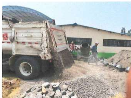
Ilustración No. 67 – Acopio de materiales pétreos
