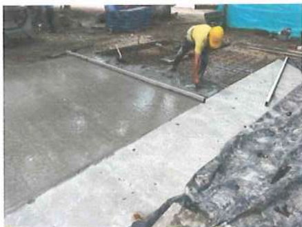
Ilustración No. 51 – Placa de piso en concreto zona frontal del parque
