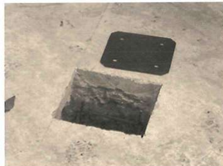
Ilustración No. 72 – Instalación de platinas para pedestal de modulo Abaco
