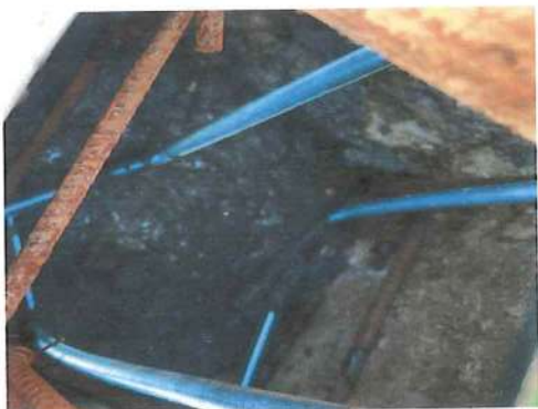
Ilustración No. 39 – Solado en concreto modulo recreativo
