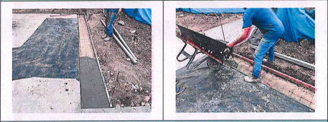
Placa de piso en concreto de 3000 PSI e=0,12 mts incluye corte de juntas y sello.
