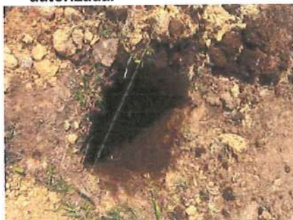
Ilustración No. 61 – Excavación de pedestales zona lateral derecha
