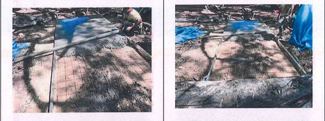
CUNETA EN CONCRETO DE 3000 PSI
