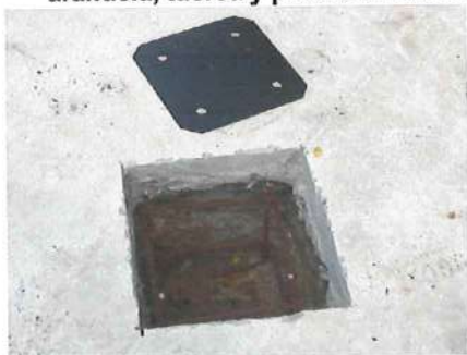
Ilustración No. 45 – Instalación de platinas para pedestal de modulo recreativo
