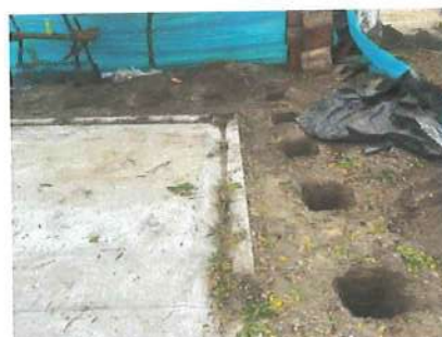
Ilustración No. 36 – Excavación de pedestales, zona lateral izquierda
