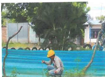
Ilustración No. 33 – Localización y replanteo de pedestales de derecha
