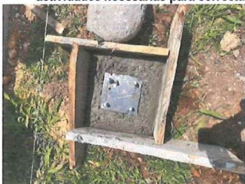
Ilustración No. 62 – Encofrado de pedestal
