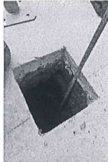
EXCAVACIÓN PEDESTALES – JUEGOS INFANTILES
