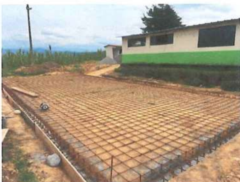
Ilustración No. 69 – Acero de refuerzo zona frontal
