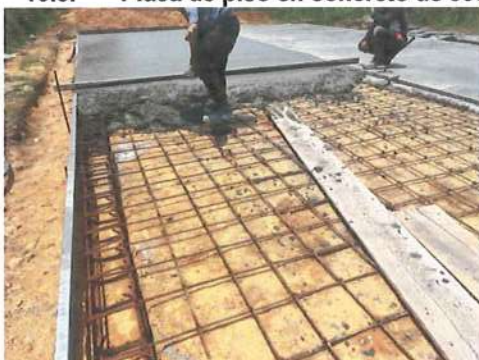
Ilustración No. 60 – Placa de piso en concreto zona frontal del parque
