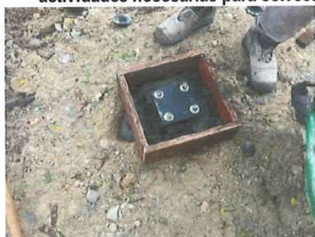
Ilustración No. 53 – Encofrado de pedestales
