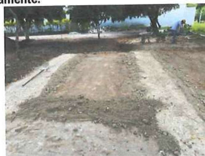
Ilustración No. 38 – Recebo compactado mecánicamente
