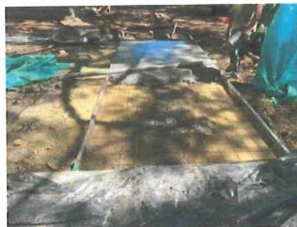
Ilustración No. 48 – Placa de piso en concreto de acceso al parque
