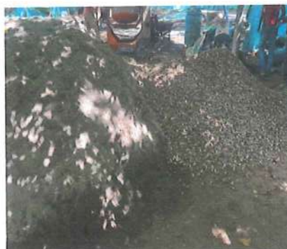
Ilustración No. 58 – Acopio de materiales pétreos
