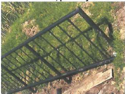
Ilustración No. 64 – Instalación de baranda metálica zona posterior
