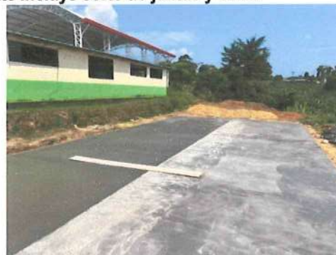
Ilustración No. 61 – Placa de piso en concreto zona inferior del parque
