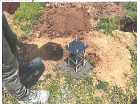
Ilustración No. 63 – Fundida de pedestal
