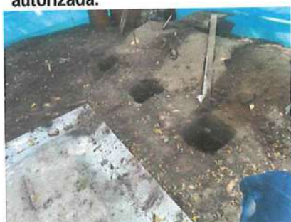
Ilustración No. 35 – Excavación de pedestales, zona frontal
