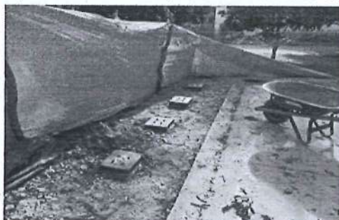
CONSTRUCCIÓN DE PEDESTALES EN CONCRETO DE 210 KG/CM2-3000 PSI-DE 30*30 ALTURA 40 CM
