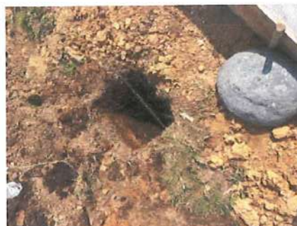
Ilustración No. 62 – Excavación de pedestales zona lateral izquierda
