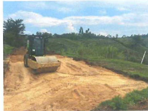
Ilustración No. 64 – Recebo compactado mecánicamente
