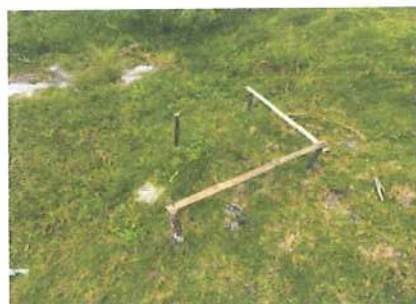
Ilustración No. 60 – localización y replanteo zona de cuneta izquierda
