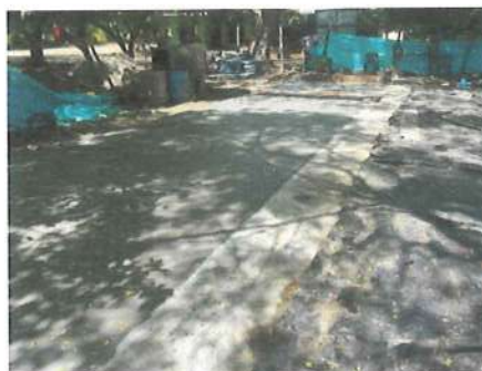
Ilustración No. 52 – Placa de piso en concreto zona inferior del parque
