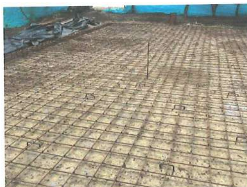
Ilustración No. 44 – Instalación de acero zona lateral izquierda
