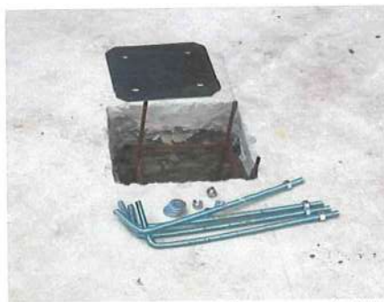
Ilustración No. 46 – Instalación de platinas para pedestal de modulo abaco
