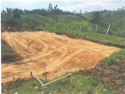
Ilustración No. 63 – Recebo seleccionado en área de placa
