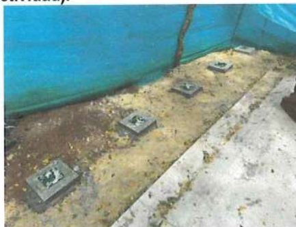
Ilustración No. 54 – Pedestales en concreto
