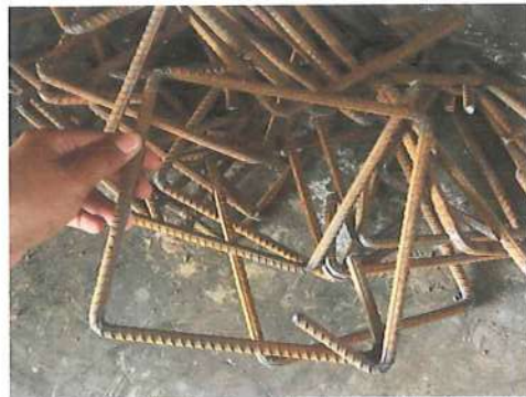
Ilustración No. 70 – Figurado de acero de refuerzo
