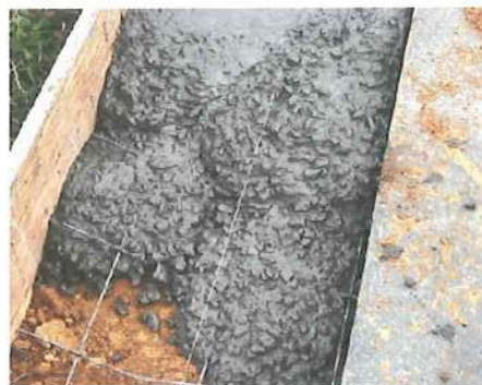
Ilustración No. 59 – Cuneta en concreto zona lateral izquierda
