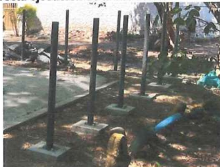
Ilustración No. 56 – instalación de baranda metálica zona lateral
