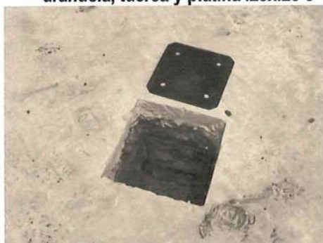
Ilustración No. 71 – Instalación de platinas para pedestal de modulo recreativo
