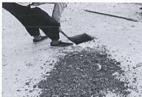
EXCAVACIÓN PEDESTALES – JUEGOS INFANTILES
