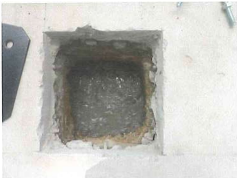
Ilustración No. 65 – Solado en concreto modulo recreativo
