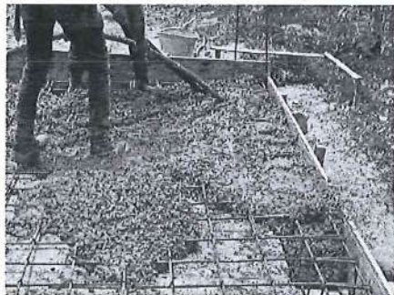
CONSTRUCCIÓN VIGA DE CIMENTACIÓN EN CONCRETO DE 210 KG/CM2-3000 PSI. VER DISEÑO
