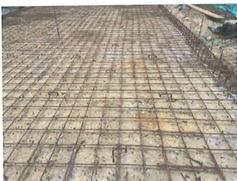
Ilustración No. 43 – Acero de refuerzo zona frontal
