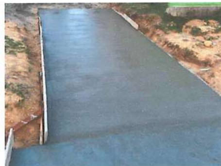
Ilustración No. 74 – Placa de piso en concreto de acceso al parque
