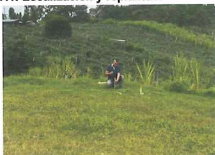
Ilustración No. 59 – Localización y replanteo zona de cuneta derecha
