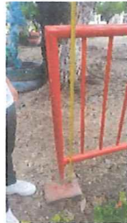
Ilustración No. 4 – Localización y replanteo de pedestales de derecha
