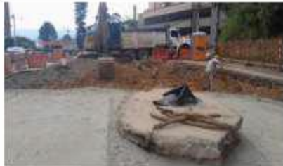
FOTO 65. Excavación para conformación de vía sector los Añás
