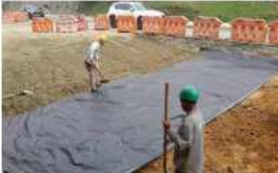
FOTO 64. Instalación de base granular para conformación de vía sector los Añás
