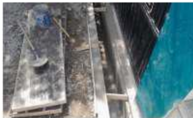
FOTO 57. Construcción de cárcamo sector QUASAR
