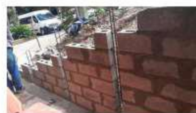
FOTO 53. Construcción de muro de contención en calle 57 sur
