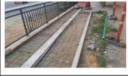
FOTO 56. Vaciado de andén sector San Antonio 2
