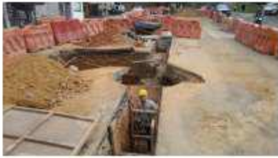
FOTO 61. Excavación para redes hidrosanitarias sector CES (Hallazgo arqueológico)
