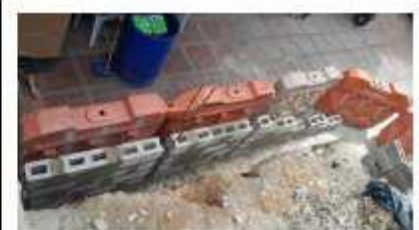
FOTO 54. Construcción de muro de contención en calle 57 sur
