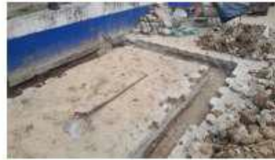
FOTO 59. Excavación para caseta Espacio Óptimo
