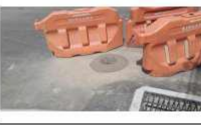
FOTO 55. Realce de tapa válvulas en calle 60 sur
