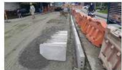
FOTO 67. Instalación de cordonería entre calle 55 sur y urb Portón del sur
