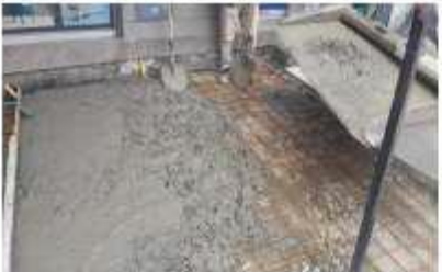
FOTO 63. Vaciado de andenes y piso duro en sector Calle 55 sur
