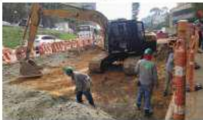
FOTO 66. Excavación para conformación de vía sector los Añás
