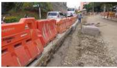
FOTO 68. Instalación de cordonería entre calle 55 sur y urb Portón del sur
