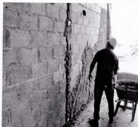
Pañete mampostería en el segundo nivel
