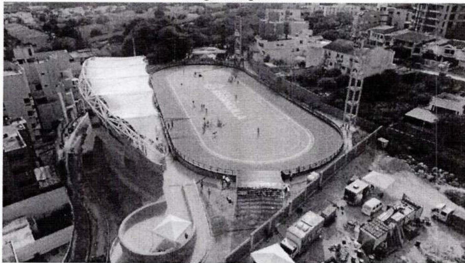
Vista general graderías
