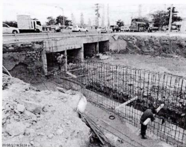
Vaciado de vigas (Pontón, Carrera 12a) y armado de acero de estribos para pontón (Carrera12A).
