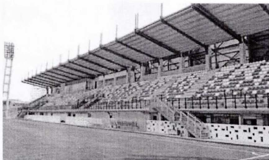
Vista general graderías
