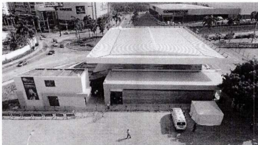
Vista general del proyecto
