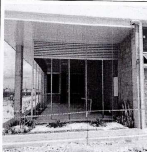
Instalación ventanería recepción
