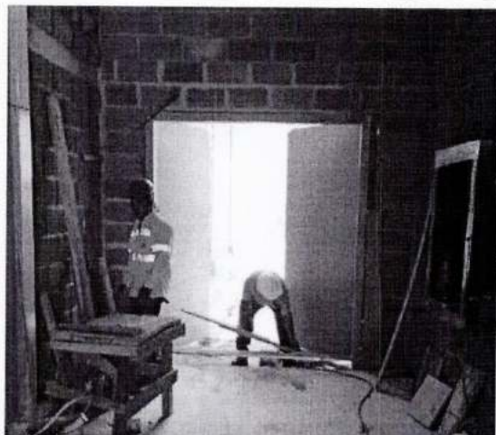
Instalación puertas salidas emergencia
