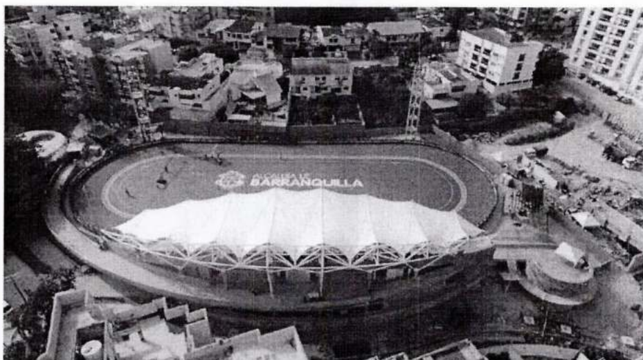
Vista general graderías
