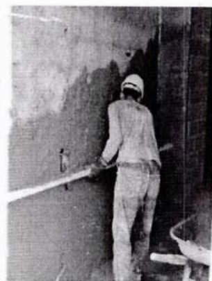
Pañete mampostería en el primer nivel
