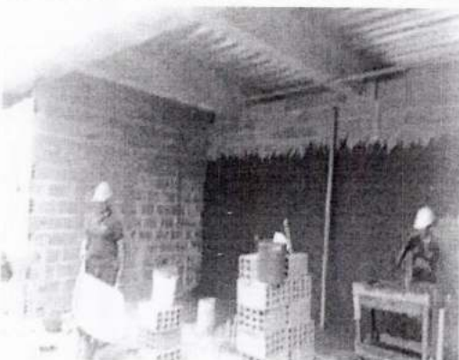
Pañete de muros primer nivel.
