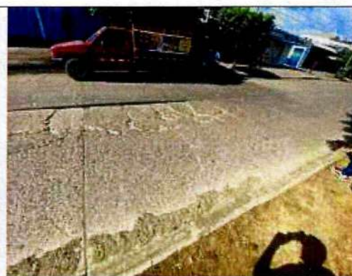
Foto 2. Vías agrietadas
