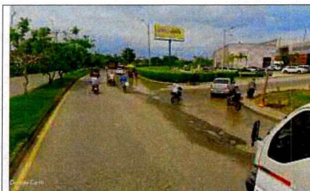
Foto 1. Vías con baches
