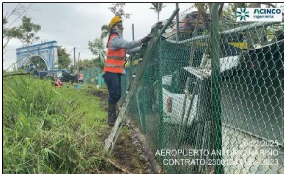
Fotografía No. 8. Mantenimiento, limpieza y pintura del cerramiento en el sector sur oriental frente a torre de control del aeropuerto.
