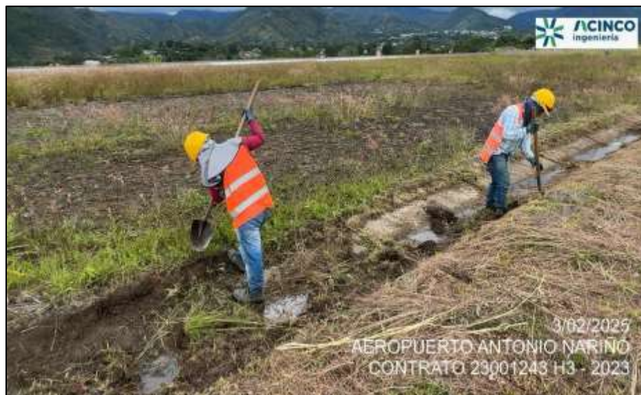
Fotografía No. 4. Retiro de maleza y lodos acumulados para mantenimiento y rehabilitación de los canales de drenaje en el sector sur occidental del aeropuerto.
