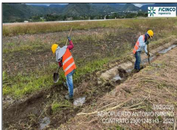
Fot. No. 4 - Retiro de maleza y lodos acumulados para mantenimiento y rehabilitación de los canales de drenaje en el sector sur occidental del aeropuerto.
