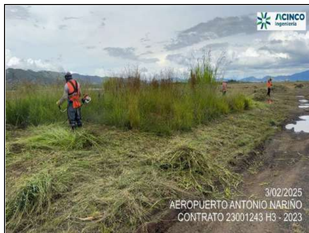
Fot. No. 1 - Rocería manual en zona de seguridad cabecera 0-2 del aeropuerto.
