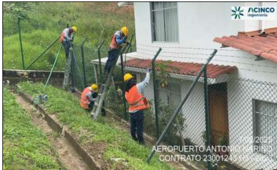
Fotografía No. 3. Mantenimiento y pintura del cerramiento en el sector nor oriental frente a torre de control del aeropuerto.
