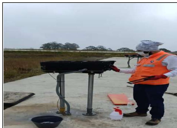
Fot. No. 6 - Mantenimiento de luces PAPI umbral 2-0.
