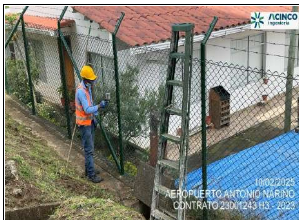
Fot. No. 4 - Mantenimiento, limpieza y pintura del cerramiento en el sector sur oriental frente a torre de control del aeropuerto.
