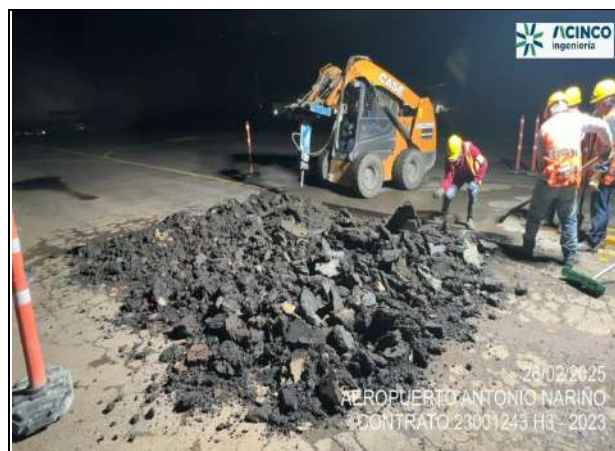
Fot. No. 4 - Demolición de pavimento existente para bacheo en la plataforma del aeropuerto.
