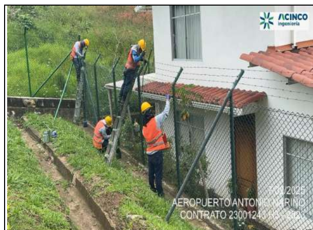
Fot. No. 3 - Mantenimiento y pintura del cerramiento en el sector nor oriental frente a torre de control del aeropuerto.
