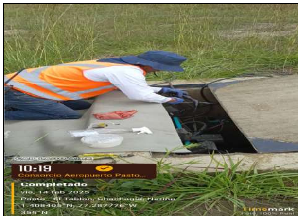
Fot. No. 6 - Instalación de transformador de 150 w en caja de inspección para alimentación de cable secundario de baliza de torre ALS.
