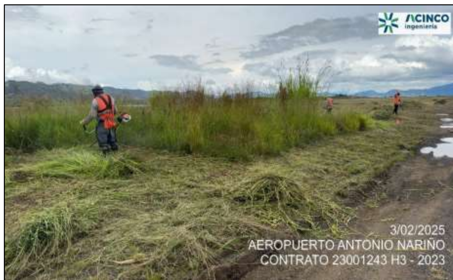
Fotografía No. 1. Rocería manual en zona de seguridad cabecera 0-2 del aeropuerto.
