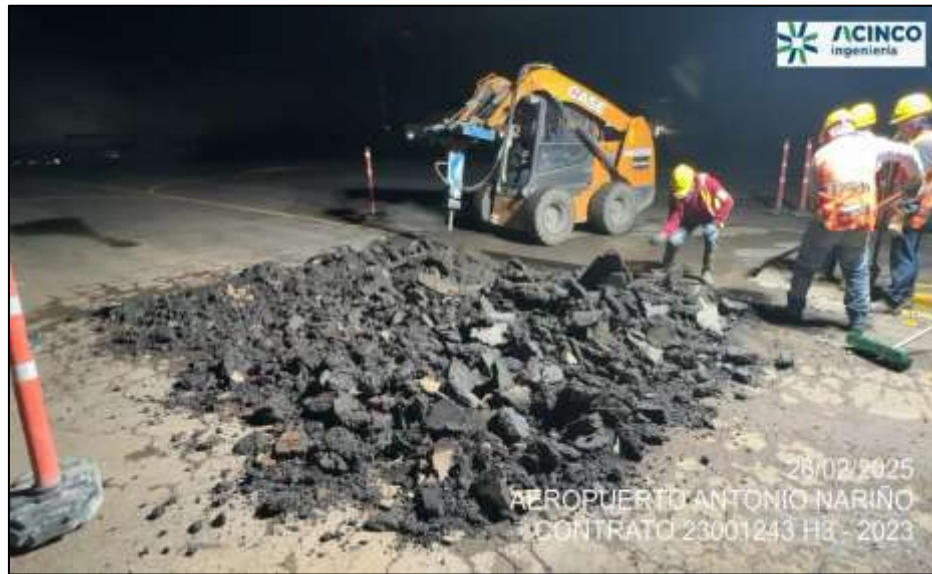
Fotografía No. 11. Demolición de pavimento existente para bacheo en la plataforma del aeropuerto.
