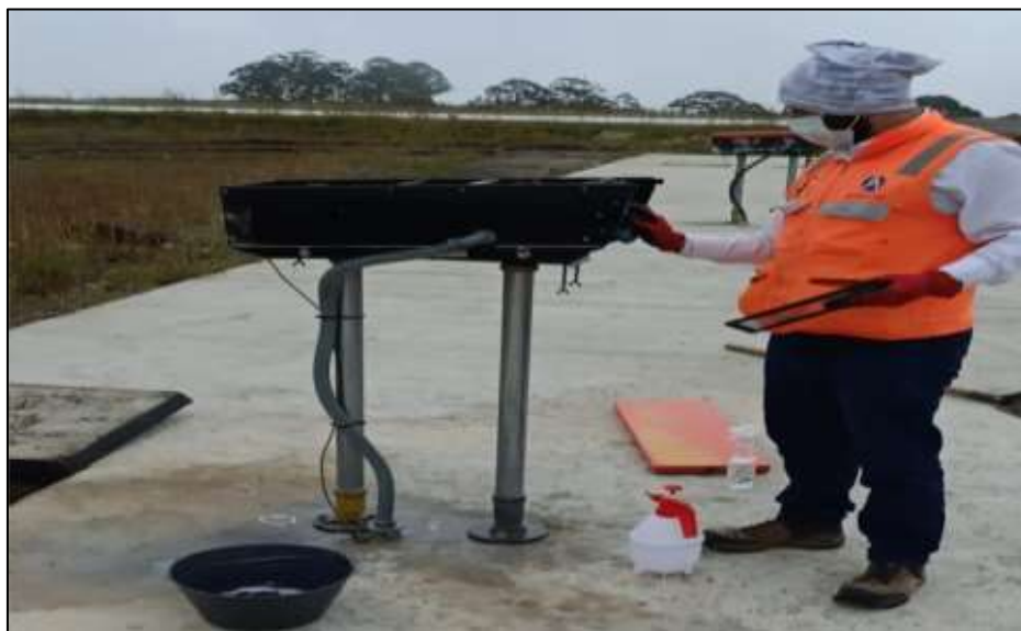
Fotografía No. 10. Mantenimiento de luces PAPI umbral 2-0.
