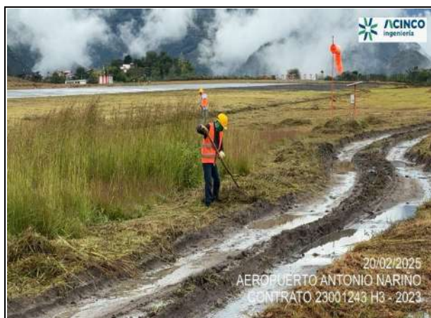
Fot. No. 3 - Recolección de material vegetal producto de la rocería para disposición final en el sitio autorizado.
