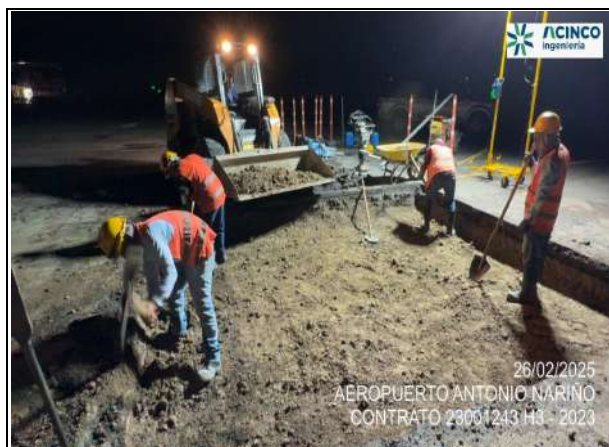
Fot. No. 5 - Excavación y retiro de material para bacheo en la plataforma del aeropuerto.
