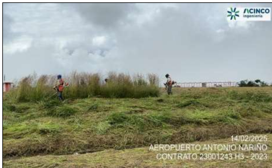
Fotografía No. 6. Rocería manual en zona restringida antenas ILS cabecera 0-2 del aeropuerto.
