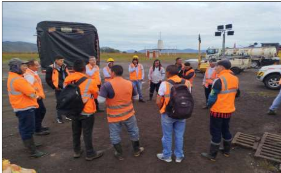
Fotografía No. 9. Charla de seguridad diaria de 5 minutos a todo el personal de obra.
