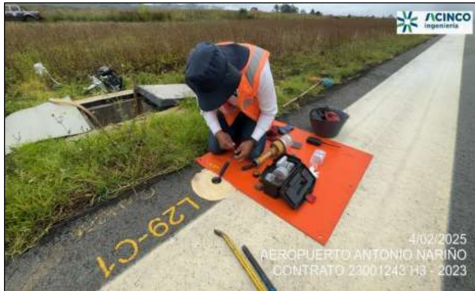
Fotografía No. 5. Mantenimiento y restablecimiento del funcionamiento baliza de borde de pista del aeropuerto.
