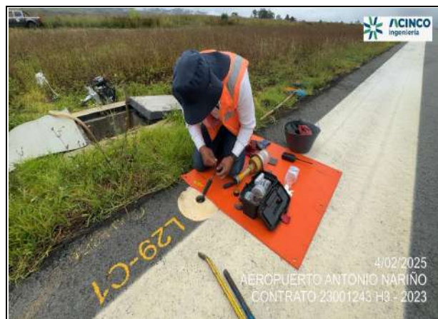
Fot. No. 5 - Mantenimiento y restablecimiento del funcionamiento baliza de borde de pista del aeropuerto.
