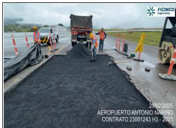
Fot. No. 6 - Extendido de mezcla asfáltica para bacheo en la plataforma del aeropuerto.
