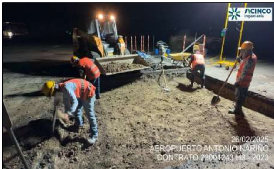
Fotografía No. 12. Excavación y retiro de material para bacheo en la plataforma del aeropuerto.
