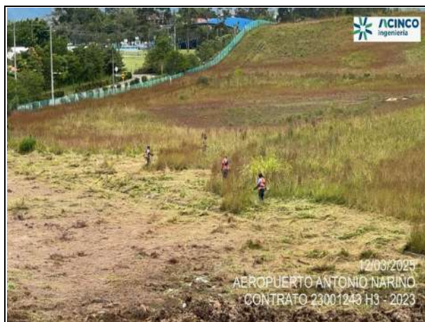
Fot. No. 1 - Rocería manual sector nor occidental del aeropuerto.
