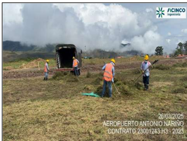
Fot. No. 2 - Recolección de material vegetal producto de la rocería para disposición final en el sitio autorizado.
