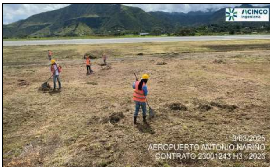
Fotografía No. 2. Recolección de material vegetal proveniente de la rocería para disponer en sitio autorizado.
