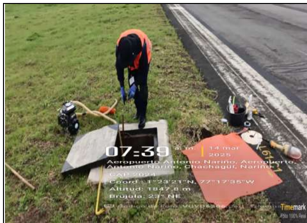
Fot. No. 6 - Mantenimiento de baliza de luces de borde de pista del sistema de ayudas visuales del aeropuerto.
