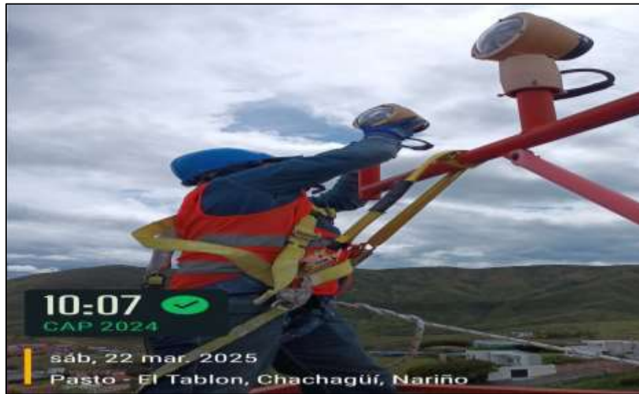
Fotografía No. 9. Puesta en funcionamiento de 2 balizas ALS elevadas, previo mantenimiento interno, cambio de bombillo y conexiones acometida en caja de inspección.
