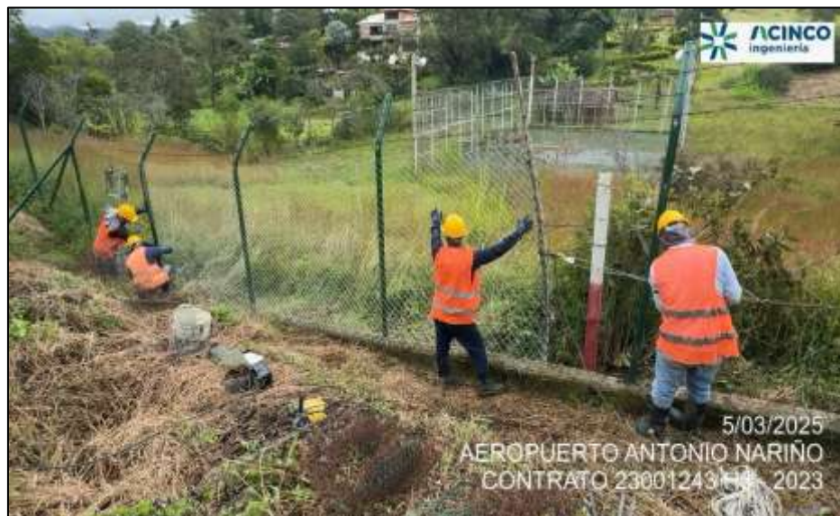
Fotografía No. 4. Reparación del cerramiento en el sector sur oriental del aeropuerto.
