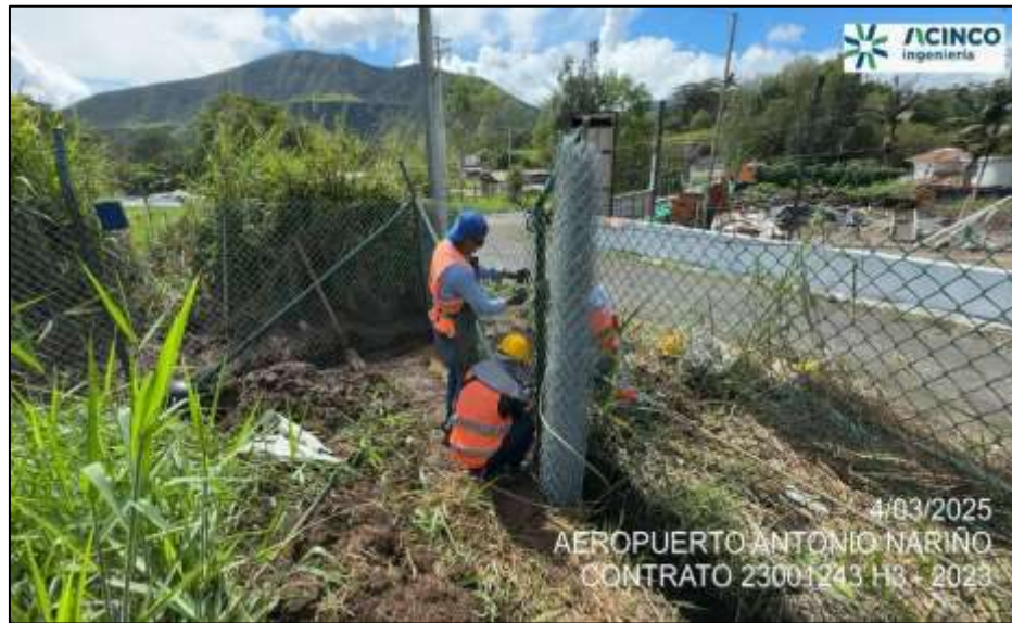
Fotografía No. 3. Reparación del cerramiento en el sector cercano a la PTAR del aeropuerto.
