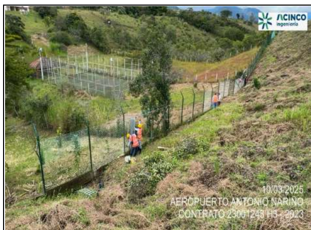
Fot. No. 3 - Reparación de cerramiento en el sector sur oriental del aeropuerto.
