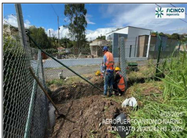
Fot. No. 3 - Reparación de cerramiento en el sector cerca a la PTAR del aeropuerto.
