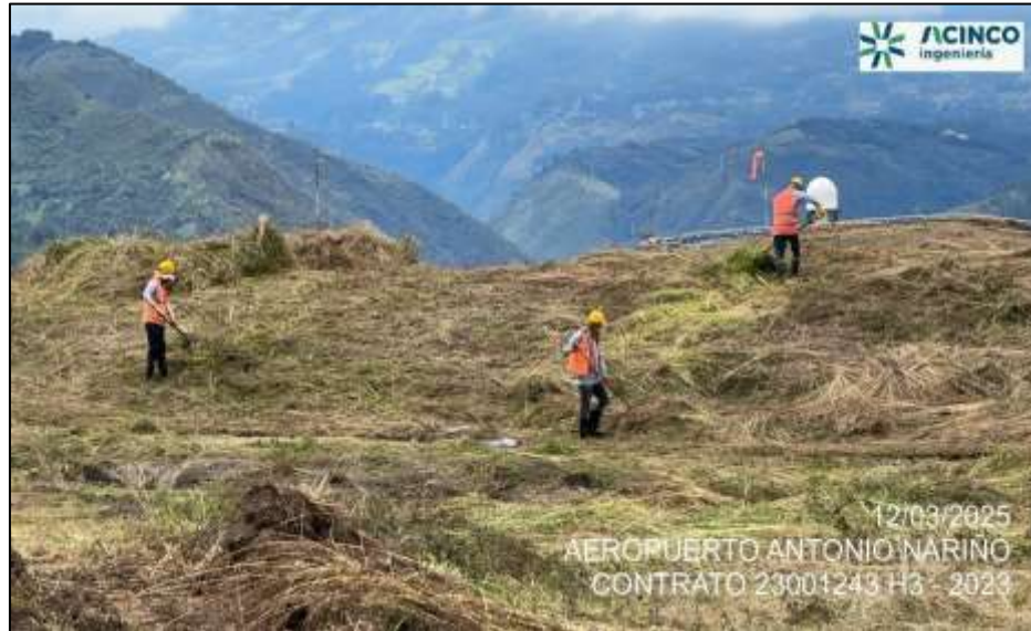
Fotografía No. 5. Recolección de material vegetal proveniente de la rocería para disponer en sitio autorizado.
