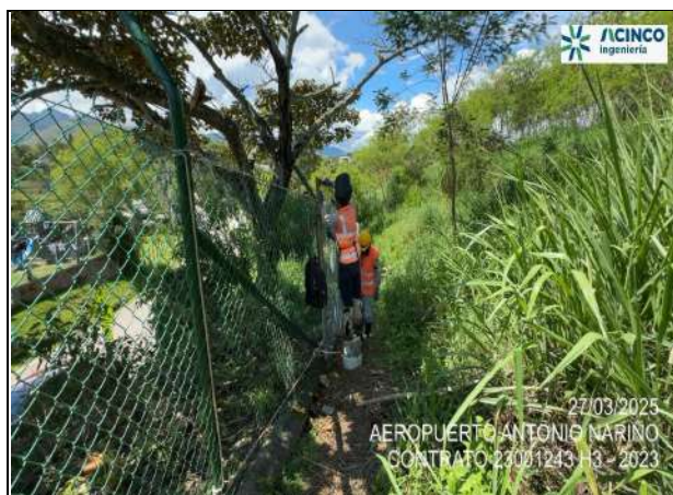
Fot. No. 4 - Reparación de cerramiento en el sector frente a la PTAR del aeropuerto.
