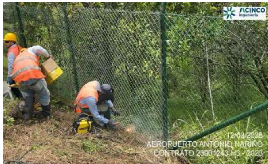
Fotografía No. 8. Reparación del cerramiento en el sector sur oriental del aeropuerto
