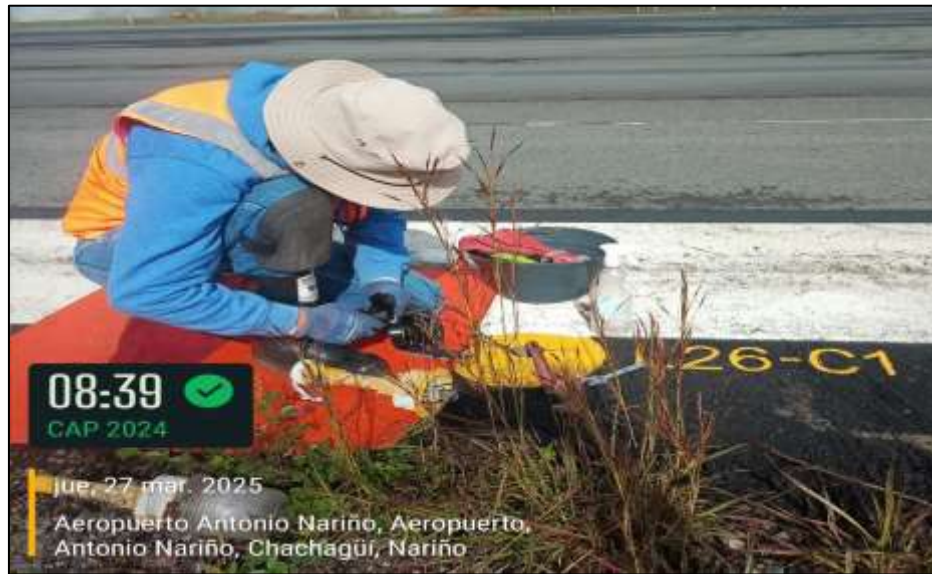
Fotografía No. 11. Mantenimiento balizas de luces de borde de pista del aeropuerto.
