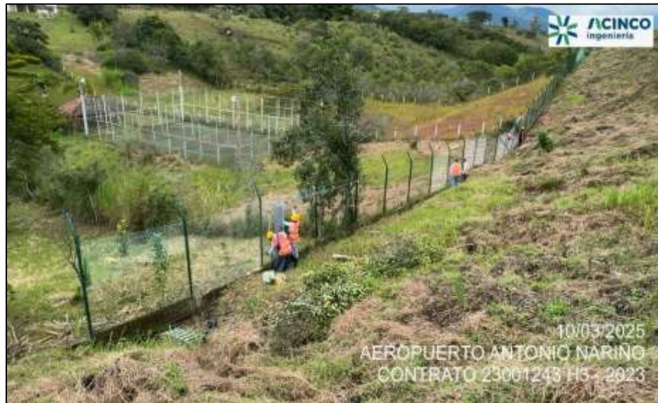
Fotografía No. 7. Reparación del cerramiento en el sector sur oriental del aeropuerto.
