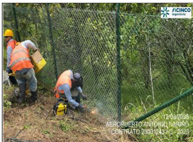
Fot. No. 4 - Reparación de cerramiento en el sector sur oriental del aeropuerto.
