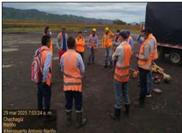
Fot. No. 5 - Charla de seguridad diaria de 5 minutos a todo el personal de obra.
