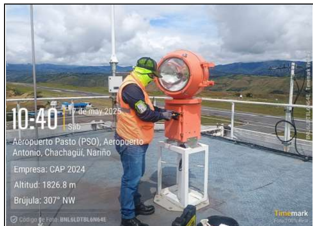
Fot. No. 4 - Mantenimiento faro giratorio ubicado en la torre de control del aeropuerto.
