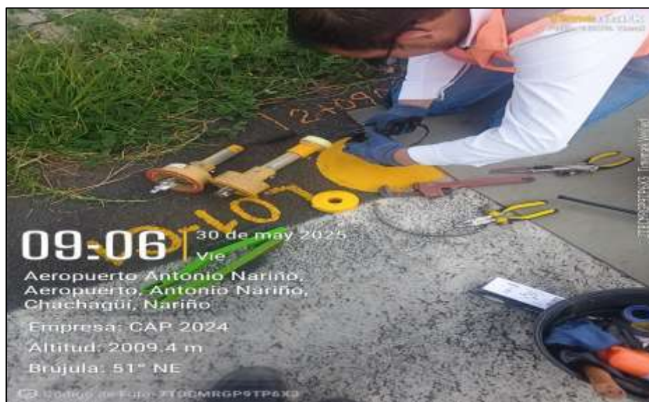
Fotografía No. 12. Mantenimiento baliza de luces de borde de pista del aeropuerto.
