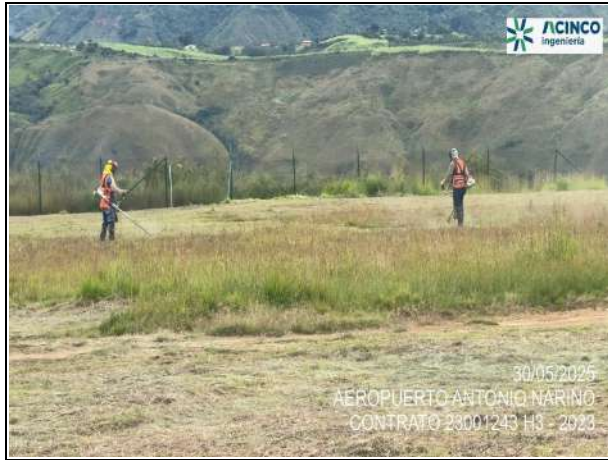
Fot. No. 1 - Rocería manual en el sector sur cabecera 0-2 del aeropuerto.
