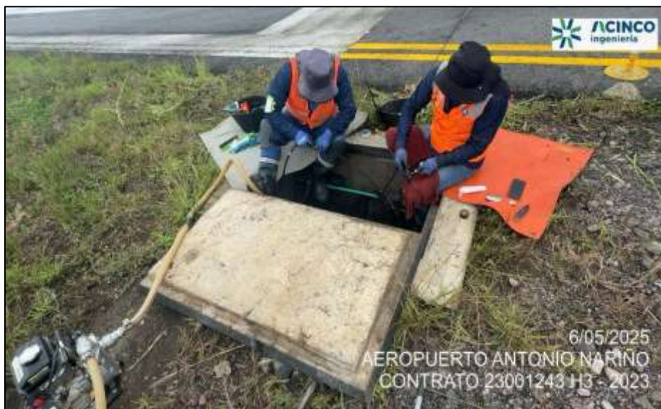
Fotografía No. 4. Mantenimiento cajas de inspección luces viraje cabecera 0-2 del aeropuerto.
