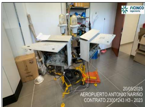
Fot. No. 4 - Mantenimiento luces REIL umbral 2-0 aeropuerto.
