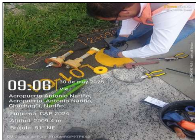
Fot. No. 6 - Mantenimiento baliza de luces de borde de pista del aeropuerto.
