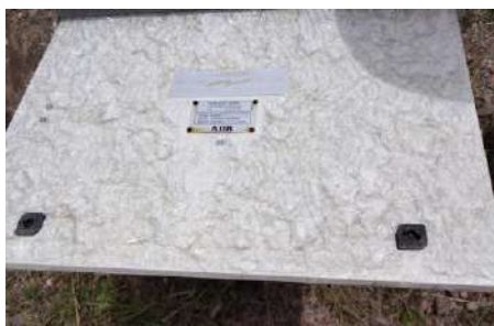
Figura 13 Estado de sistema REIL Fuente: Propia
