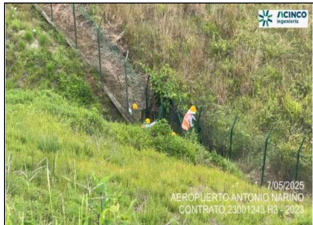
Fot. No. 4 - Mantenimiento de cerramiento en el sector norte del aeropuerto.
