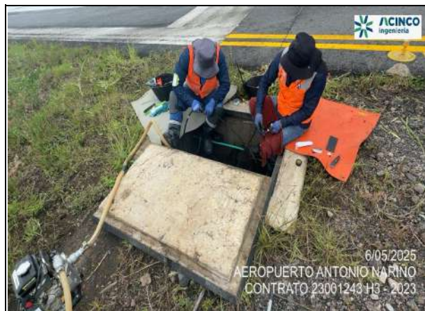
Fot. No. 5 - Mantenimiento cajas de inspección luces viraje cabecera 0-2 del aeropuerto.
