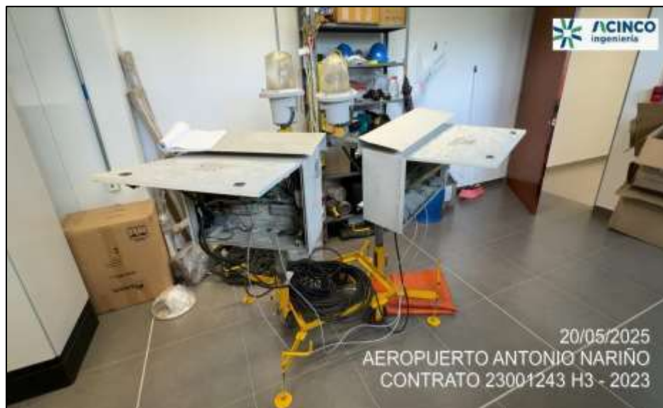
Fotografía No. 8. Mantenimiento luces REIL umbral 2-0 aeropuerto.
