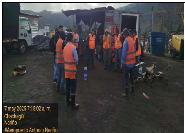
Fot. No. 6 - Charla de seguridad diaria de 5 minutos a todo el personal de obra.
