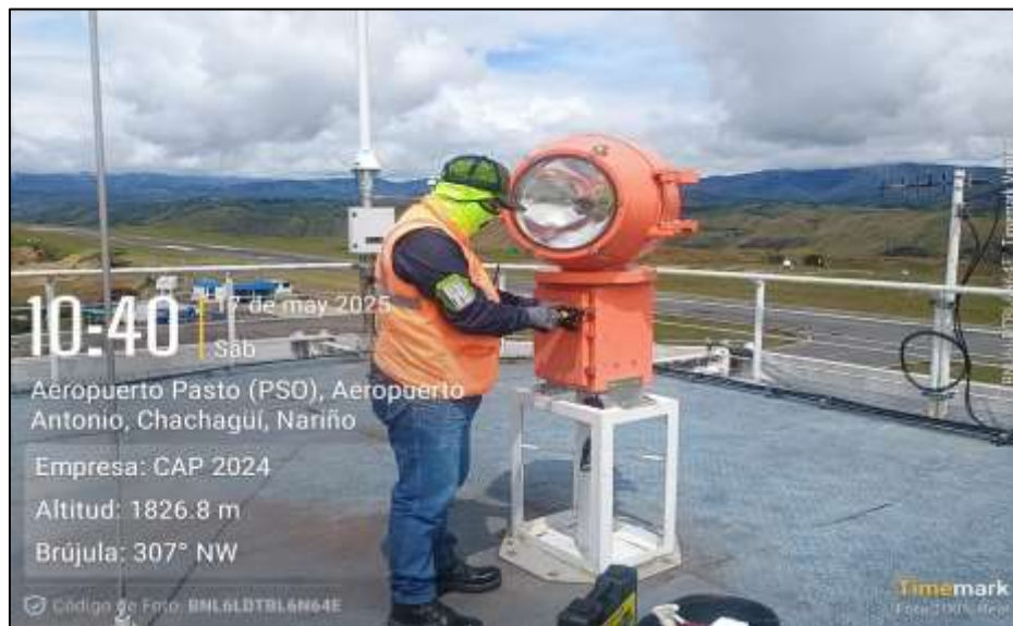
Fotografía No. 6. Mantenimiento faro giratorio ubicado en la torre de control del aeropuerto.
