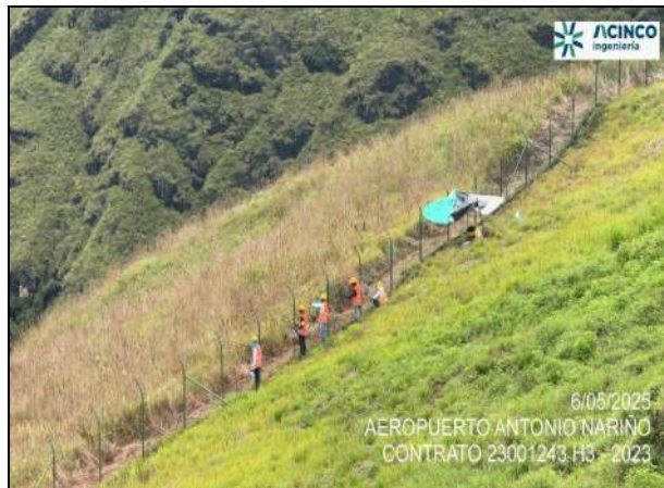
Fot. No. 3 - Mantenimiento de cerramiento en el sector sur occidental del aeropuerto.
