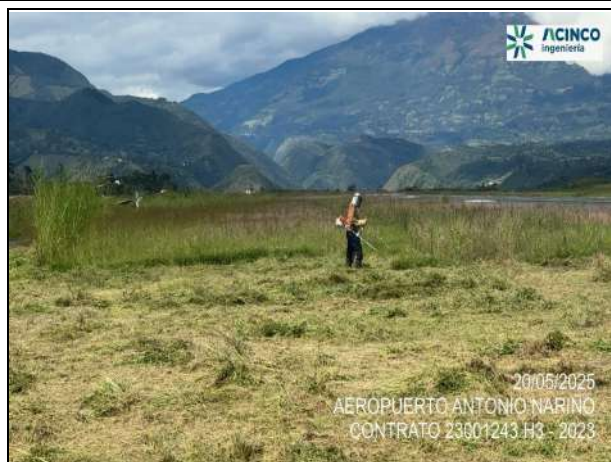
Fot. No. 1 - Rocería manual en zona restringida cabecera 0-2 del aeropuerto.
