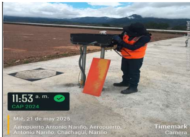
Fot. No. 6 - Mantenimiento luces PAPI umbral 2-0 del aeropuerto.
