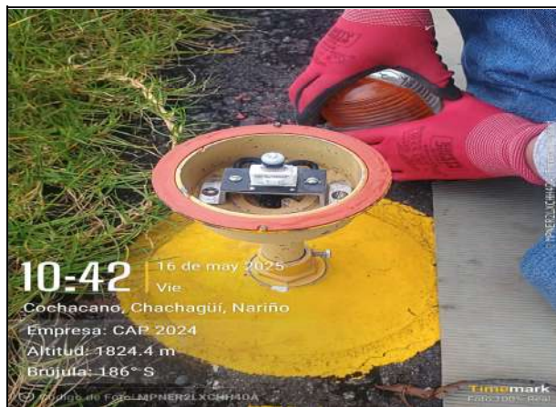
Fot. No. 5 - Mantenimiento baliza de luces de borde de pista del aeropuerto.
