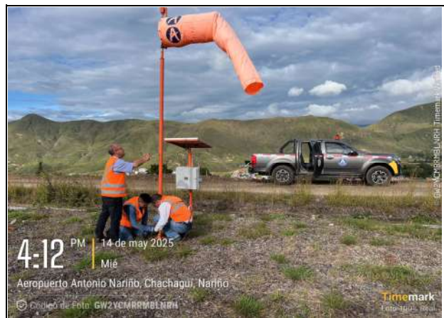
Fot. No. 6 - Mantenimiento indicador de viento umbral 2-0 del aeropuerto.
