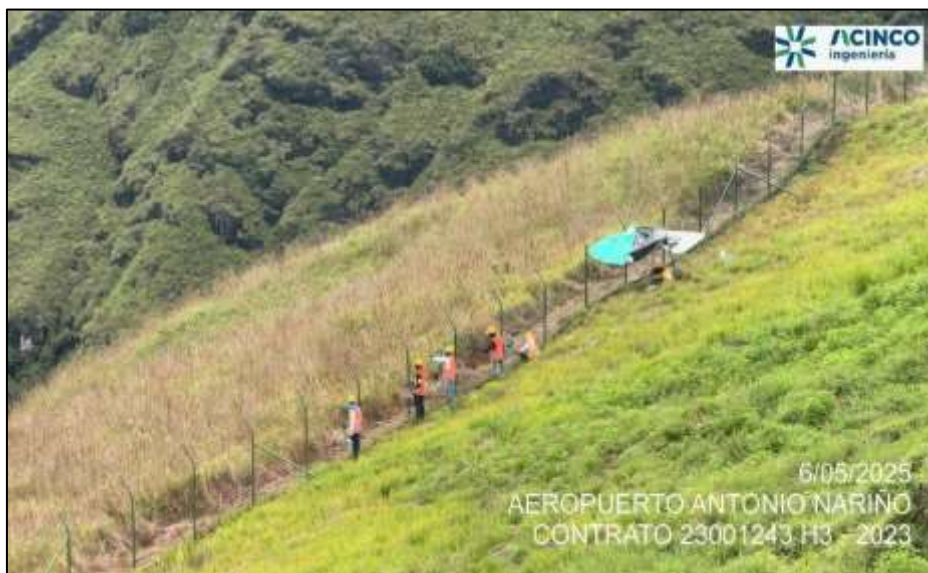
Fotografía No. 3. Mantenimiento de cerramiento en el sector sur occidental del aeropuerto.
