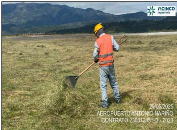
Fot. No. 3 - Recolección del material vegetal proveniente de la rocería para disponerlo en el sitio autorizado.
