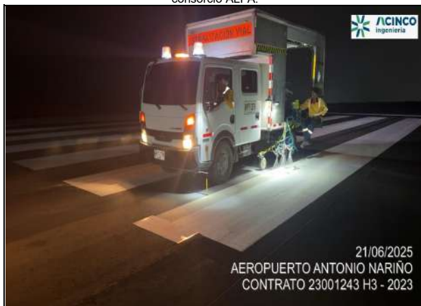
Fot. No. 6 - Demarcación de la señalización horizontal de la pista del aeropuerto.
