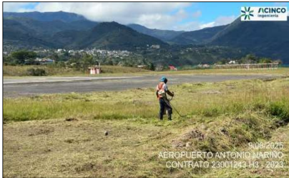
Fotografía No. 5. Rocería manual en zona restringida cabecera 0-2 del aeropuerto.
