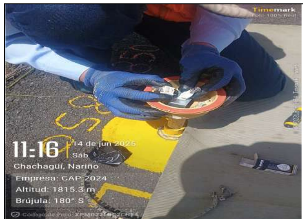
Fot. No. 4 - Mantenimiento baliza de luces de borde L10-C1 de la pista del aeropuerto.
