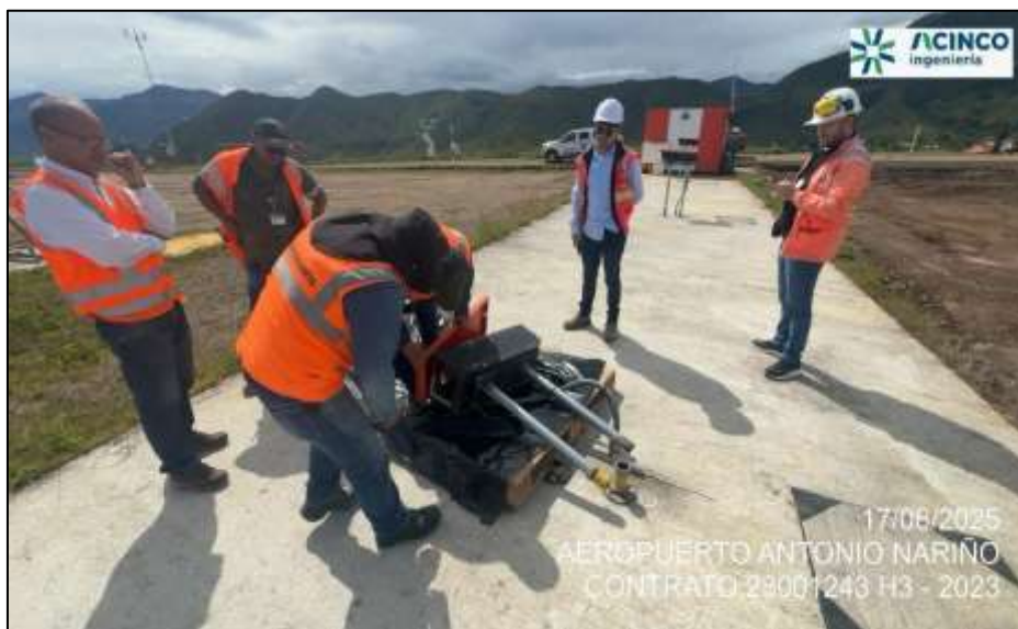
Fotografía No. 9. Revisión del estado y entrega a la entidad del módulo No. 2 de las luces PAPI umbral 2-0 del aeropuerto, después del daño ocasionado por el consorcio ALFA.
