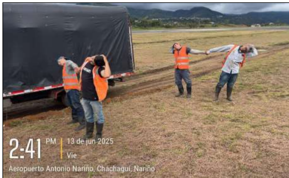
Fotografía No. 6. Pausas activas a todo el personal de obra.
