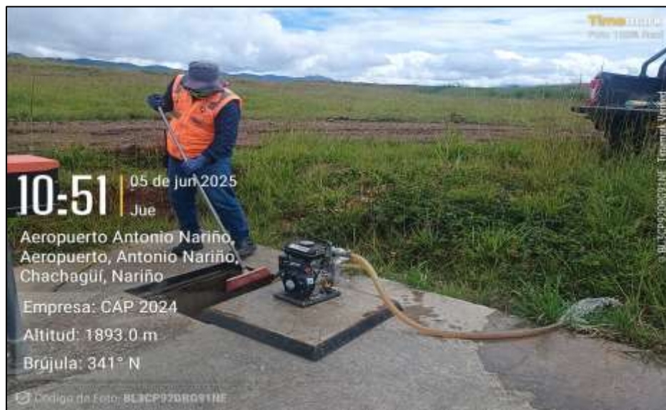
Fotografía No. 4. Mantenimiento de cajas de inspección de luces PAPI umbral 0-2 del aeropuerto.
