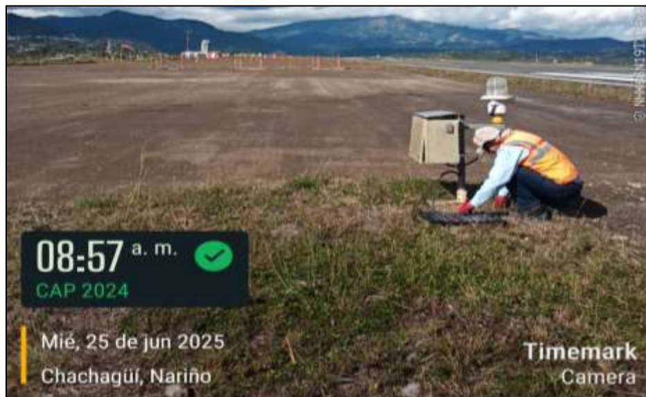
Fotografía No. 12. Mantenimiento e instalación de luces RTIL umbral 2-0 del aeropuerto.
