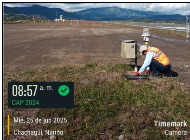
Fot. No. 3 - Mantenimiento e instalación de luces RTIL umbral 2-0 del aeropuerto.
