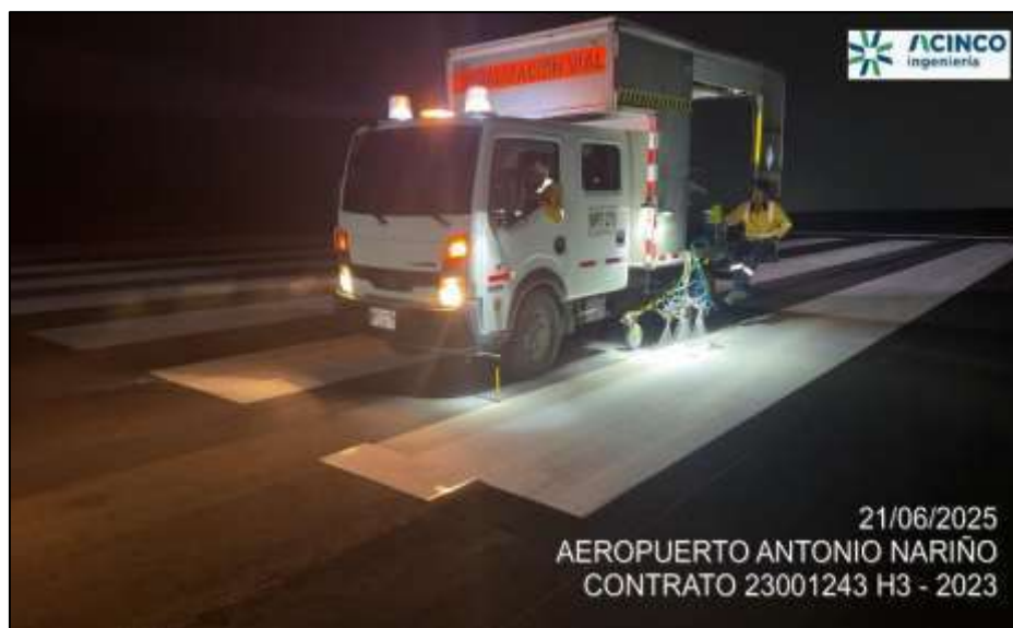
Fotografía No. 10. Demarcación de la señalización horizontal de la pista del aeropuerto.
