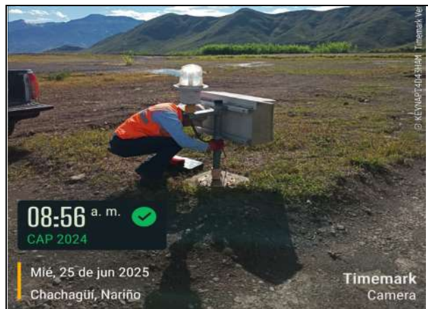
Fot. No. 4 - Mantenimiento e instalación de luces RTIL umbral 2-0 del aeropuerto.
