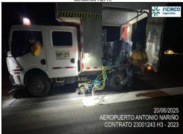
Fot. No. 5 - Demarcación de la señalización horizontal de la pista del aeropuerto.
