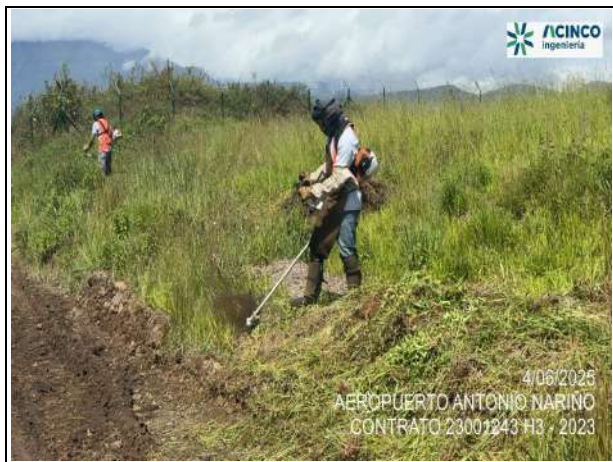
Fot. No. 1 - Rocería manual en el sector sur occidental del aeropuerto.
