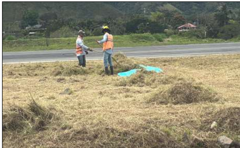
Fotografía No. 8. Recolección del material vegetal proveniente de la rocería para disponerlo en el sitio autorizado.
