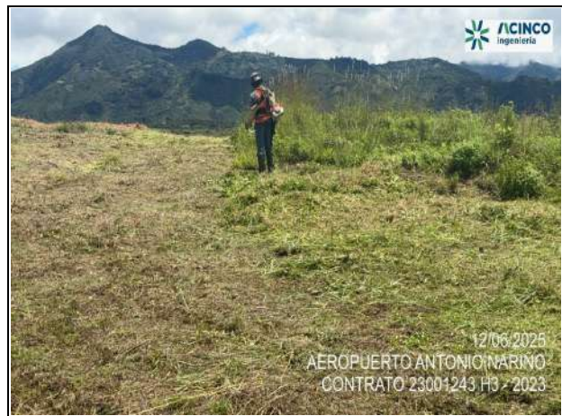
Fot. No. 2 - Rocería manual en el sector sur occidental del aeropuerto.
