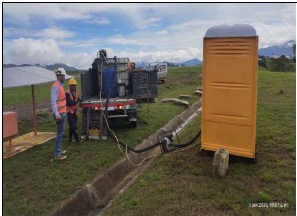
Fot. No. 5 - Mantenimiento del baño móvil del proyecto.
