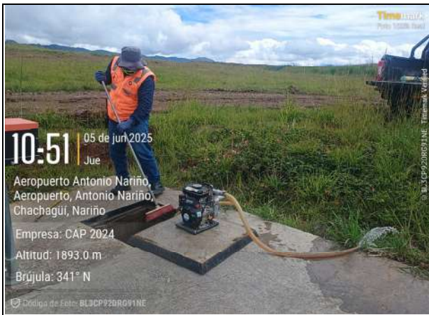
Fot. No. 4 - Mantenimiento de cajas de inspección de luces PAPI umbral 0-2 del aeropuerto.
