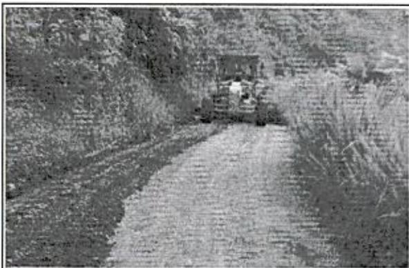
Foto 1: Mantenimiento Red Vial de Los Andes (N). Conformación de Calzada
