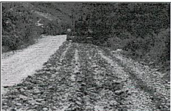
Foto 4: Mantenimiento Red Vial de Los Andes (N). Conformación de Calzada
