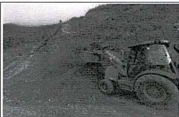
Foto 6: Mantenimiento Red Vial de Los Andes (N). Suministro Material Afirmado
