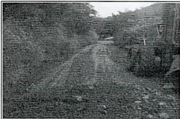
Foto 7: Mantenimiento Red Vial de Los Andes (N). Suministro Material Afirmado
