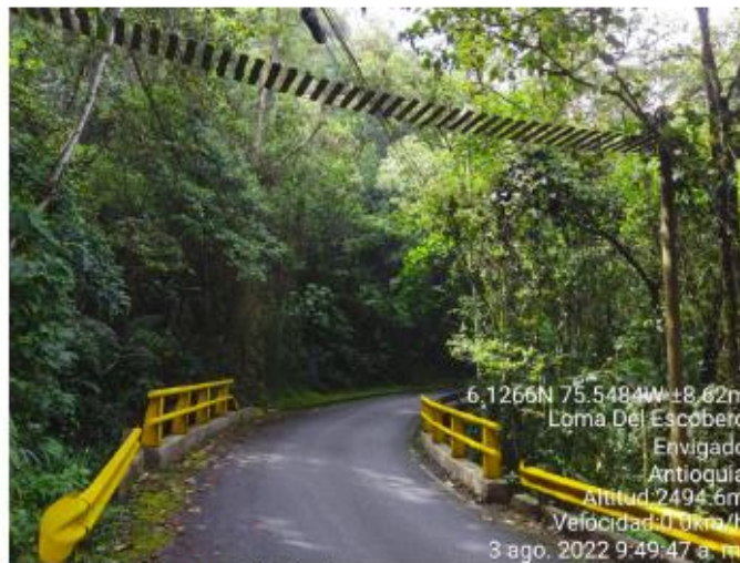
Foto 5. Paso de fauna arbóricola tipo escalenilla simple
