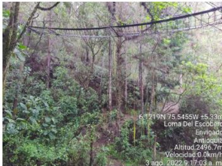
Foto 7. Paso de fauna arboricola tipo red
