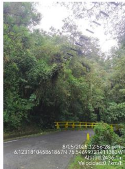
Foto 14. Ramas de individuo arbóreo que generan presión sobre escalenilla central
