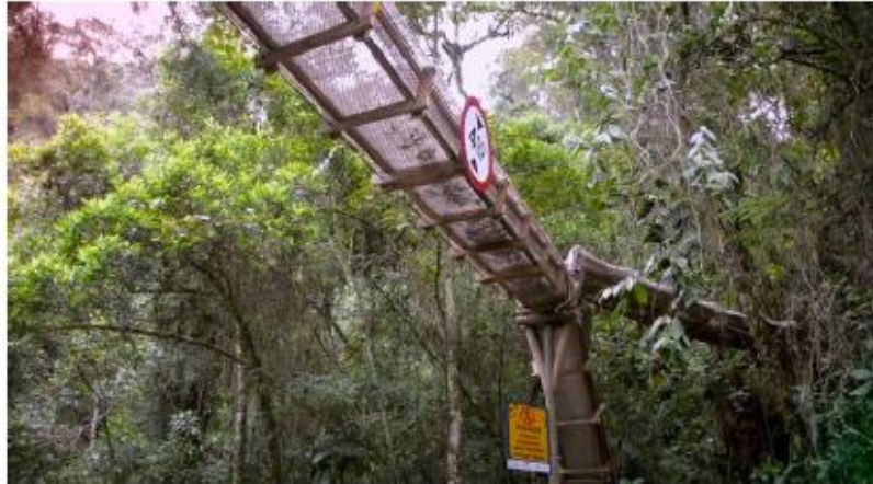
Foto 10. Paso de fauna arborícola tipo cajón
