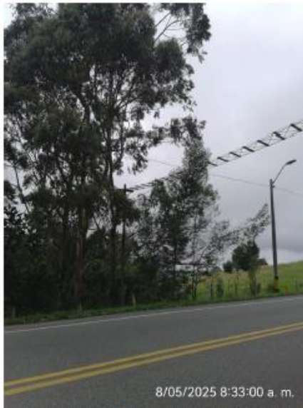
Foto 12. Paso de fauna arboricola objeto de intervención mediante el cambio de escalenilla
