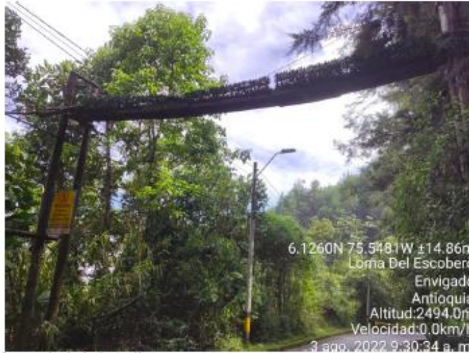
Foto 8. Paso de fauna arborícola tipo cajón
