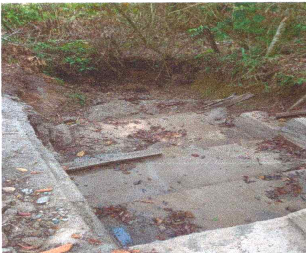
Terminación de alcantarilla con disipador vereda matajira
