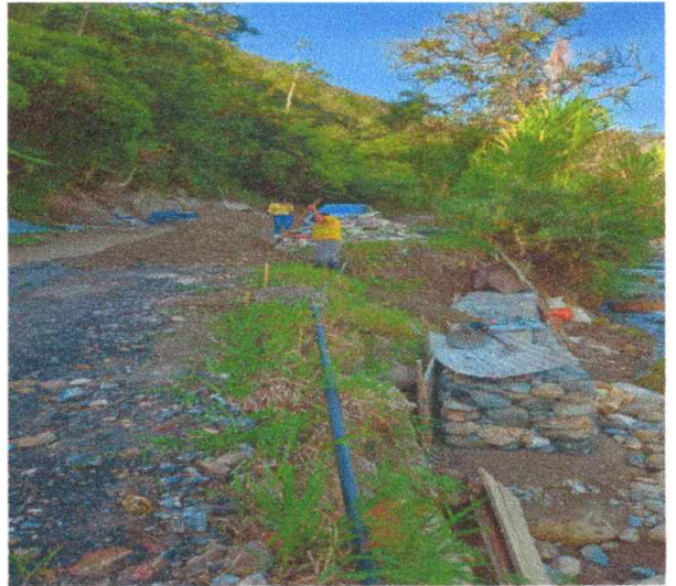
Visita técnica rehabilitación vía terciaria tescua
