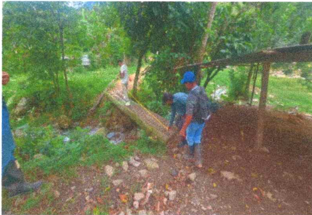
Visita técnica paso de quebrada puente peatonal
