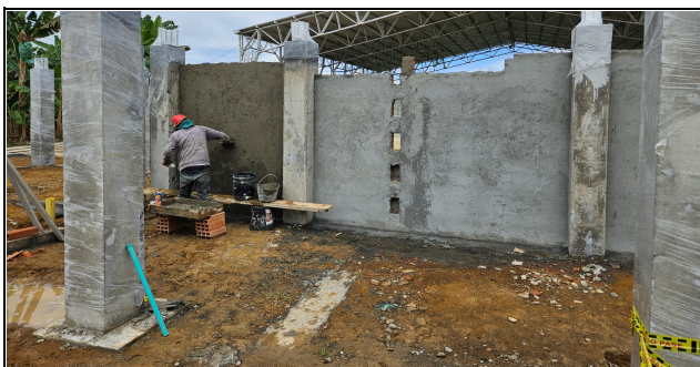
LEVANTE Y PAÑETE PARA MUROS INTERNOS ALISTADO PARA PEGA DE ENCHAPE
