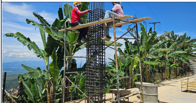
ARMADO DE COLUMNA DE TEATRINO
