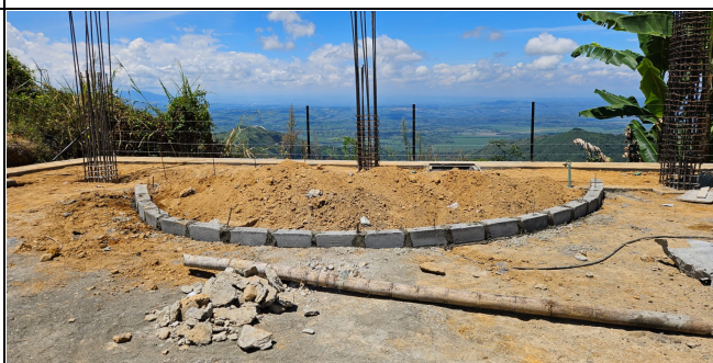
LEVANTE DE MURO EN BLOQUE ESTRUCTURAL PARA TEATRINO
