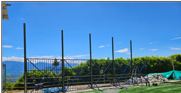
INSTALACION DE CERRAMIENTO PERIMETRAL CANCHA
