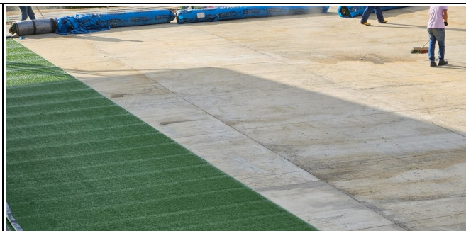
INSTALACION DE GRAMA PARA CANCHA DE FUTBOL
