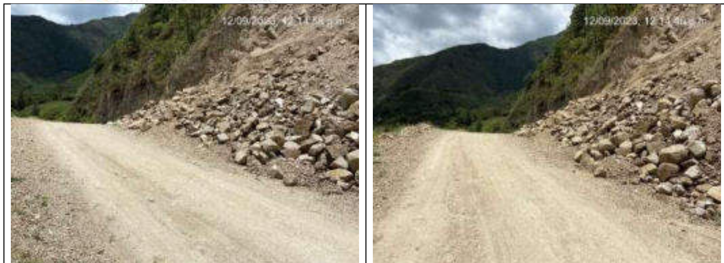
Vía 3702 PR26+0900 margen derecha.
