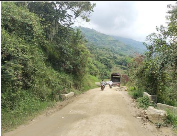
PR 0+0612 alcantarilla (terminada)
