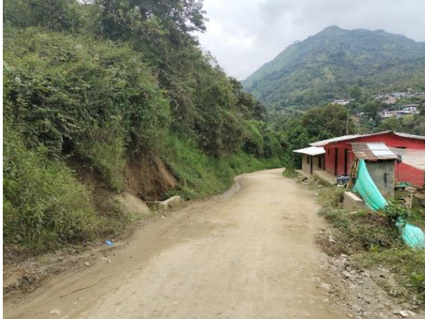
PR 0+0800 alcantarilla (terminada)
