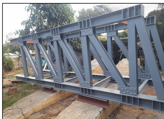
PR 18+0500 Peatonal - pintura de la estructura metálica (en construcción – suspendido)
