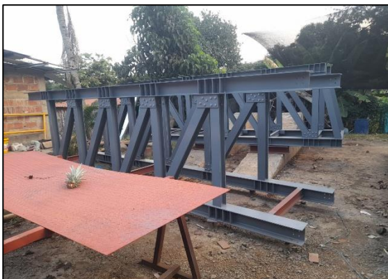
PR 18+0500 Peatonal - pintura de la estructura metálica (en construcción – suspendido)
