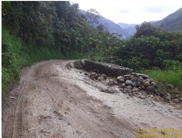
PR 0+0900 Muro en Gaviones (en construcción)
