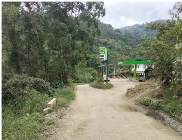
PR 0+0350 alcantarilla (terminada)
