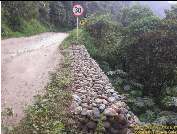
PR 0+0950 Muro en Gaviones (en construcción)
