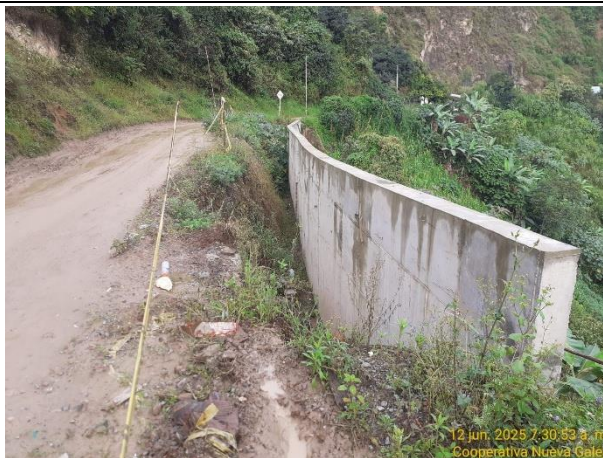
PR 1+0100 Muro de Contención (en construcción)
