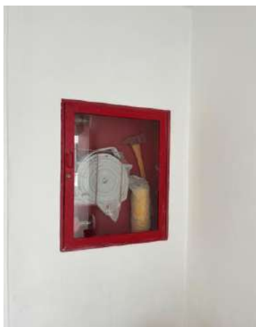
Instalación de vidrios
