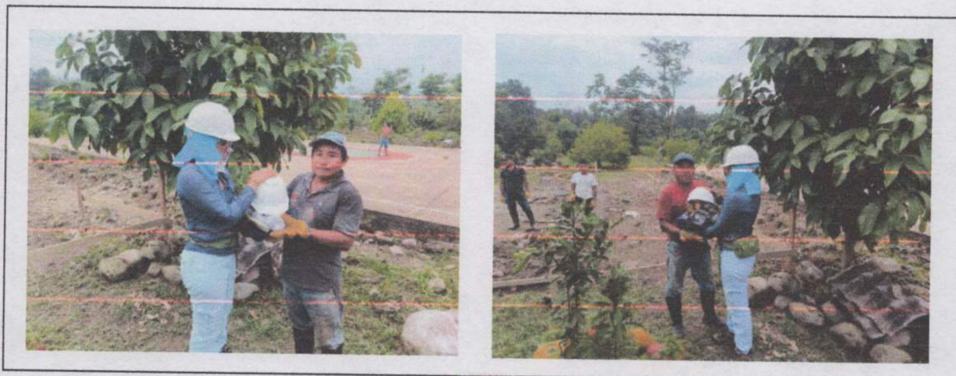
Ilustración 3. Uso de EPP durante ejecución de la obra
