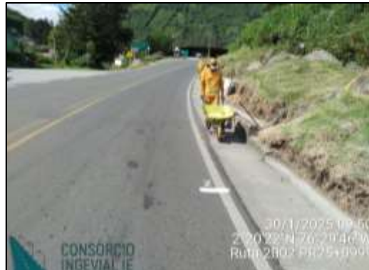
Seguimiento de las actividades ejecutadas por las cooperativas
