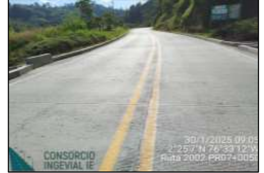
PR01+0300, PR05+0850 y PR07+0050 Pavimento en buen estado, contrato 1006 de 2021. Falta de señalización vertical.
