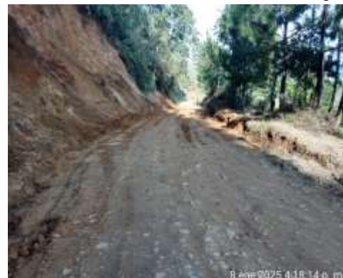
PR08+0200 Retiro de derrumbe.
