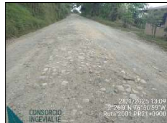
PR11+0500 y PR21+0900, sectores con baches y cabezas duras
