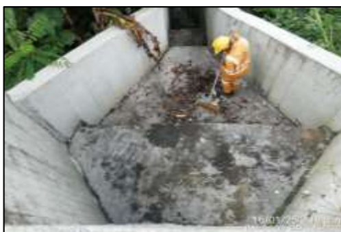
DURANTE PR12+0800 Limpieza de Box Coulvert, incluye encole y descole.
