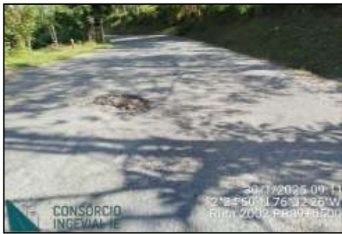
PR08+0750, PR09+0500 y PR10+0600 Tramos con pavimento flexible en mal estado con deficiencia de señalización vial.
