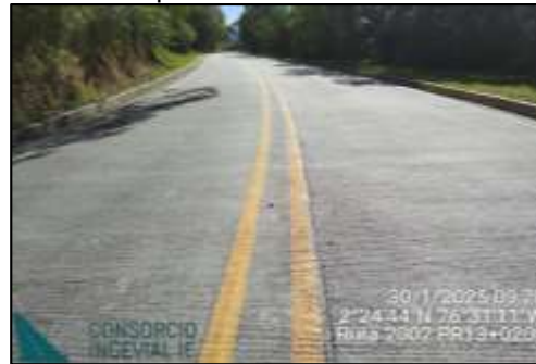
PR2+0000, PR13+0200 y PR15+0550 Pavimento en buen estado, contrato N°1006 de 2021. Falta de señalización vertical.
