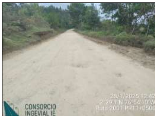
PR11+0500 y PR21+0900, sectores con baches y cabezas duras
