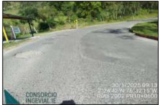
PR08+0750, PR09+0500 y PR10+0600 Tramos con pavimento flexible en mal estado con deficiencia de señalización vial.
