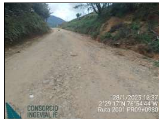
PR07+0600 y PR09+0980, sectores con baches y cabezas duras
