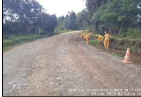
DURANTE PR10+0500 Limpieza de cuneta.
