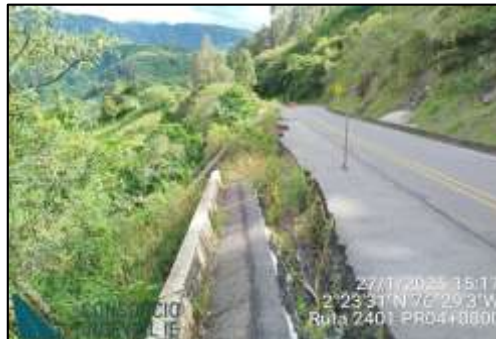
PR04+0800 Punto crítico, talud inferior inestable
