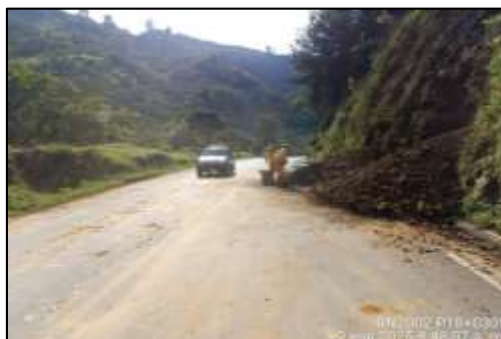
DURANTE PR18+0300 Remoción de derrumbe.
