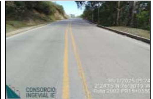
PR2+0000, PR13+0200 y PR15+0550 Pavimento en buen estado, contrato N°1006 de 2021. Falta de señalización vertical.
