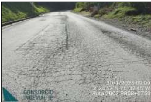
PR08+0750, PR09+0500 y PR10+0600 Tramos con pavimento flexible en mal estado con deficiencia de señalización vial.
