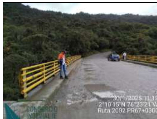
Inspección ocular a los daños en la calzada
