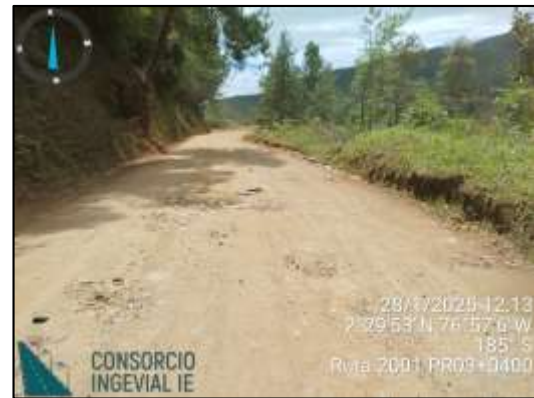
PR00+0256 y PR03+0400, sectores con baches y cabezas duras
