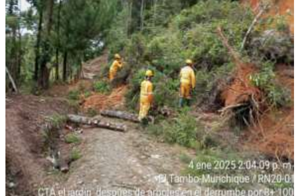
Atención inicial: Retiro de material vegetal.
