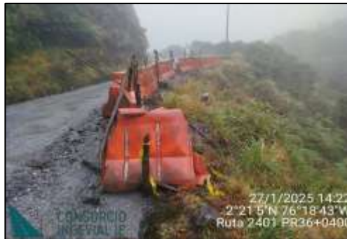
PR22+0000, PR36+0400, PR70+0200 Sitios críticos por inestabilidad del talud inferior.
