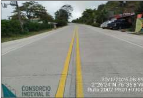
PR01+0300, PR05+0850 y PR07+0050 Pavimento en buen estado, contrato 1006 de 2021. Falta de señalización vertical.
