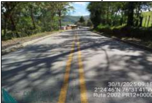
PR2+0000, PR13+0200 y PR15+0550 Pavimento en buen estado, contrato N°1006 de 2021. Falta de señalización vertical.
