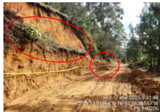
PR08+0200 Retiro de derrumbe.
