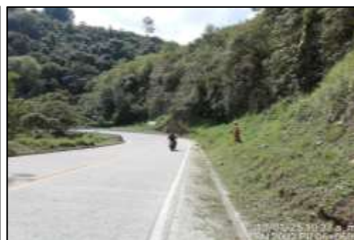
DURANTE PR06+0600 Rocería y desmonte manual.
