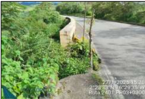
PR03+0300 Punto crítico, talud inferior inestable
