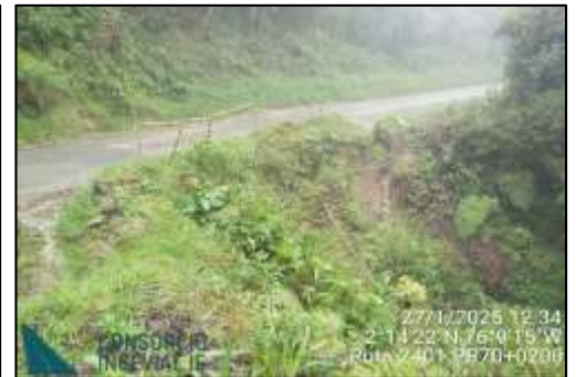
PR22+0000, PR36+0400, PR70+0200 Sitios críticos por inestabilidad del talud inferior.
