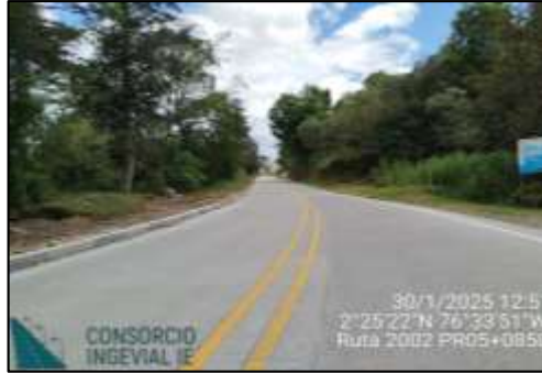
PR01+0300, PR05+0850 y PR07+0050 Pavimento en buen estado, contrato 1006 de 2021. Falta de señalización vertical.
