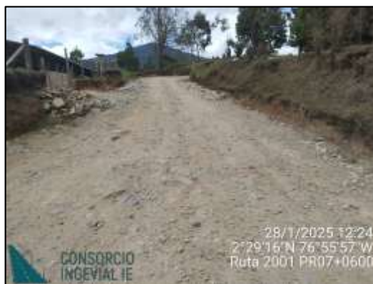
PR07+0600 y PR09+0980, sectores con baches y cabezas duras
