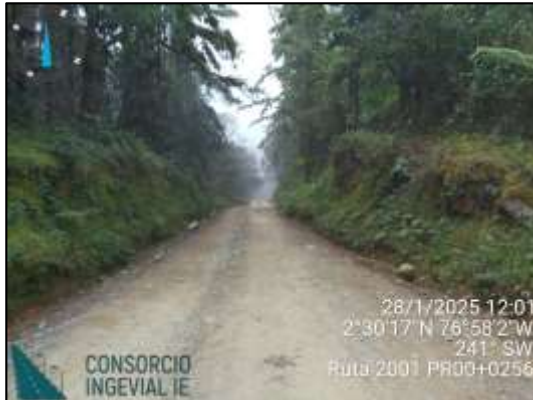
PR00+0256 y PR03+0400, sectores con baches y cabezas duras
