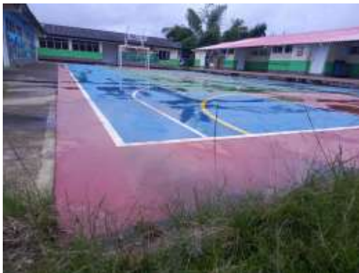
Vista general de la placa intervenida.
