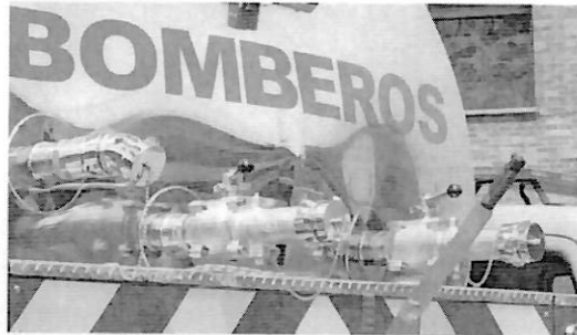
FOTO REFERENCIA VALAVULA DE LLENADO DE TANQUE
