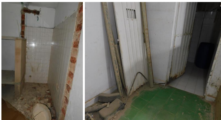
ESTADO ACTUAL DE BAÑOS PASILLO EXPENDIO
