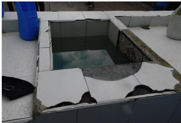
ESTADO ACTUAL DE PATIOS PABELLONES 1 Y 2
