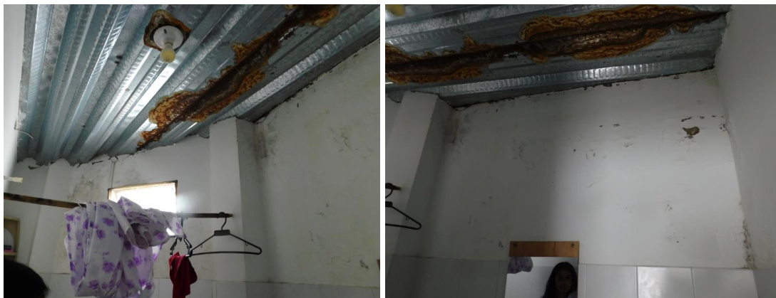
ESTADO ACTUAL BAÑO ALOJAMIENTO DE CONTROL DE GUARDIA
