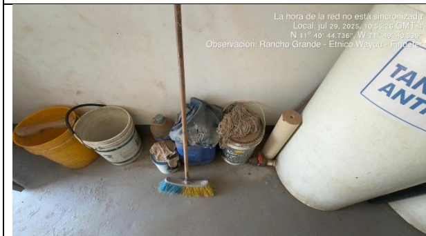
Fotografía 3. Componentes del sistema en buenas condiciones, insumos químicos en la comunidad de Rancho Grande.
