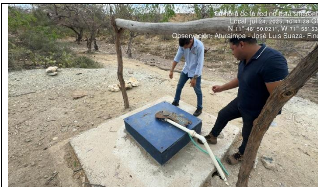
Fotografía 3. Revisión de pozo artesanal en la comunidad de Aturaimpa.
