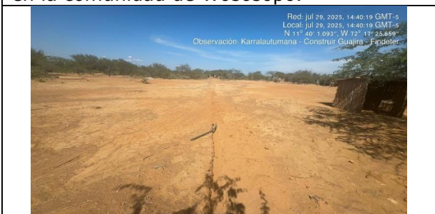
Fotografía 9. Excavación, instalación y lleno con material de sitio de manguera que trae agua potable al bebedero del colegio de la comunidad de Karralautumana.
