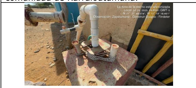
Fotografía 9. Excavación, instalación y lleno con material de sitio de manguera que trae agua potable al bebedero del colegio de la comunidad de Karralautumana.
