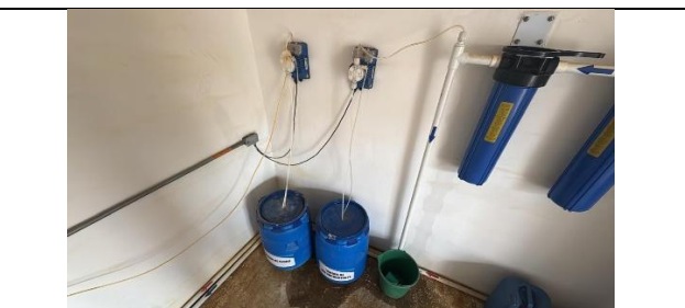
Fotografía 10. Sistema de potabilización de agua por medio de osmosis inversas en la comunidad de Zapatamana.
