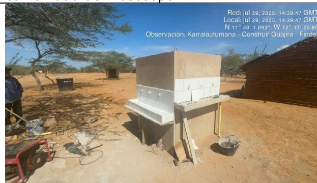
Fotografía 8. Bebedero en construcción en la comunidad de Karralautumana.
