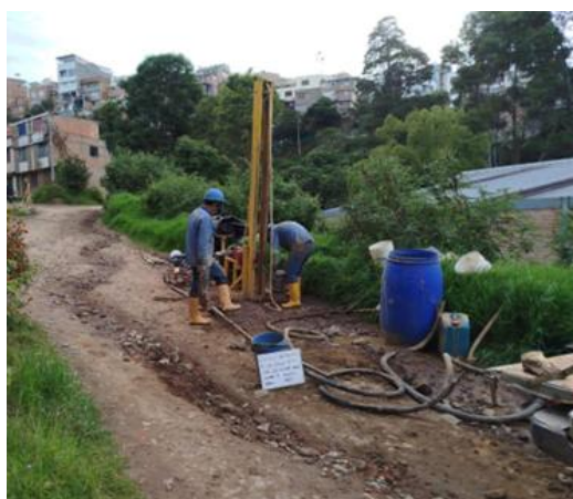
Imagen 50. Exploración geotécnica, condiciones talud corona 2.
