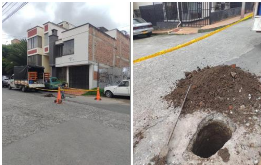
Imagen 34. Exploración geotécnica, apique.
