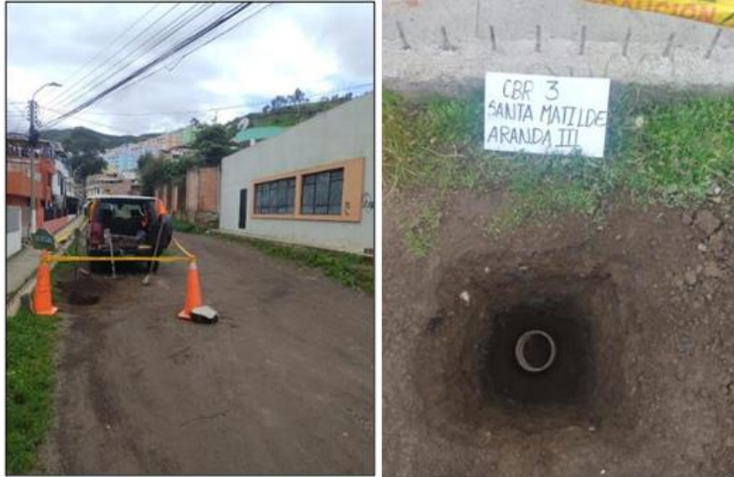
Imagen 10. Exploración geotécnica, apique.
