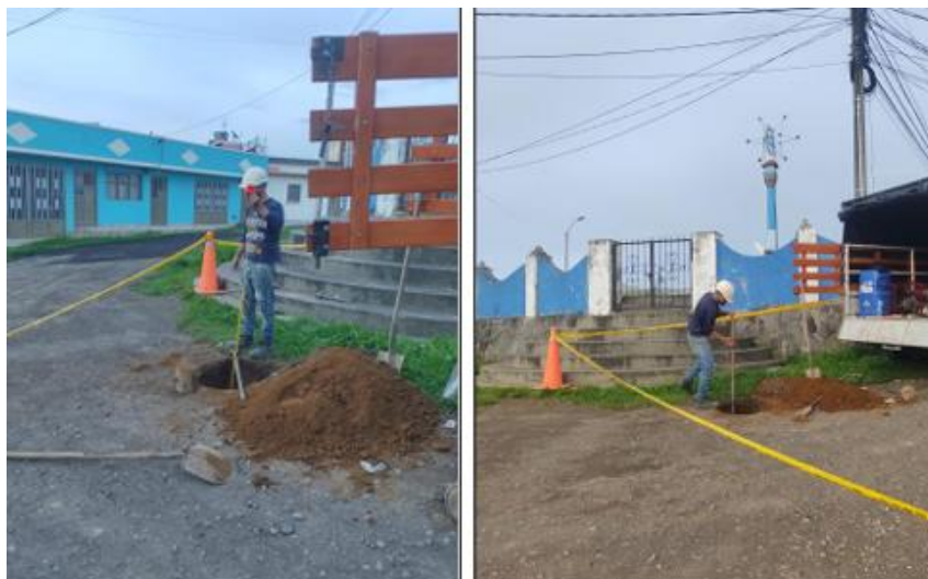
Imagen 40. Exploración geotécnica, apique.
