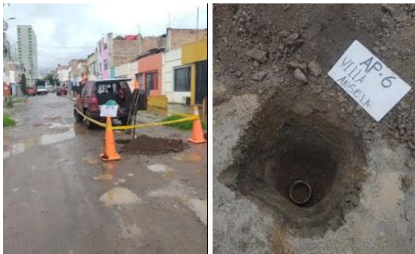
Imagen 19. Exploración geotécnica, apique.
