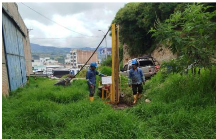
Imagen 51. Exploración geotécnica, condiciones talud pie.
