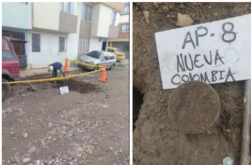
Imagen 25. Exploración geotécnica, apique.
