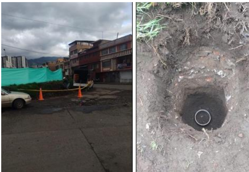
Imagen 43. Exploración geotécnica, apique.
