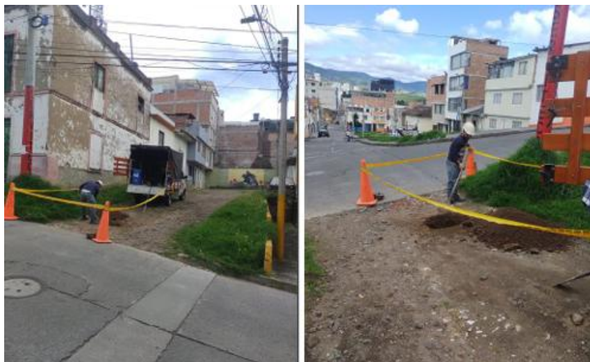
Imagen 37. Exploración geotécnica, apique.
