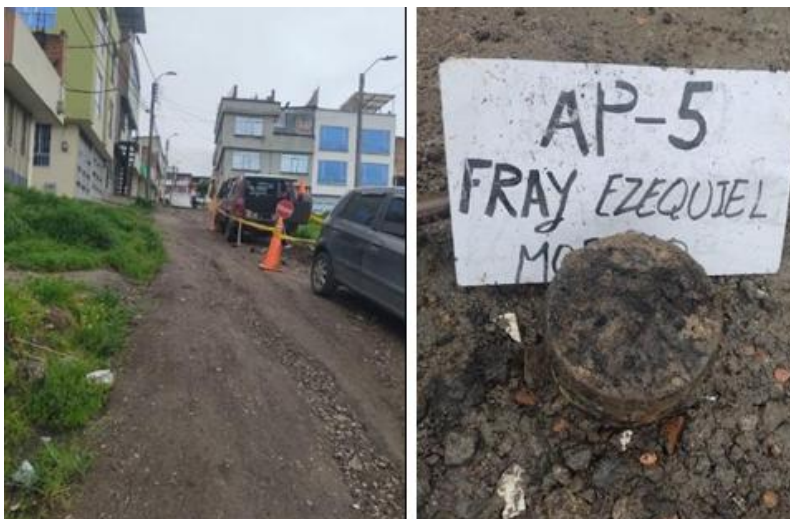
Imagen 22. Exploración geotécnica, apique.
