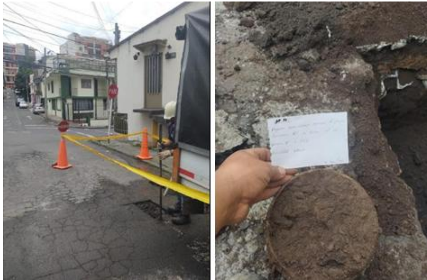
Imagen 31. Exploración geotécnica, apique.
