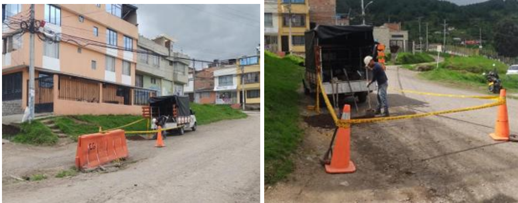
Imagen 46. Exploración geotécnica, apique.
