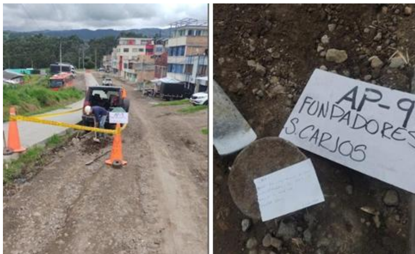
Imagen 28. Exploración geotécnica, apique.
