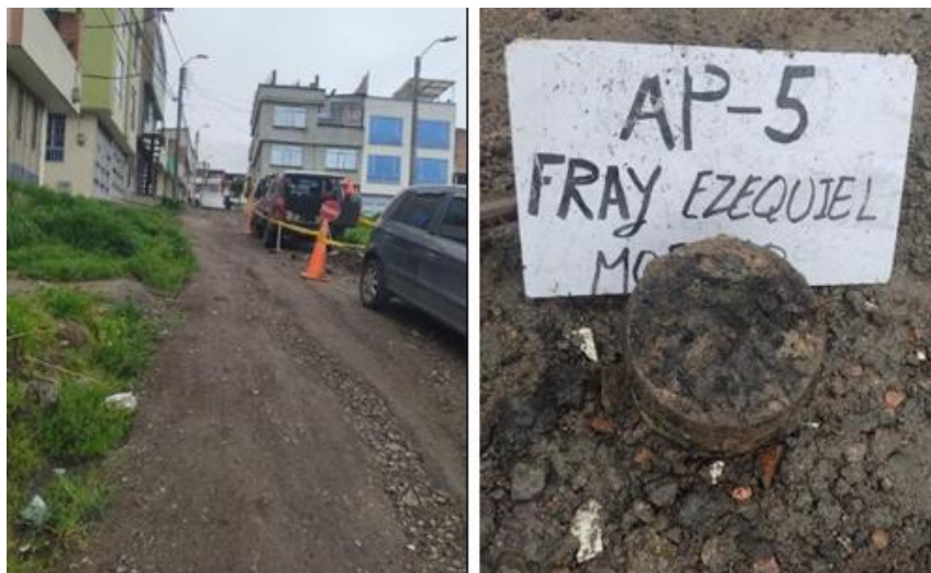
Imagen 16. Exploración geotécnica, apique.
