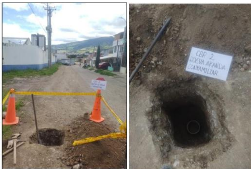
Imagen 7. Exploración geotécnica, apique.
