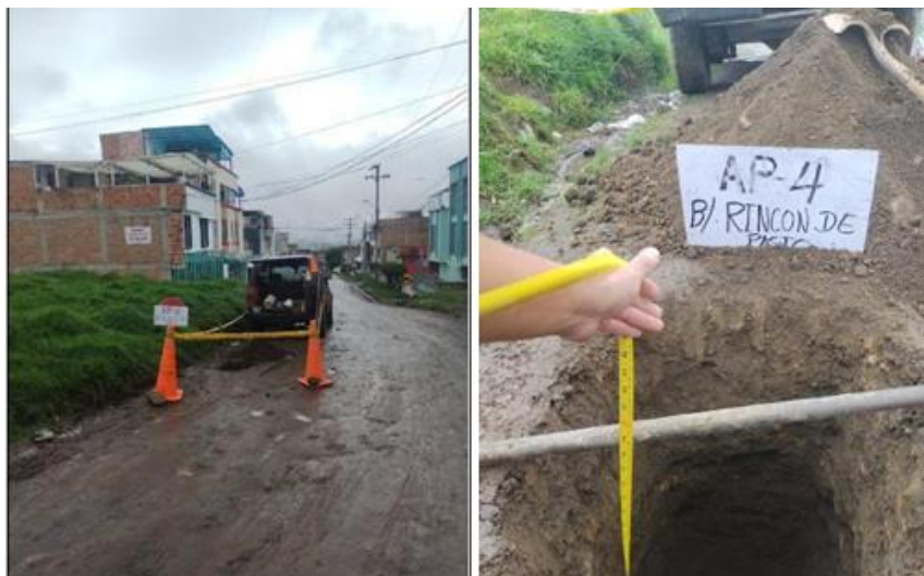
Imagen 13. Exploración geotécnica, apique.
