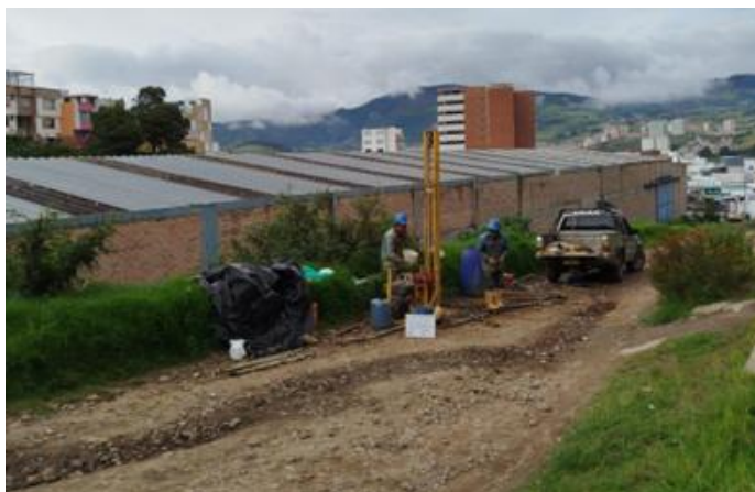
Imagen 49. Exploración geotécnica, condiciones talud corona 1.
