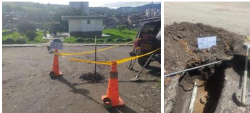
Imagen 4. Exploración geotécnica, apique.
