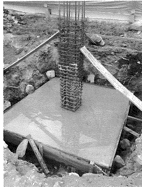
Construcción zapatas en concreto 3000 PSI – 07 al 15 de octubre del 2024.
