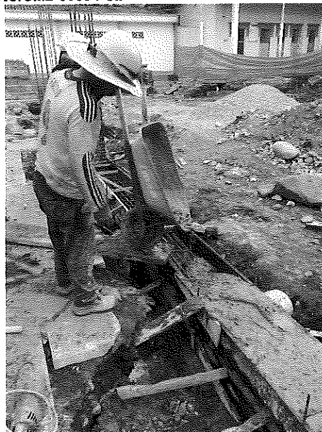
Construcción viga de cimentación - 15 al 25 de octubre del 2024.
