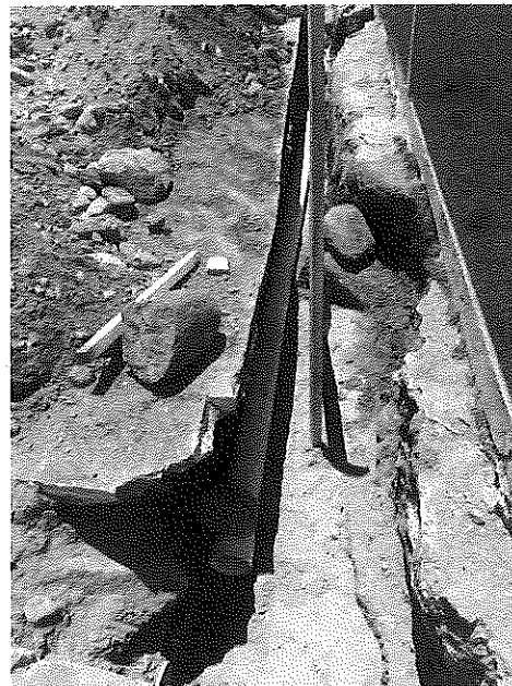
Suministro e instalación tubería PVC-S de 6" - 29 al 31 de octubre del 2024.
