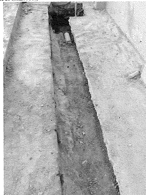
Relleno en recebo seleccionado y compactado – 01 al 31 de octubre del 2024.
