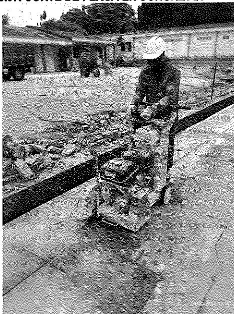
Corte de placa en concreto – 29 al 31 de octubre del 2024.
