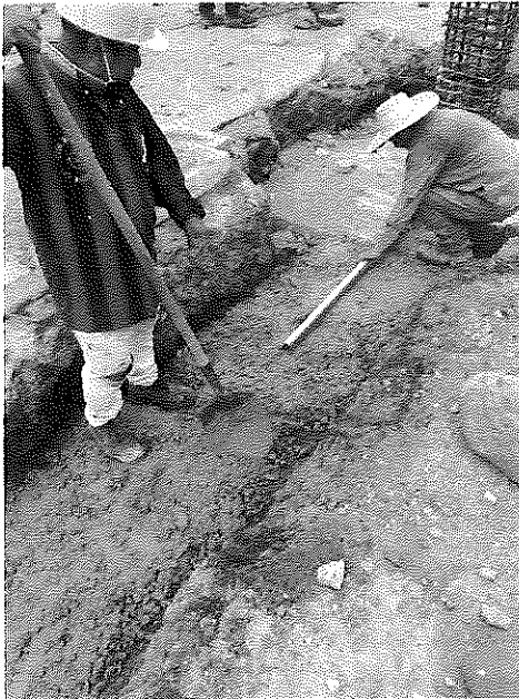
Solado en concreto de limpieza 2000 PSIS – 05 de octubre del 2024.
