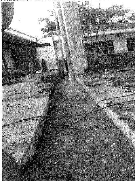
Relleno en recebo seleccionado y compactado – 01 al 31 de octubre del 2024.
