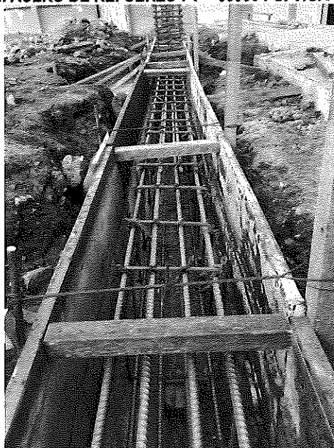
Acero de refuerzo viga de cimentación - 10 al 18 de octubre del 2024.
