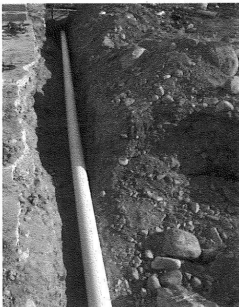
Suministro e instalación tubería PVC-S de 6" - 29 al 31 de octubre del 2024.
