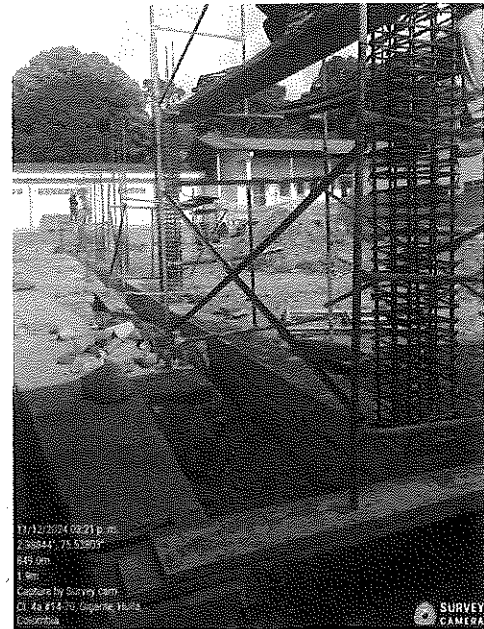
Acero de refuerzo de columnas - 15 al 29 de octubre del 2024.
