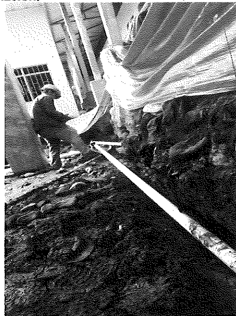
Suministro e instalación tubería de 2" - 29 al 31 de octubre del 2024.
