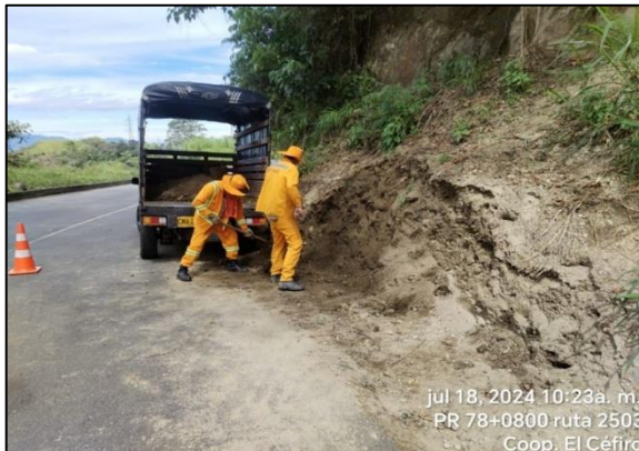
PR78+0800. Retiro de derrumbes.
