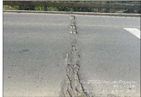
PR05+0140. Juntas del puente río Cauca deterioradas.
