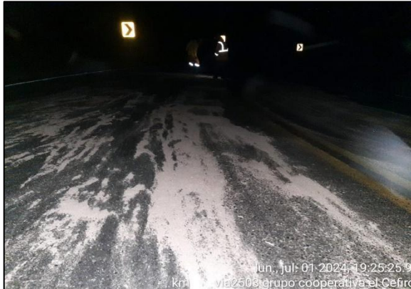
PR76+0200. Limpieza de calzada con aserrín por riego de ACPM.
