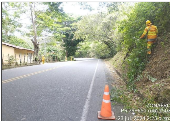
PR29+0650. Desmonte manual.
