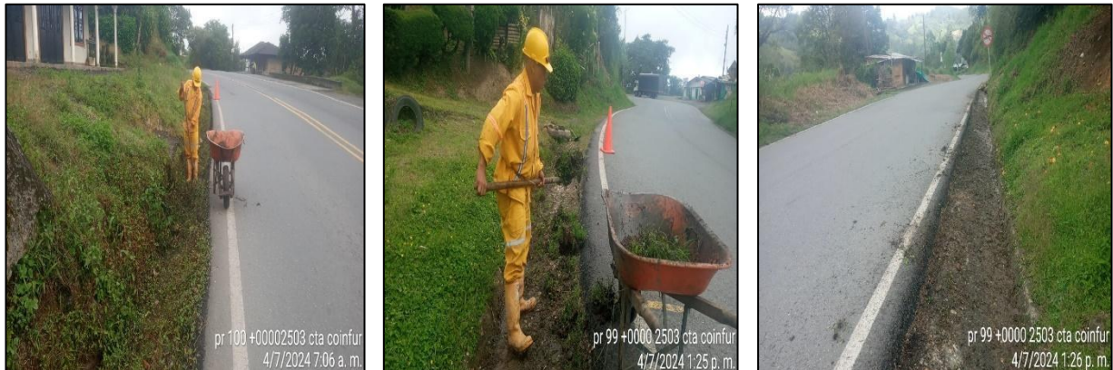
PR100+0000 y PR99+0000. Limpieza de cunetas. Antes, durante y después.
