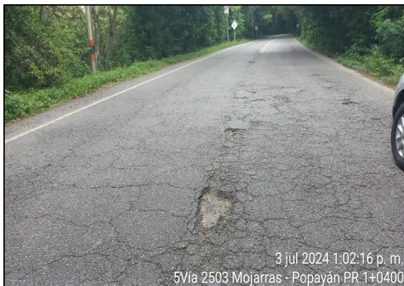
PR01+0400 y PR02+0800. Descascaramiento y piel de cocodrilo en la calzada.
