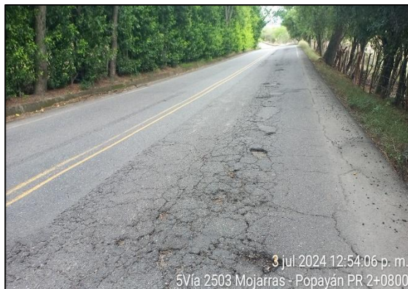
PR01+0400 y PR02+0800. Descascaramiento y piel de cocodrilo en la calzada.
