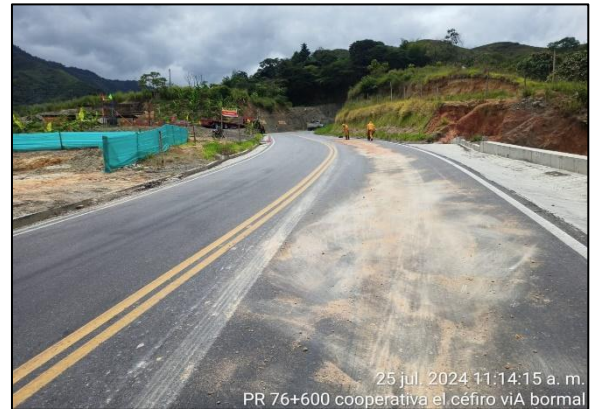
PR76+0600 a PR76+0900. Limpieza de calzada por riego de ACPM.
