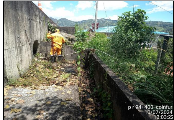
PR94+0400. Limpieza de obras.
