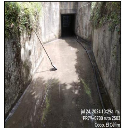
PR79+0700. Limpieza de box coulverts. Antes, durante y después.
