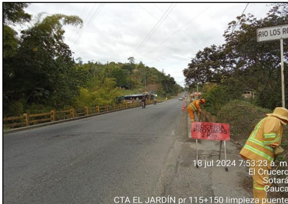
PR115+0150. Mantenimiento de puentes.
