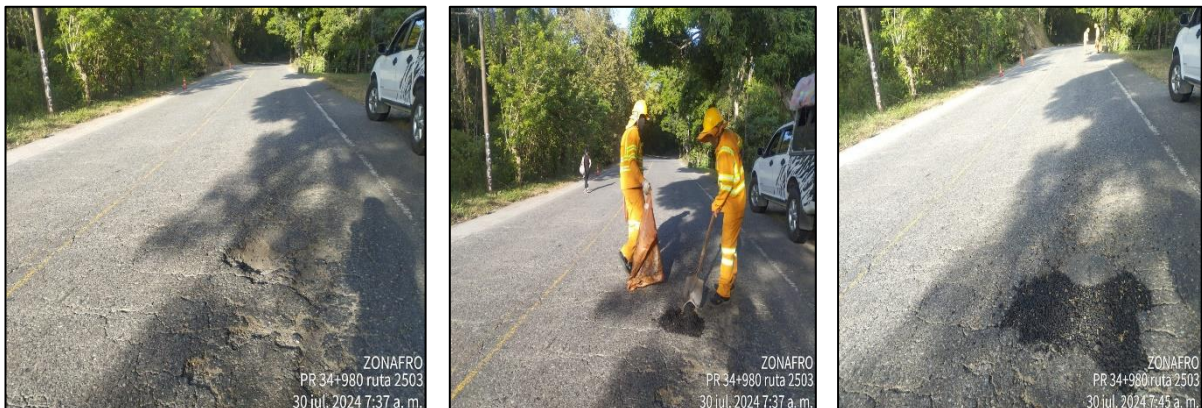
PR34+0980. Tapa huecos con mezcla asfáltica. Antes, durante y después.
