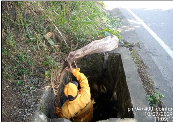
PR94+0400. Limpieza de alcantarillas.
