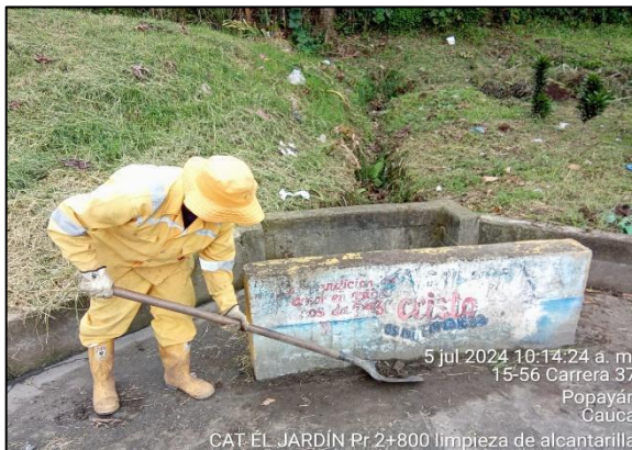
PR02+0800. Limpieza de alcantarillas.
