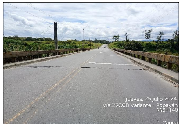
PR05+0140. Juntas del puente Río Cauca deterioradas.
