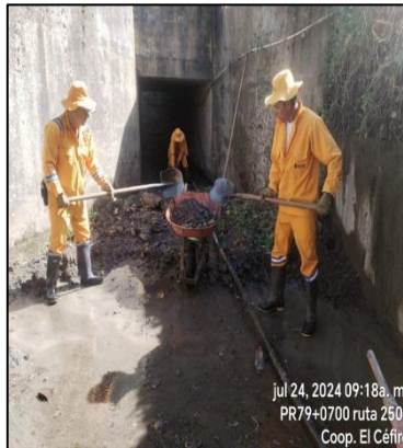
PR79+0700. Limpieza de box coulverts. Antes, durante y después.
