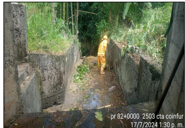
PR82+0000. Limpieza de pontones.
