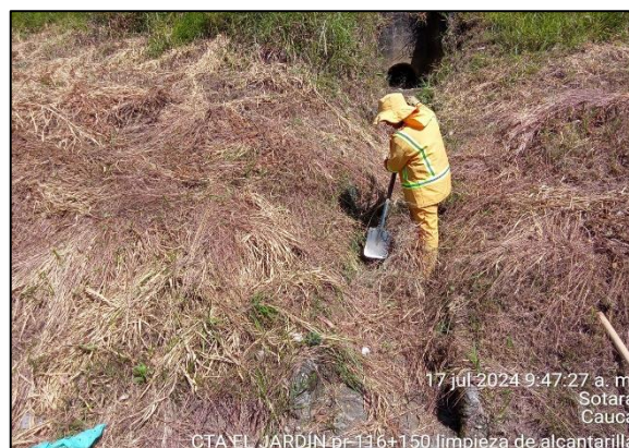
PR116+0150. Limpieza de descoles.
