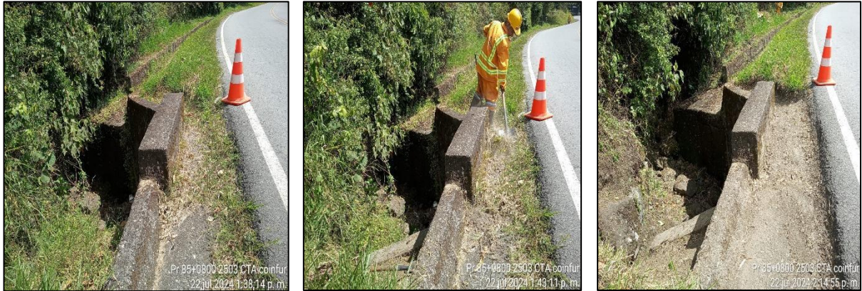
PR85+0800. Limpieza de alcantarillas. Antes, durante y después.
