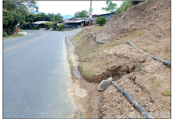
PR77+0540 y PR78+0625. Tubería instalada en Zona de Derecho de Vía.
