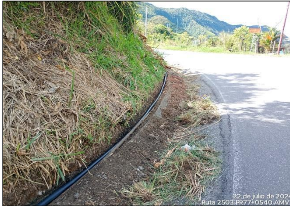
PR77+0540 y PR78+0625. Tubería instalada en Zona de Derecho de Vía.
