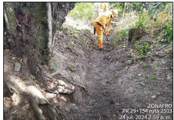
PR29+0754. Limpieza de descoles.
