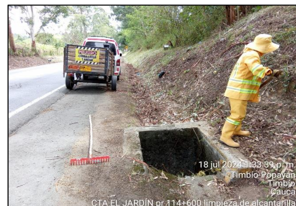
PR114+0600. Limpieza de alcantarillas.
