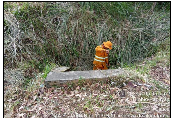
PR113+0800. Limpieza de descoles.
