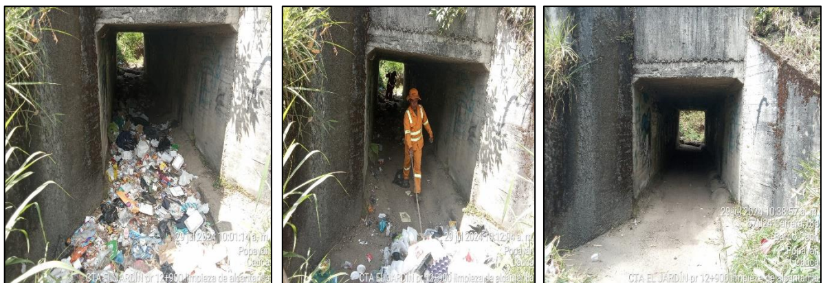
PR12+0900. Limpieza de box coulverts. Antes, durante y después.
