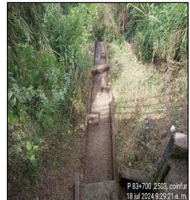
PR83+0700. Limpieza de descoles. Antes, durante y después.
