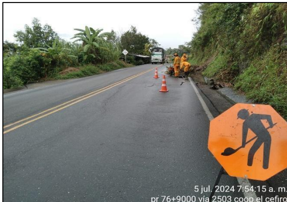
PR76+0900. Retiro de derrumbe del carril izquierdo.
