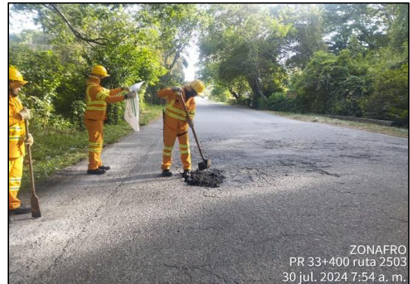
PR33+0400. Tapa huecos con asfalto.
