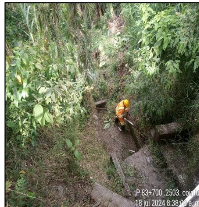
PR83+0700. Limpieza de descoles. Antes, durante y después.
