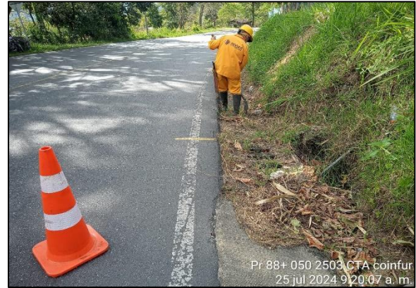
PR88+0050. Limpieza de alcantarillas.
