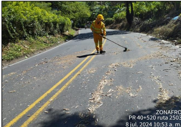
PR40+0520. Limpieza de calzada.
