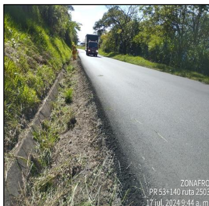
PR53+0140. Limpieza de cunetas. Antes, durante y después.
