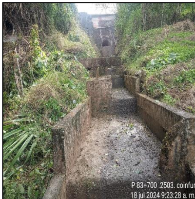
PR83+0700. Limpieza de descoles. Antes, durante y después.
