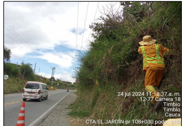
PR108+0030. Limpieza de descoles.
