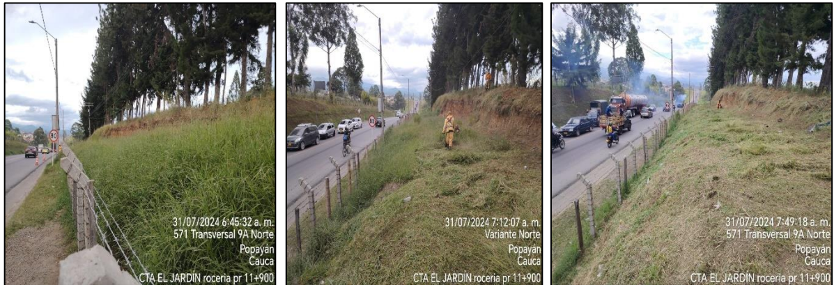
PR11+0900. Rocería mecánica. Antes, durante y después.
