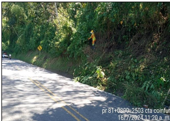
PR81+0800. Desmonte manual.
