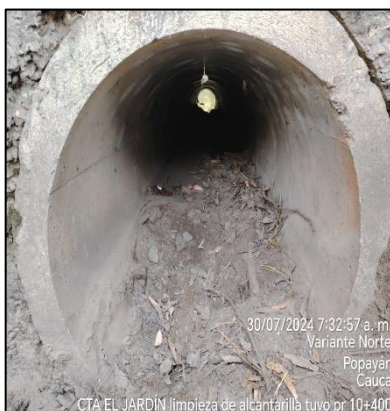
PR10+0400 Limpieza tubería de alcantarilla. Antes, durante y después.
