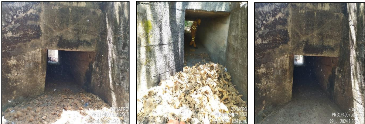
PR31+0400. Limpieza de box coulverts. Antes, durante y después.
