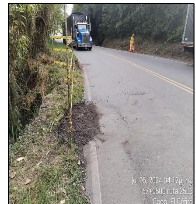
PR67+0660. Disminución de probabilidad de accidentalidad mediante tapa huecos con material de fresado. Antes, durante y después.
