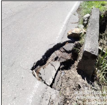
PR59+0700. Tapa huecos con material de fresado. Antes, durante y después.
