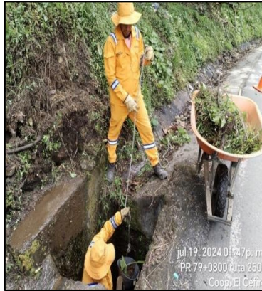
PR79+0800. Limpieza de alcantarillas. Antes, durante y después.
