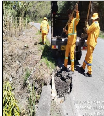
PR59+0700. Tapa huecos con material de fresado. Antes, durante y después.
