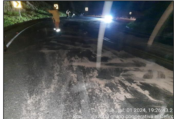
PR76+0200. Limpieza de calzada con aserrín por riego de ACPM.
