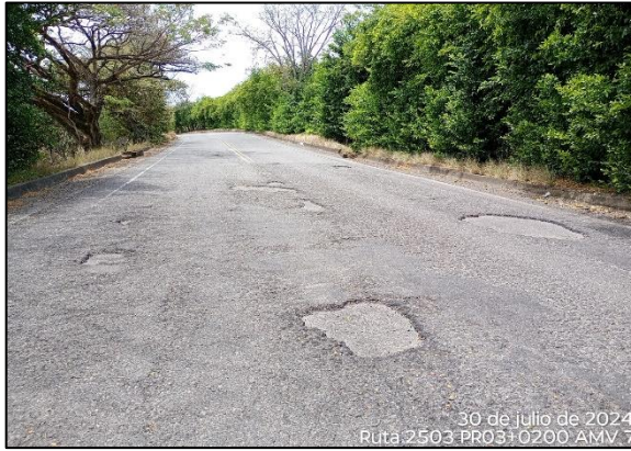
PR03+0200 y PR33+0410. Fisuras piel de cocodrilo y descascaramiento en la calzada.
