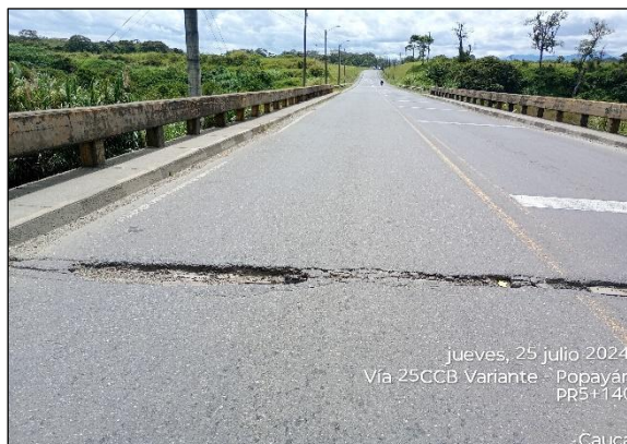
PR05+0140. Juntas del puente Río Cauca deterioradas.
