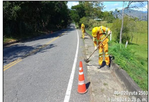
PR46+0020 Limpieza de cunetas.
