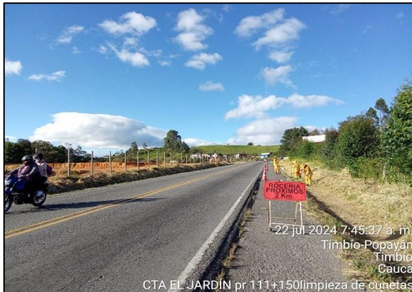
PR111+0150. Limpieza de cunetas.
