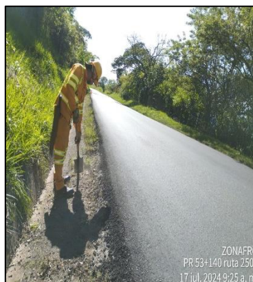
PR53+0140. Limpieza de cunetas. Antes, durante y después.
