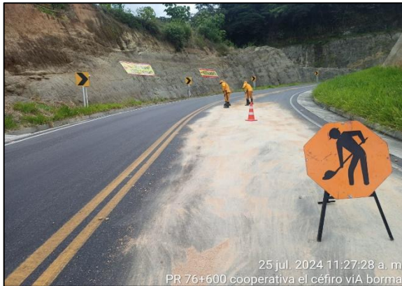
PR76+0600 a PR76+0900. Limpieza de calzada por riego de ACPM.
