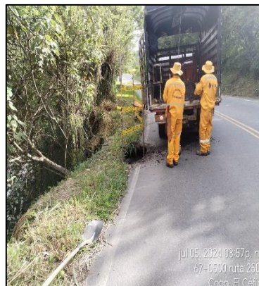
PR67+0660. Disminución de probabilidad de accidentalidad mediante tapa huecos con material de fresado. Antes, durante y después.
