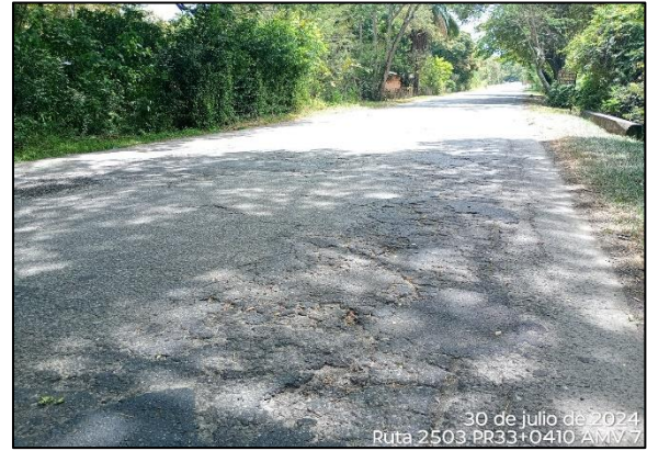
PR03+0200 y PR33+0410. Fisuras piel de cocodrilo y descascaramiento en la calzada.
