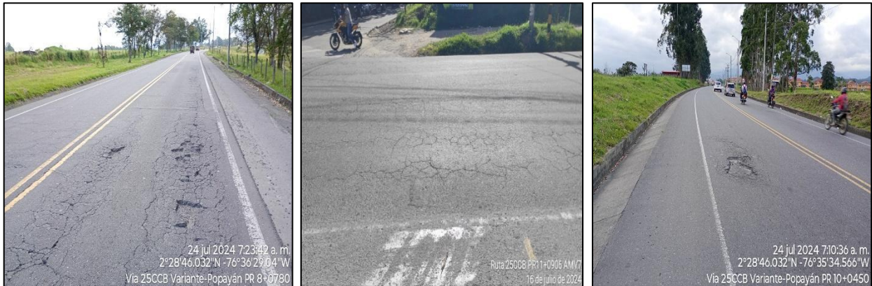
PR08+0780, PR11+0900 y PR10+0450. Estado actual.
