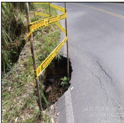
PR67+0660. Disminución de probabilidad de accidentalidad mediante tapa huecos con material de fresado. Antes, durante y después.
