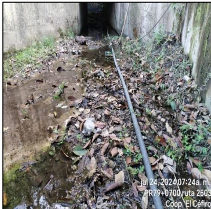
PR79+0700. Limpieza de box coulverts. Antes, durante y después.
