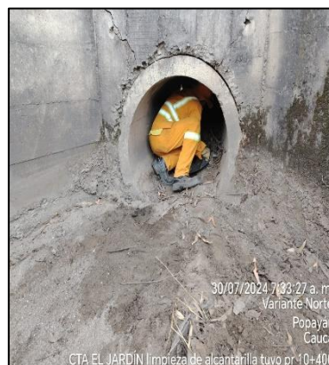
PR10+0400 Limpieza tubería de alcantarilla. Antes, durante y después.
