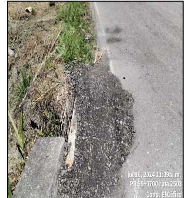
PR59+0700. Tapa huecos con material de fresado. Antes, durante y después.
