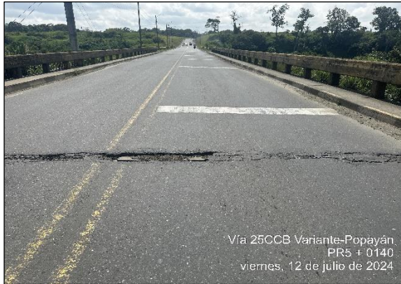
PR05+0140. Juntas del puente río Cauca deterioradas.
