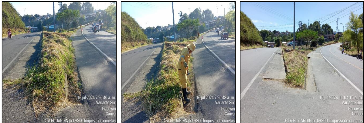
PR0+0300. Anillo Sur. Limpieza de cunetas. Antes, durante y después.
