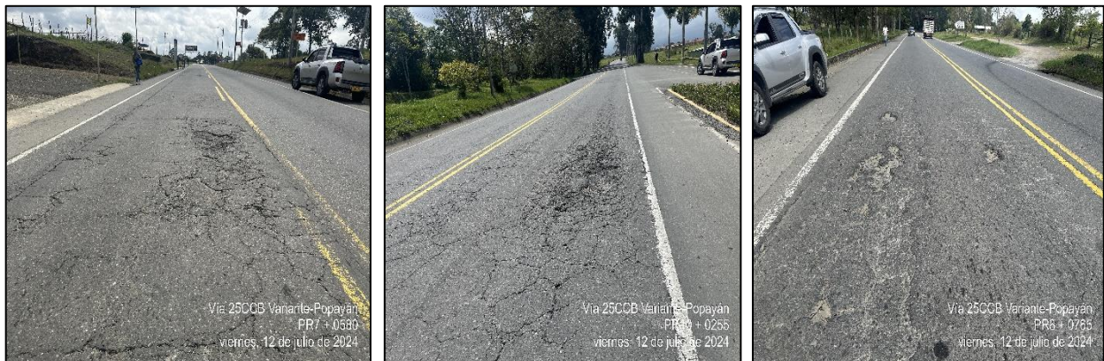
PR07+0580, PR10+0255 y PR08+0765. Estado actual.
