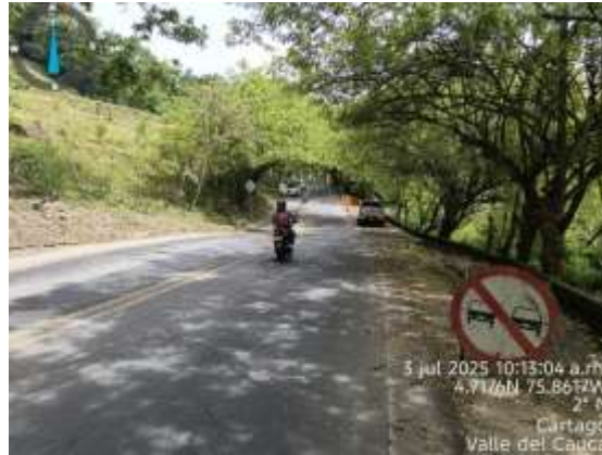
Imagen 3, 4 y 5 inspección rutas 2901B y 25VL07, actividades e indicadores de mantenimiento rutinario
