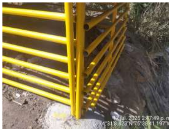
Imagen 25, 26 y 27 Inspección y recibo obras de reparación puente la floresta
