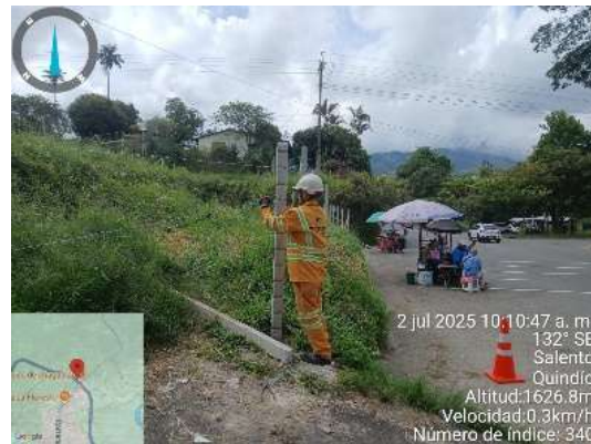
Imagen 1 y 2. Instalación de alambre de púas cerramiento lote Invias PR 5+0895 Ruta 40QN05
