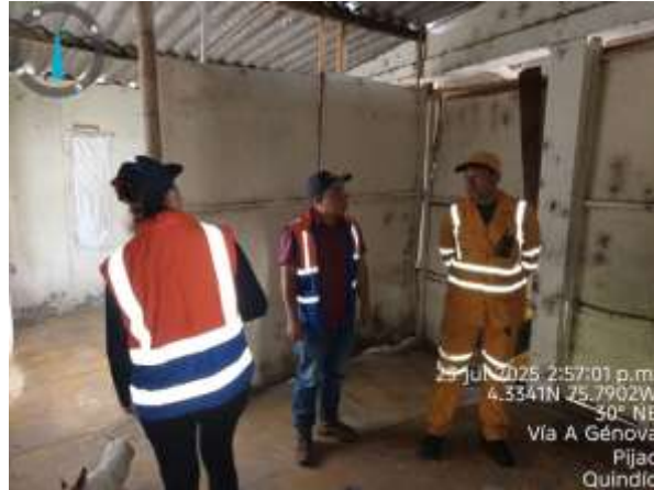
Imagen 35 Inspección bodega Barragán
