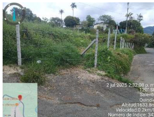
Imagen 3. Instalación de alambre de púas cerramiento lote Invias PR 5+0895 Ruta 40QN05
