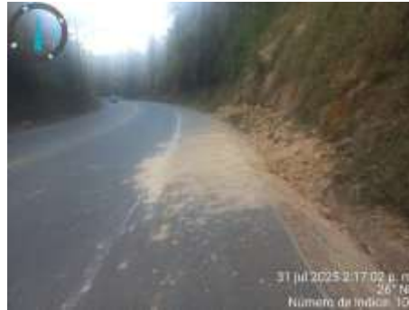
Imagen 3 Ruta 40QN05 PR 3+0050 despeje de la vía
