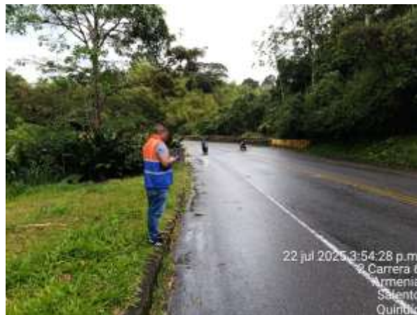
Imagen 34 Inspección necesidades puente quebrada la florida ruta 40QN05 PR 6+0450
