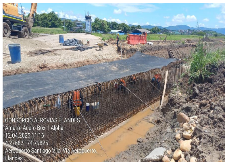
Ilustración 4 Acero de refuerzo box coulvert N°1
