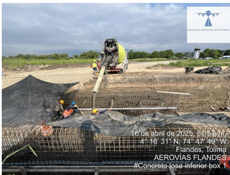
Ilustración 5 Vaciado de losa box culvert N°1
