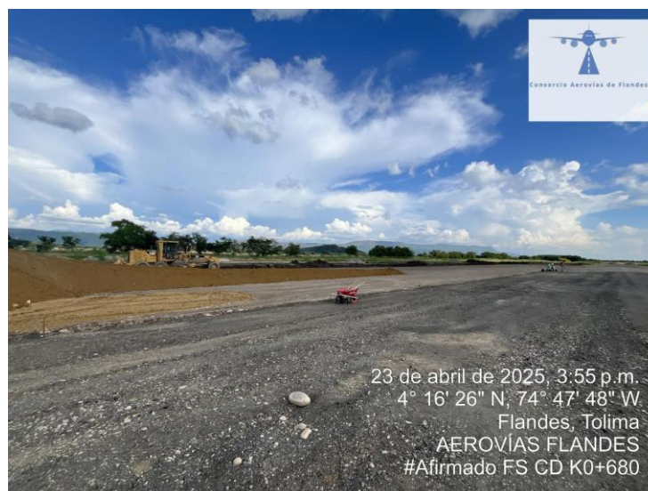
Ilustración 6 Afirmado zona de seguridad K0+680
