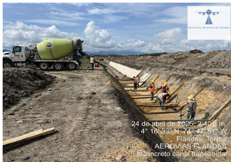
Ilustración 3 Vaciado para canal trapezoidal
