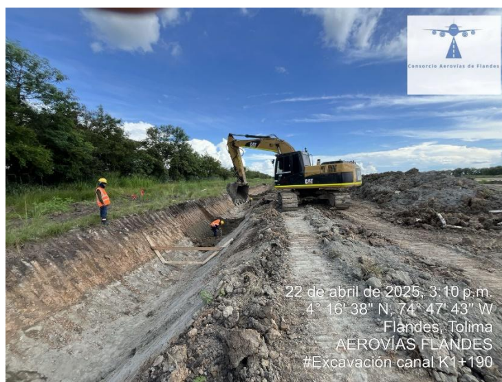
Ilustración 2 Excavación mecánica canal trapezoidal
