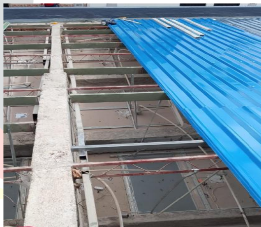
Tubería estructural para reforzamiento
