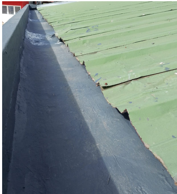
Foto 1. Impermeabilización Viga canal
