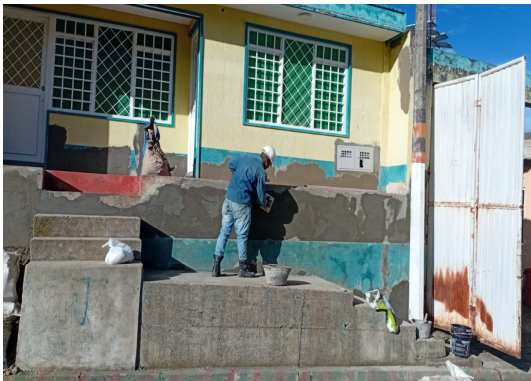
Resane con mortero impermeabilizado
