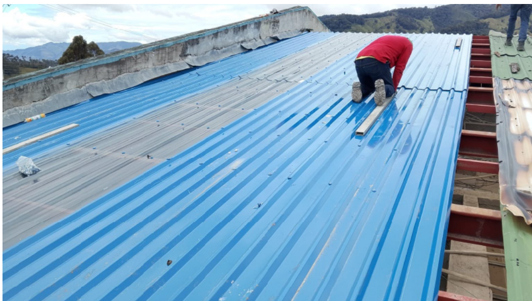
Foto 2. Desmonte de cubierta existente
