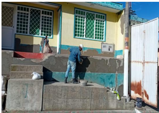
Resane con mortero impermeabilizado
