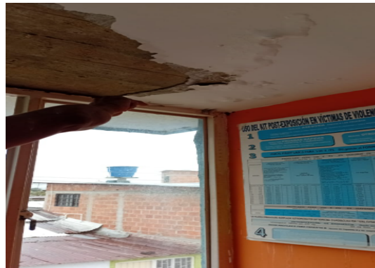
Resane con mortero impermeabilizado
