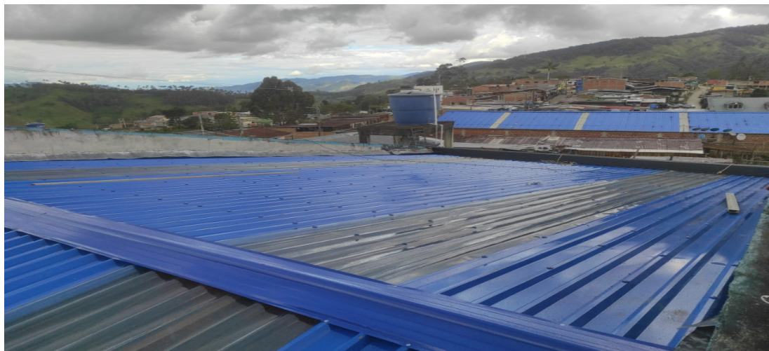
Foto 6. Instalación de Cubierta
