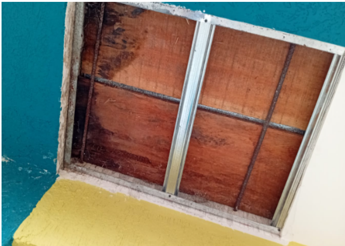
Foto 5. Desmonte de cielo falso existente
