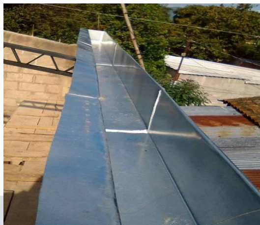
Suministro e instalación de canal
