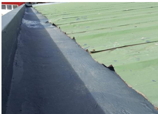
Mantenimiento viga canal
