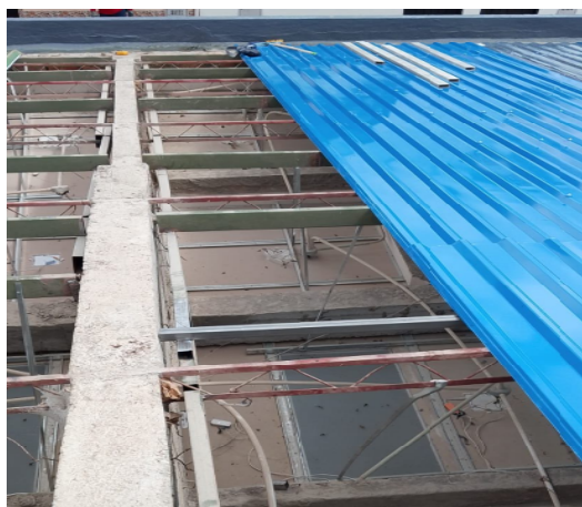
Tubería estructural para reforzamiento
