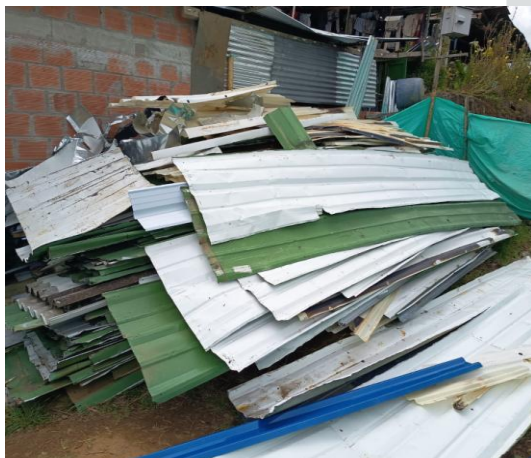
Retiro de escombros
