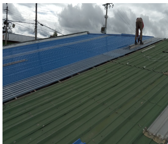
Instalación de teja arquitectónica
