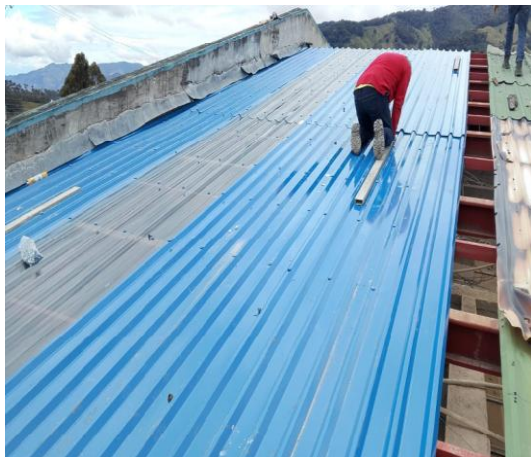
Desmonte de cubierta existente
