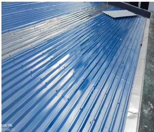
Suministro e instalación de flanche
