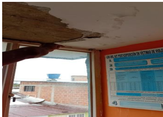
Resane con mortero impermeabilizado
