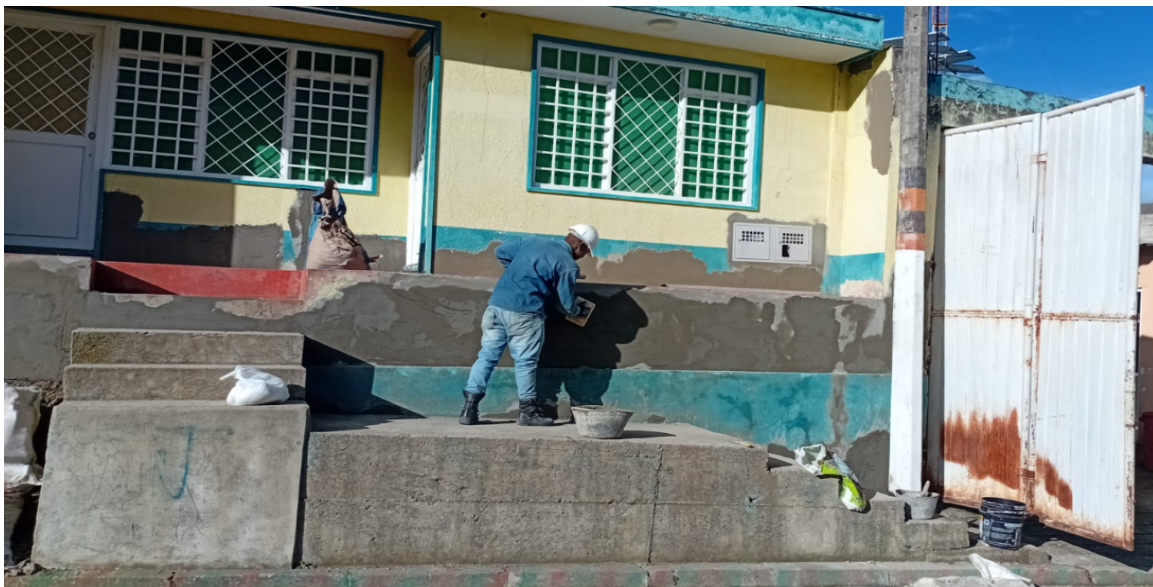
Foto 12. Resane con mortero impermeabilizado
