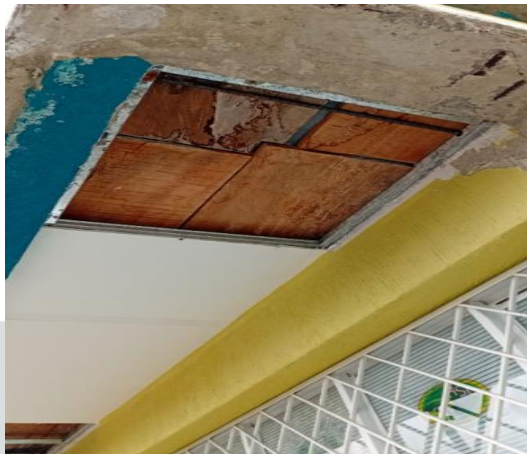
Desmonte de cielo falso existente
