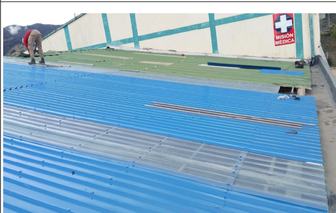
Foto 3. Instalación de Flanche
