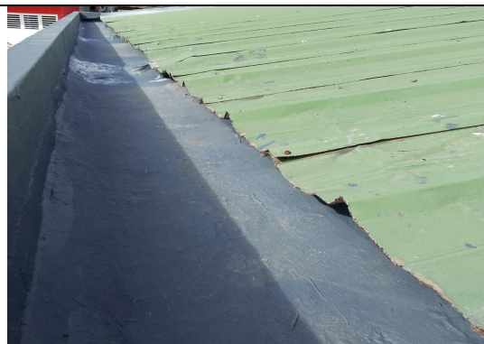
Mantenimiento viga canal
