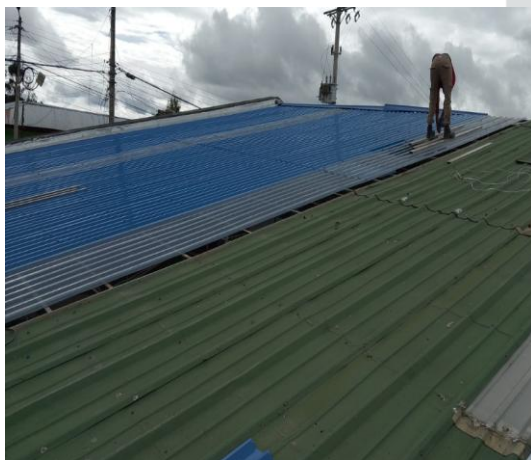
Instalación de teja arquitectónica
