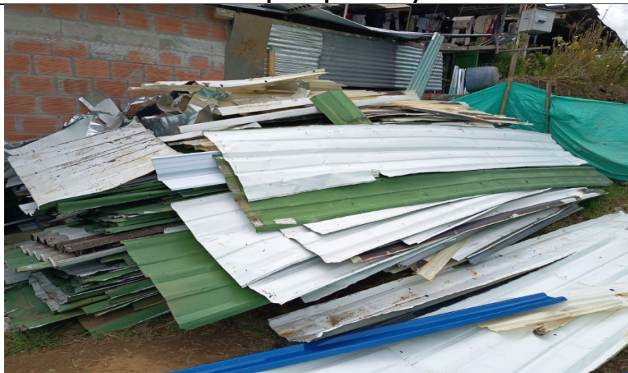
Foto 10. Retiro de escombros
