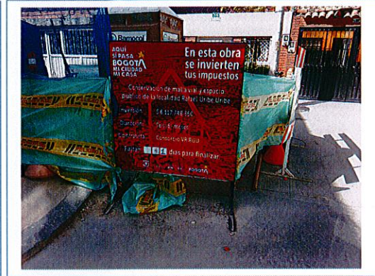
Registro Fotográfico 13. Valla de obra Centenario
