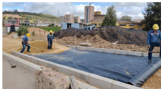
Instalación de Geotextil
