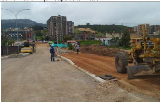
Conformación Eje 1Capa Subbase Granular
