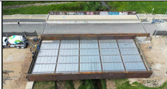
Terminación de instalación de Lamina Colaborante
