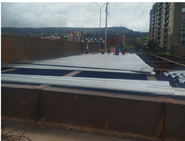
Inicio de Instalación de lamina Colaborante
