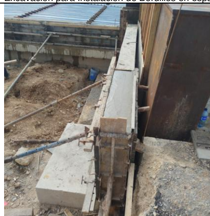
Excavación para Instalación de Bordillos en espacio Publico
