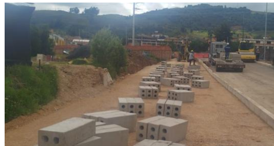
Instalacion de Bordillos eje 1 espacio Publico
