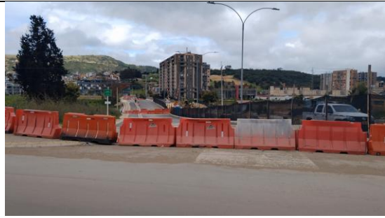
Cerramiento con maletines Carrera 2 Este
