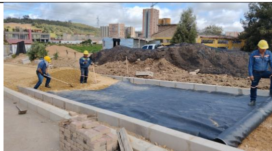
Instalación de Geotextil
