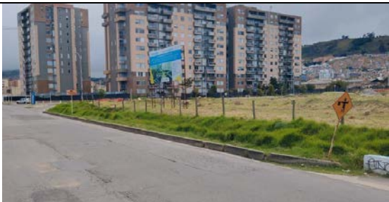
Señalización acceso Av Universitaria
