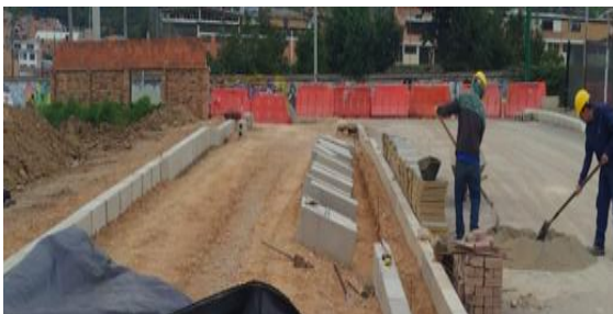
Instalacion de Bordillos eje 1 espacio Publico
