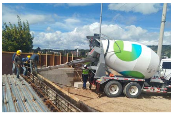
Fundida de Concreto en espaldares de los estribos
