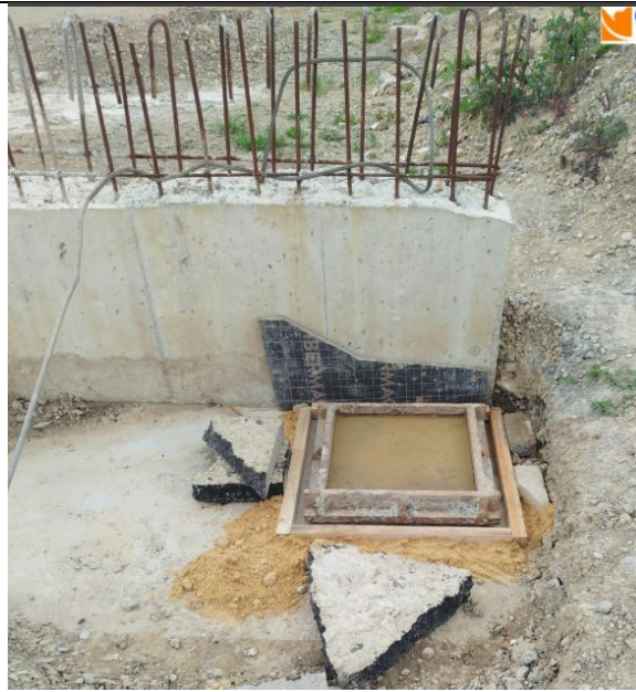
terminado concreto autonivelante
