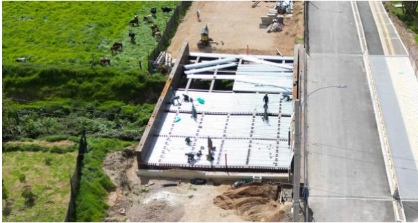
Inicio de Instalación de lámina Colaborante
