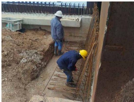
Refuerzo muro de acompañamiento
