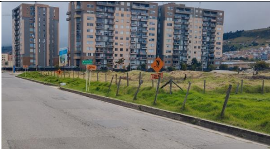
Señalización acceso Av. Universitaria
