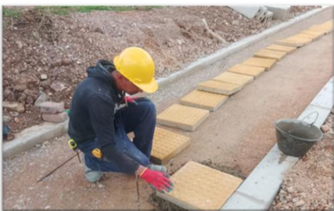
Proceso de Instalación de Losetas y adoquines en el espacio público eje 1.
