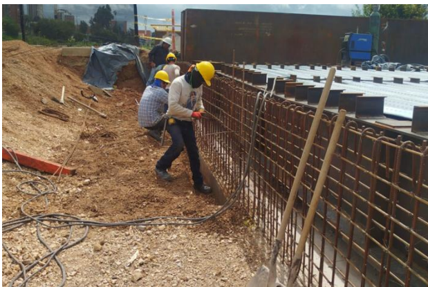
Refuerzos espaldares de los estribos
