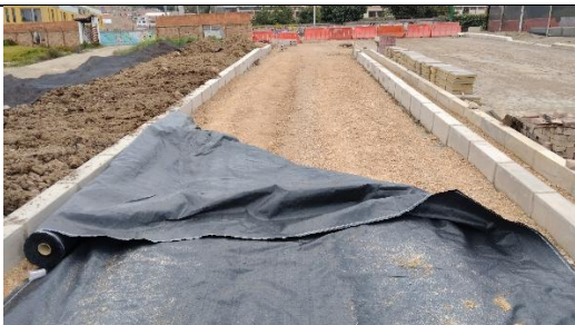
Instalación de Geotextil
