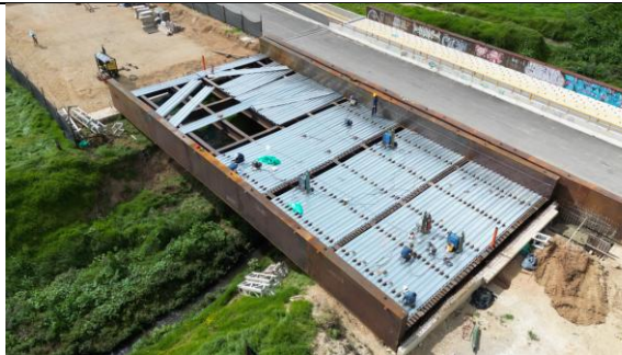
Inicio de Instalación de lámina Colaborante
