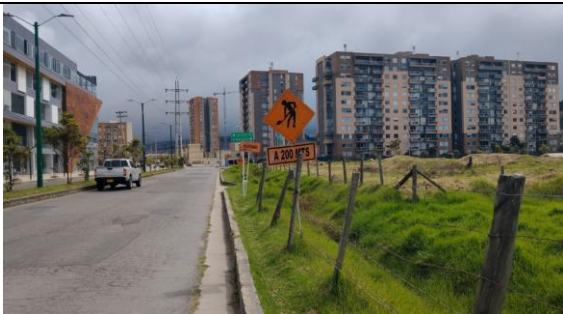
Señalización acceso Av Universitaria
