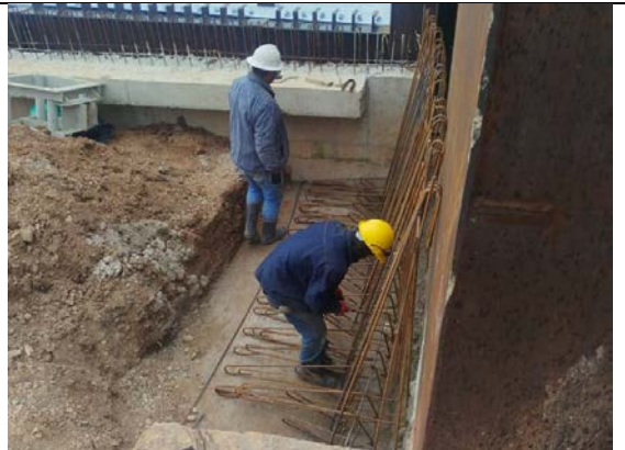
Refuerzo muro de acompañamiento
