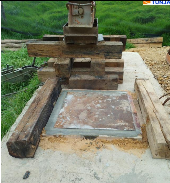
terminado concreto autonivelante
