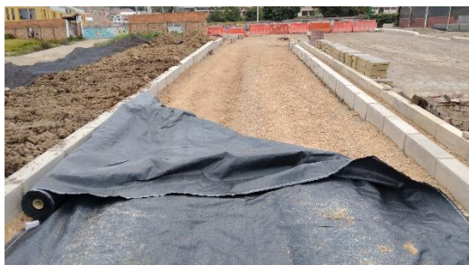
Ilustración 14. Instalación de Geotextil.
