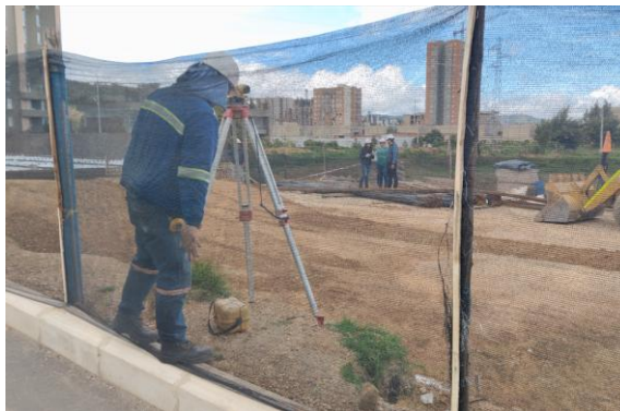
Localización y Replanteo Eje 1
