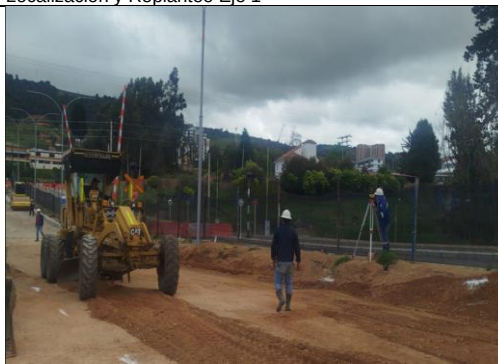
Colocación Material de Afirmado Eje 1
