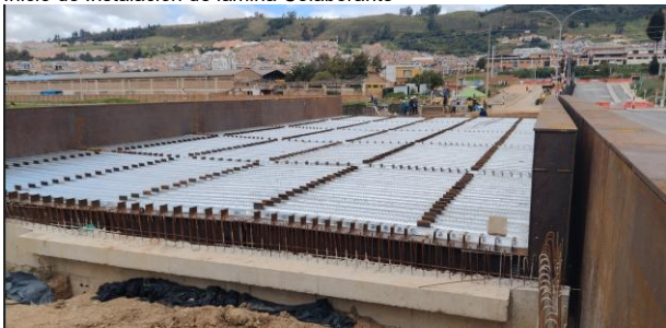
Terminación de instalación de Lamina Colaborante
