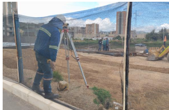
Localización y Replanteo Eje 1
