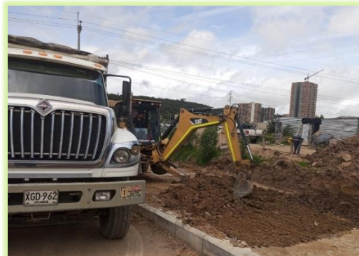
Excavación para conformar espacio Publico
