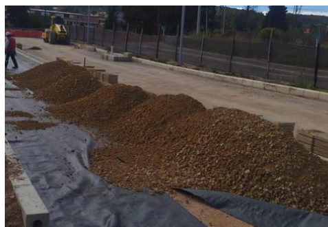
Colocación Material de Subbase Granular Eje 1
