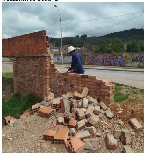
Demolición de Muro
