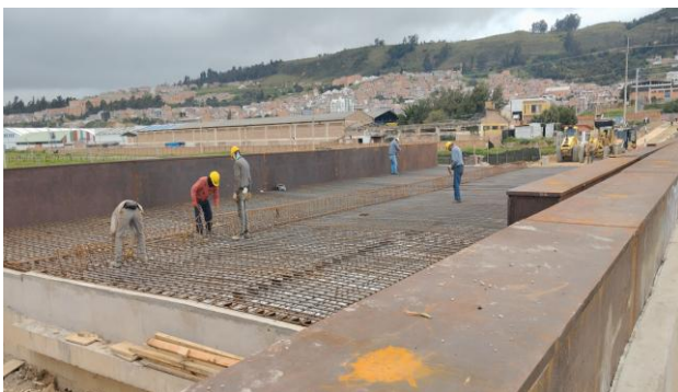
Refuerzo Losa del Puente
