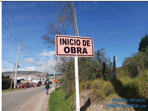
Señalización preventiva carrera 2 este
