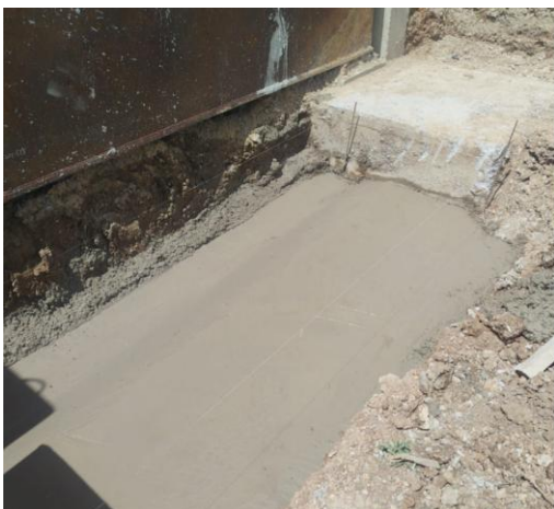
Solado Muro de Acompañamiento
