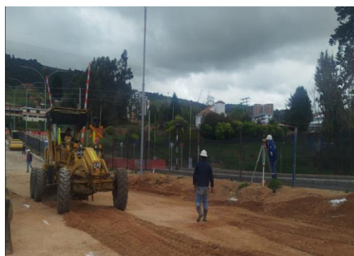
Colocación Material de Afirmado Eje 1
