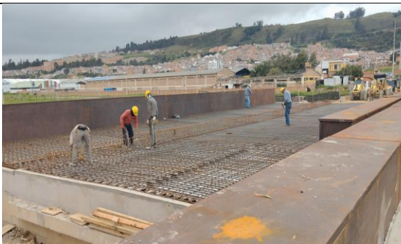
Refuerzo Losa del Puente
