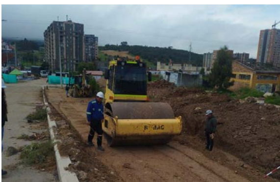
Conformación Eje 1Capa de afirmado
