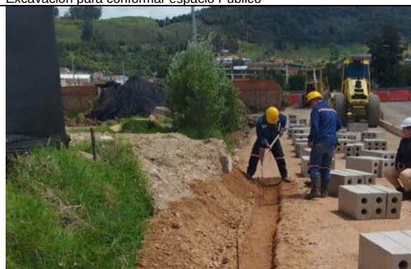
Excavación para Instalación de Bordillos en espacio Publico
