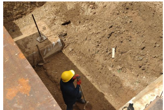
Excavación para Zarpa de Muro
