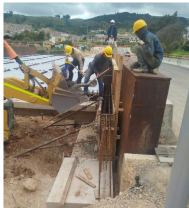
Excavación para Zarpa de Muro
