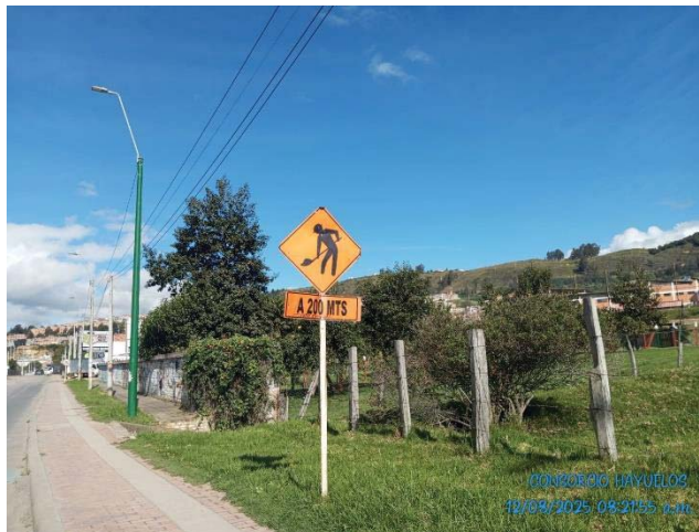
Señalización preventiva trabajos en la via carrera 2 este
