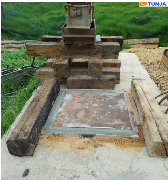
terminado concreto autonivelante
