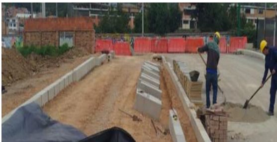
Instalacion de Bordillos eje 1 espacio Publico
