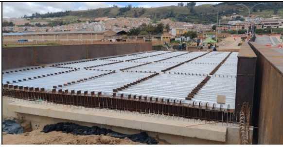
Terminación de instalación de Lamina Colaborante
