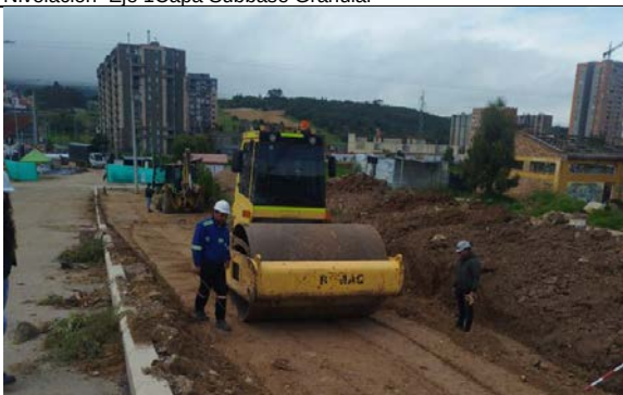
Conformación Eje 1Capa de afirmado
