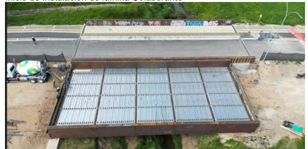
Terminación de instalación de Lamina Colaborante
