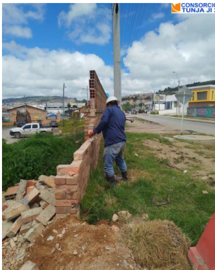
Demolición de Muro
