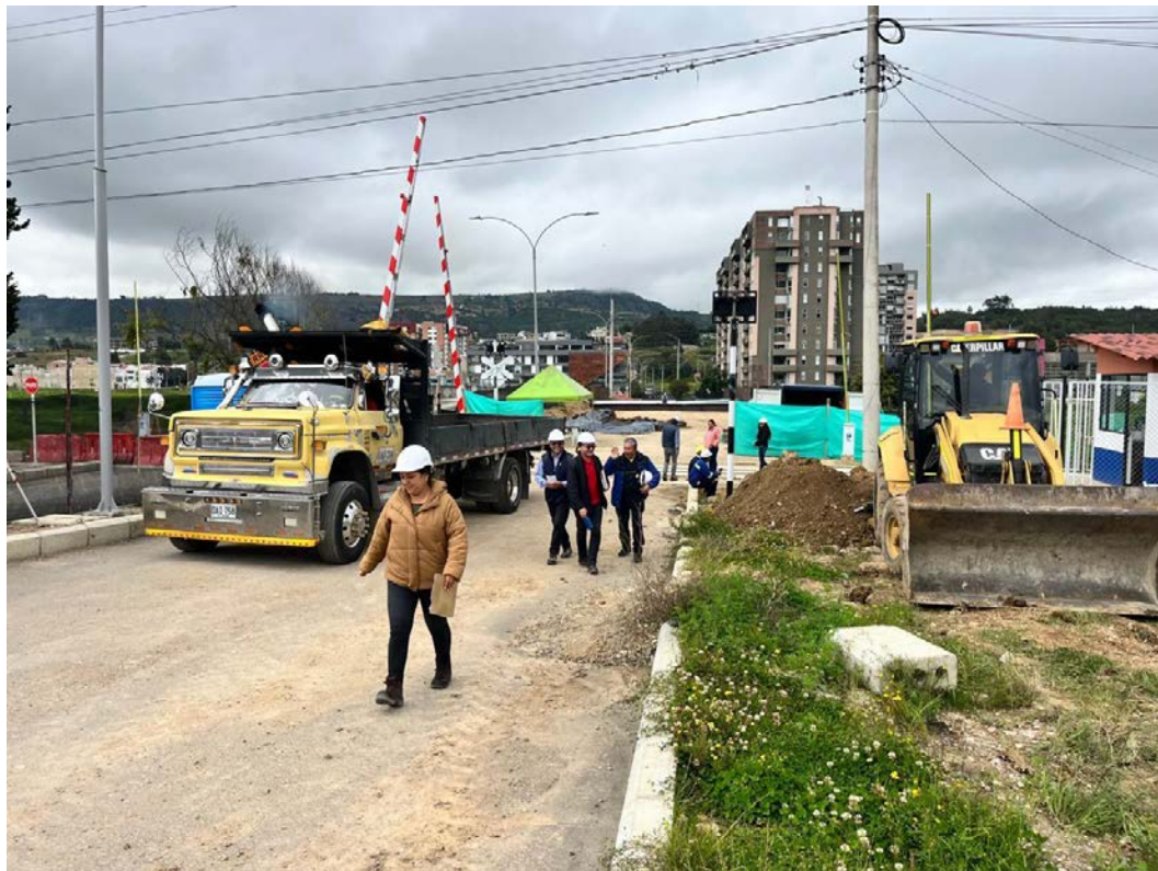
Fotos 1 y 2. Estado actual obras calle 59, calzada Norte entre Av. Universitaria y Conj. Residencial Hayuelos (Excavaciones, maquinaria, equipo y personal en obra)
