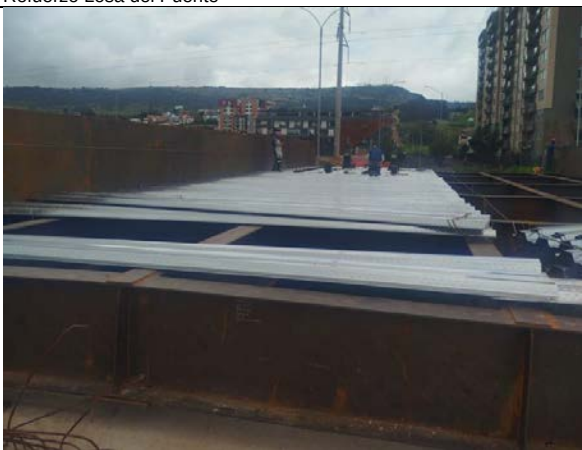
Inicio de Instalación de lamina Colaborante
