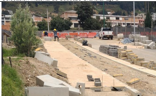
Colocación Material de Subbase Granular Eje 1
