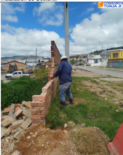
Demolición de Muro
