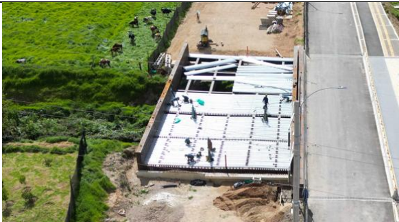
Inicio de Instalación de lámina Colaborante
