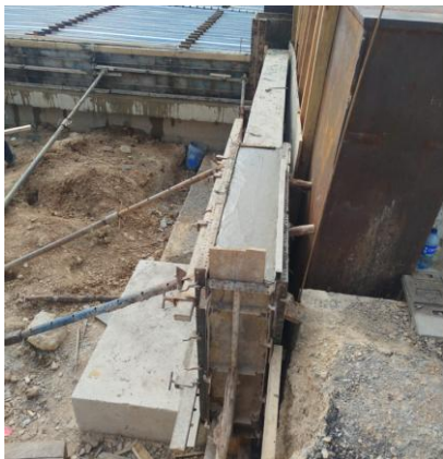
Excavación para Instalación de Bordillos en espacio Público
