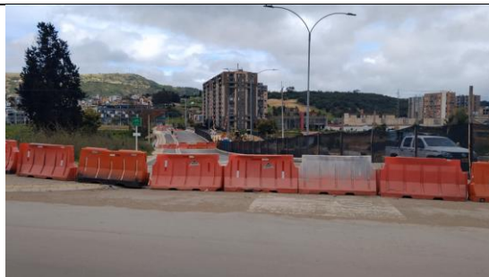
Cerramiento con maletines Carrera 2 Este
