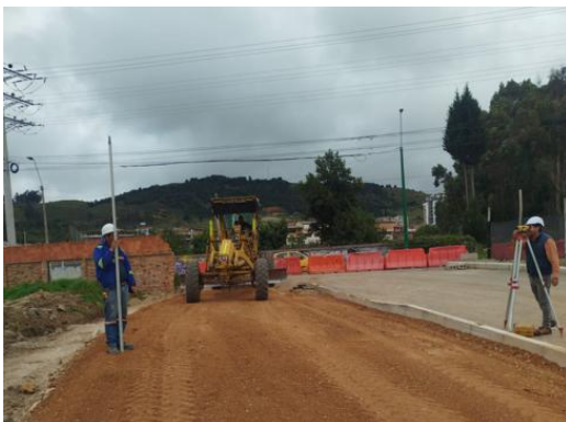
Nivelación Eje 1 Capa Subbase Granular
