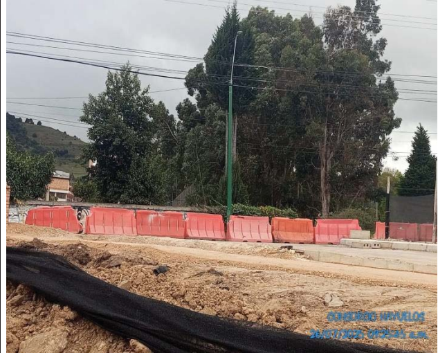
Utilización de maletines sector Postobón al ingreso de la obra Carrera 2 este
