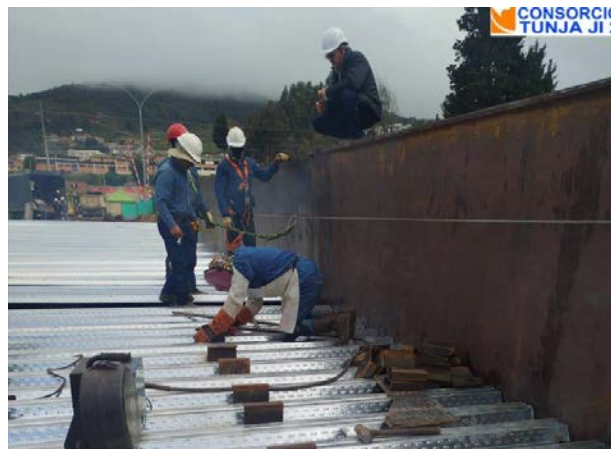
Instalación de Conectores
