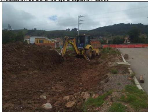
Excavación para conformar espacio Publico
