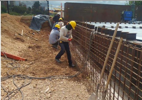
Refuerzos espaldares de los estribos
