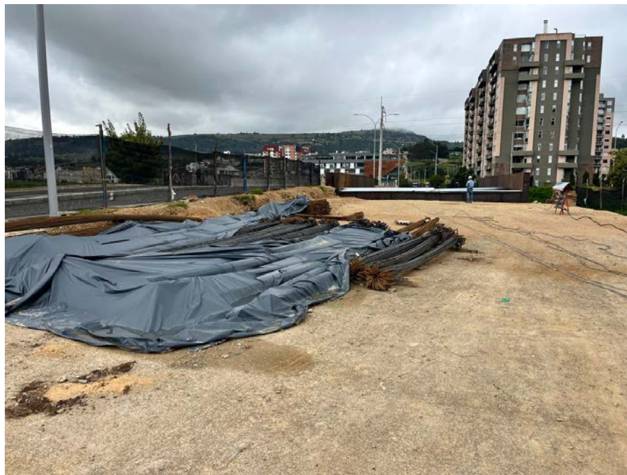
Fotos 3 y 4. Estado actual obras calle 59, calzada Norte entre Av. Universitaria y Conj. Residencial Hayuelos (Afirmado, cerramiento, campamento, material acopiado en obra)
