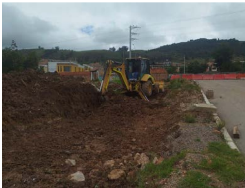
Excavación para conformar espacio Publico
