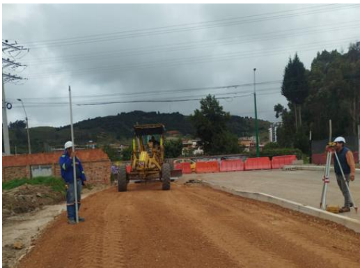
Nivelación Eje 1Capa Subbase Granular
