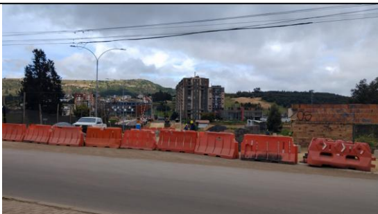
Cerramiento con maletines Carrera 2 Este
