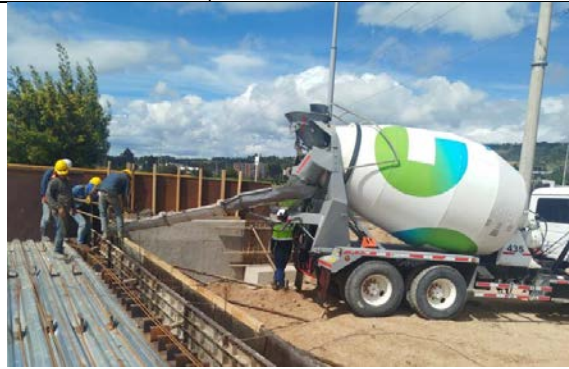
Fundida de Concreto en espaldares de los estribos
