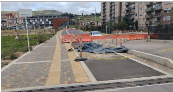
Cerramiento con maletines acceso a C. Hayuelos
