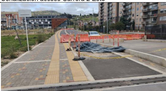
Cerramiento con maletines acceso a C. Hayuelos
