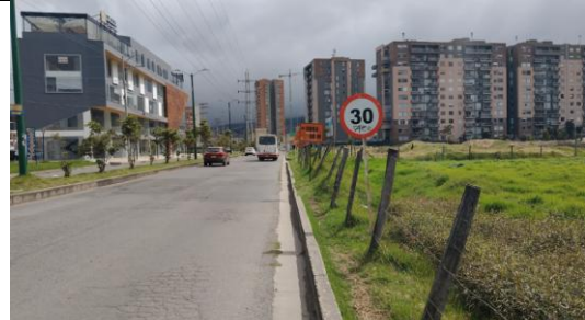
Señalización acceso Av. Universitaria
