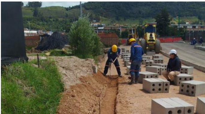
Excavación para Instalación de Bordillos en espacio Publico
