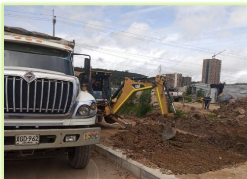
Excavación para conformar espacio Publico
