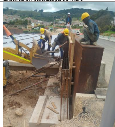
Excavación para Zarpa de Muro
