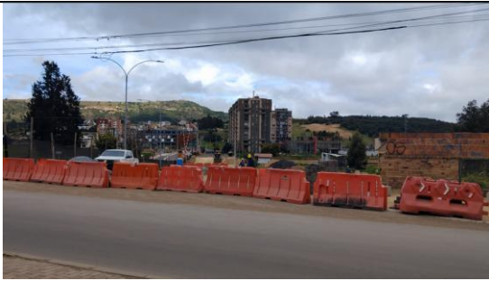
Cerramiento con maletines Carrera 2 Este
