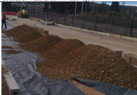
Colocación Material de Subbase Granular Eje 1
