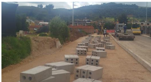
Instalacion de Bordillos eje 1 espacio Publico
