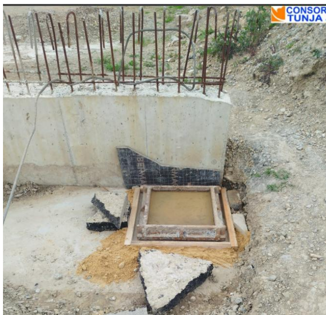
terminado concreto autonivelante
