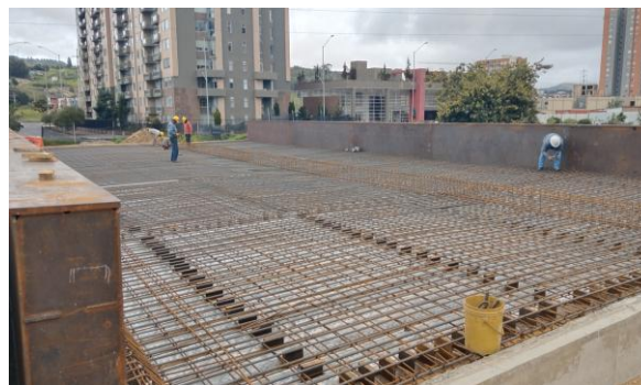
Refuerzo Losa del Puente
