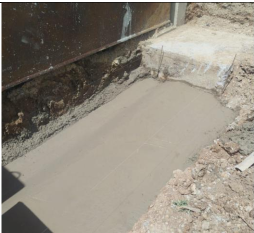
Solado Muro de Acompañamiento
