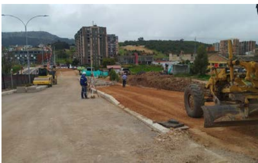
Conformación Eje 1Capa Subbase Granular
