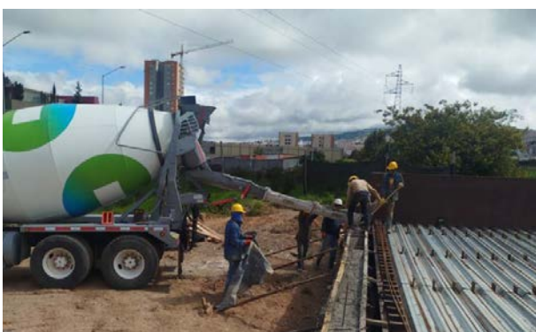
Fundida de Concreto en espaldares de los estribos
