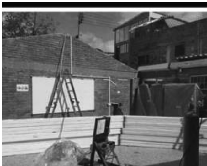
Instalación de estructura metálica.
