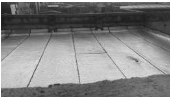
Instalación de manto asfáltico
