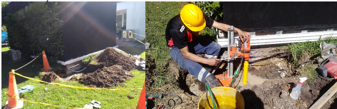
Foto 3. Ejecución de exploración estructural aula Chowa.
