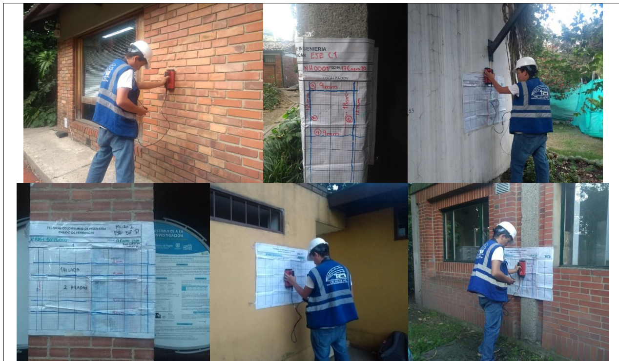
Foto 2. Ejecución de ensayos no destructivos – aula Chowa, subdirección científica, laboratorio infantil, aula ambiental, cafetería, baños y área técnica.
