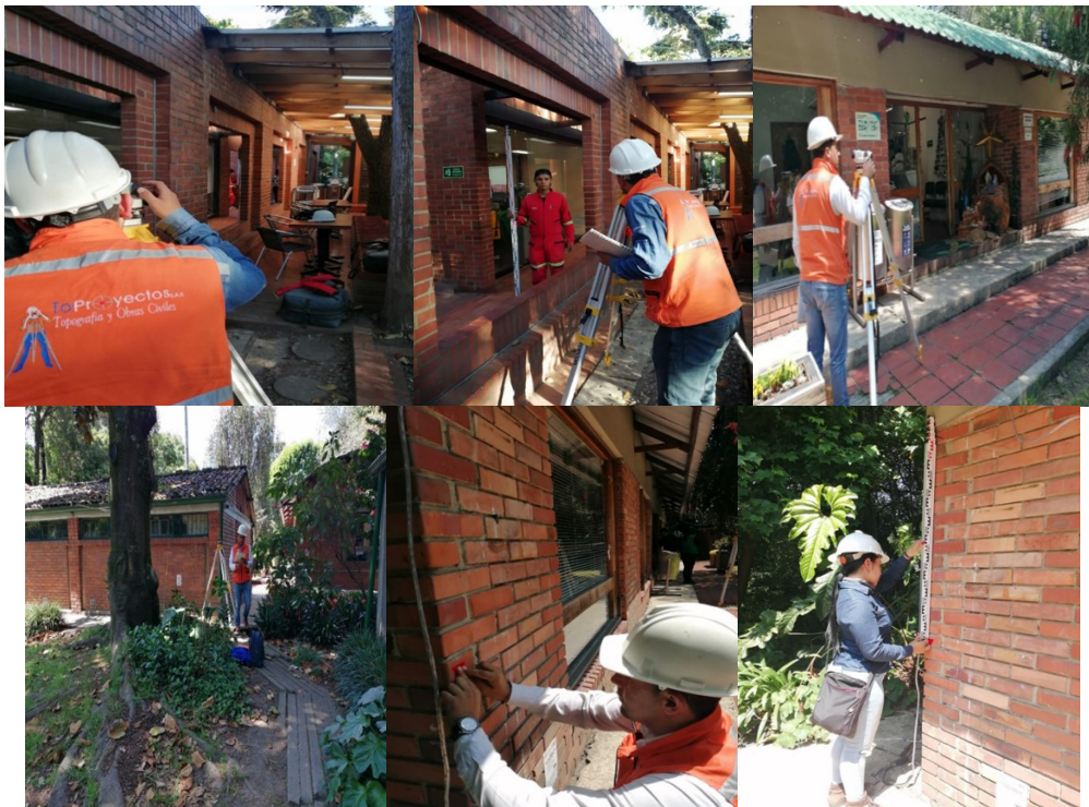
Foto 6. Ejecución de levantamiento topográfico en cafetería, baños, área técnica, control interno, nodos humedales y almacén.
