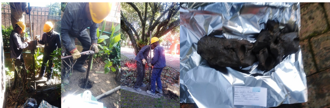
Foto 1. Ejecución de sondeos S14, S15 y S16 en administrativa y subdirección educativa.
