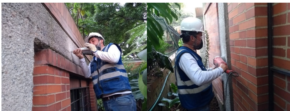
Foto 5. Ejecución de ensayos esclerométrico en administrativa.
