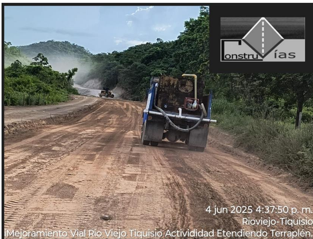
Humectación de la vía
