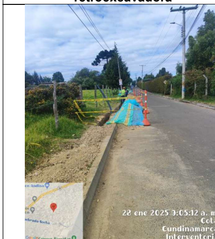
FOTO 39. Delimitación de áreas Tramo 4
