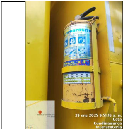
FOTO 43. Inspección de extintor volqueta
