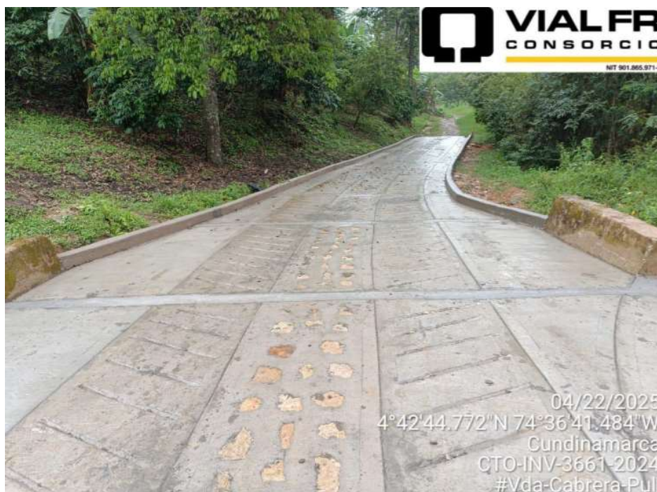
Placa huella terminada. Vda Cabrera, Pulí
