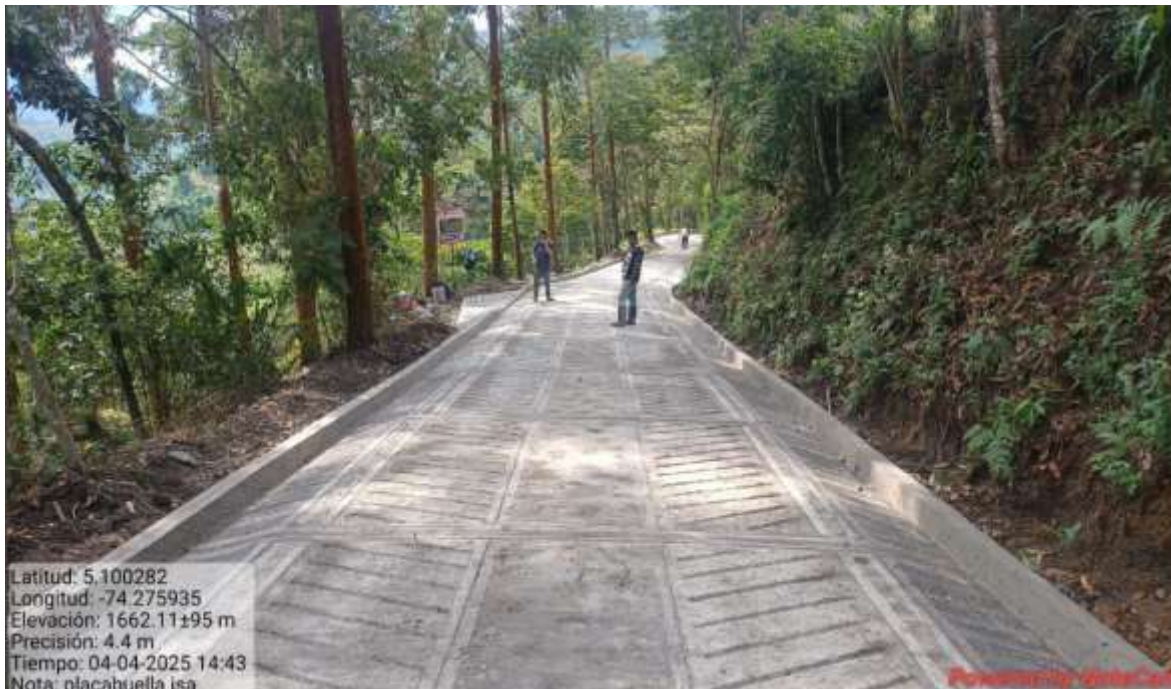
Placa huella terminada. Vda Imparal, Supatá
