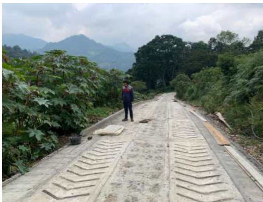
Avance general de obra con corte al 5-mar-2025. Vda Trigo, Guayabal de Siquima
