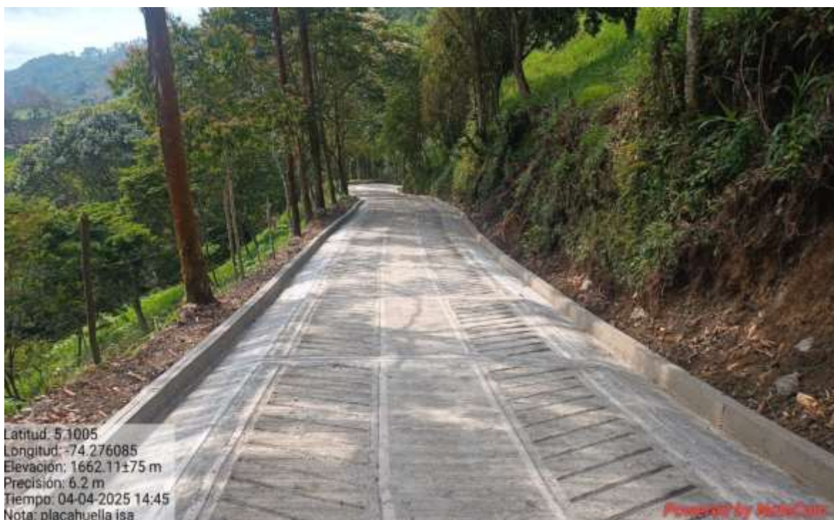
Placa huella terminada. Vda Imparal, Supatá
