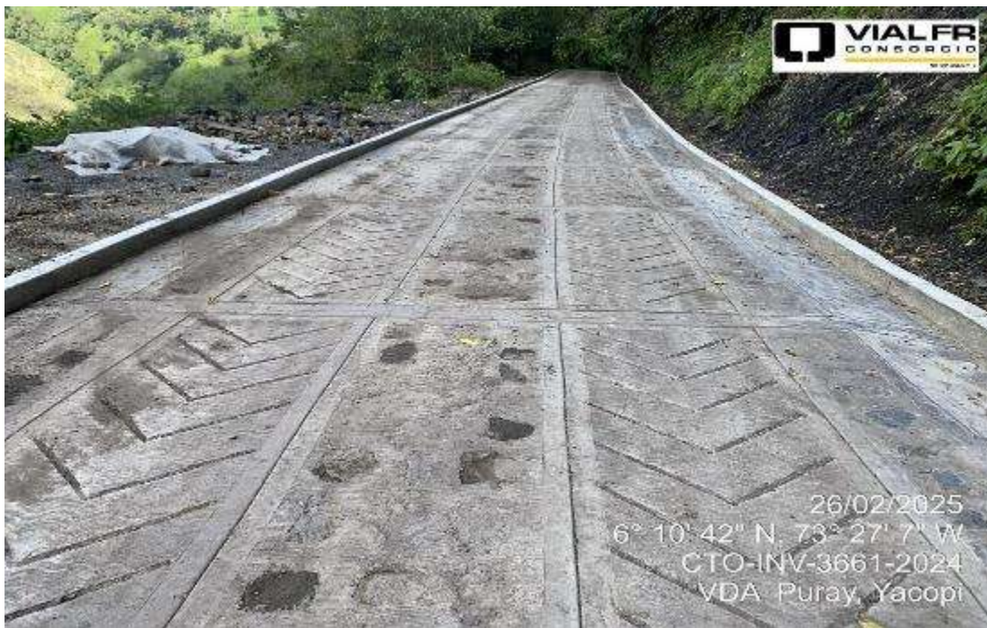
PLACA HUELLA TERMINADA
