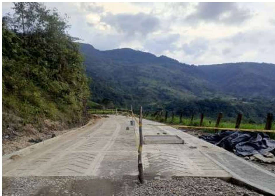
Placa huella terminada. Vda Camancha, San Cayetano
