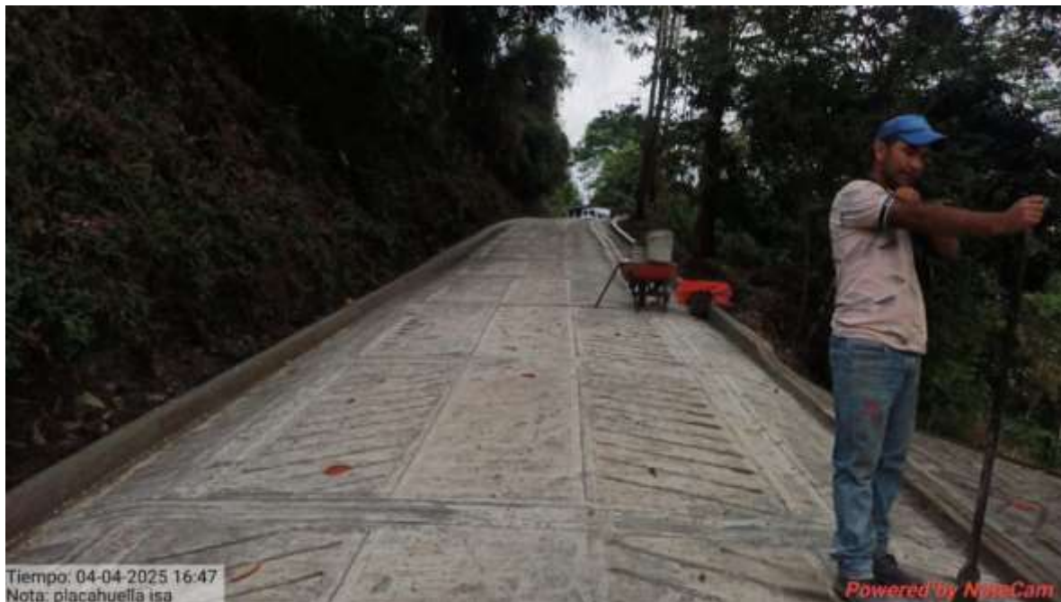
Placa huella terminada. Vda El Imparal, Supatá
