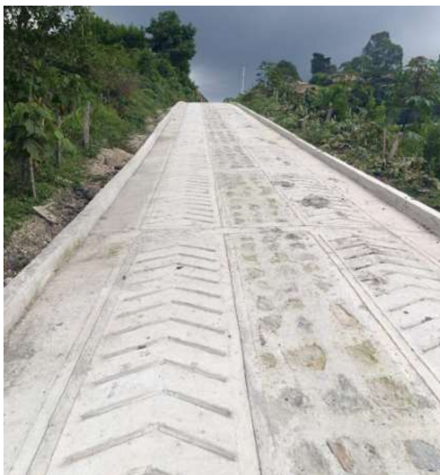
Placa huella terminada. Vda Robledal, Guayabal de Siquima
