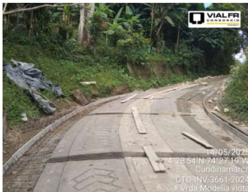
Avance general de obra al 14-may-2025. Vda Modelia, Viotá
