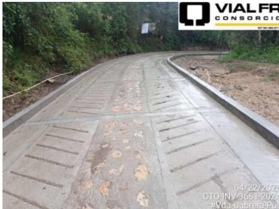
Placa huella terminada. Vda Cabrera, Pulí
