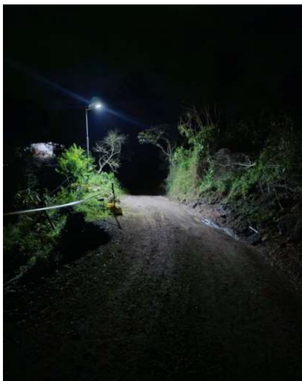
Suministro e instalación de luminarias solar LED en el marco del plan de inversión social. Vda Robledal, Guayabal de Siquima
