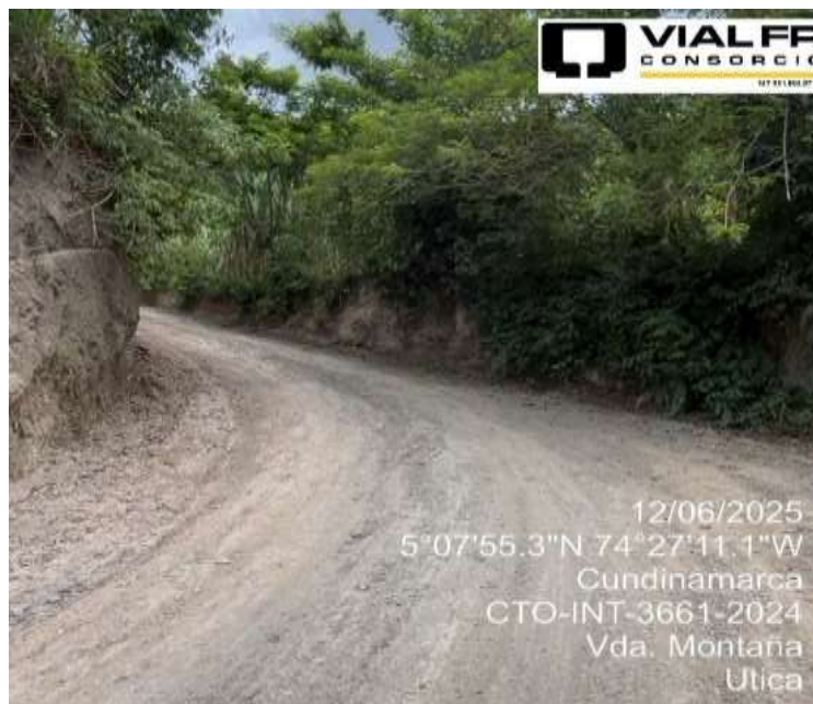
conformación de la calzada convenio solidario de fecha junio-2025. Vda La Montaña, Útica
