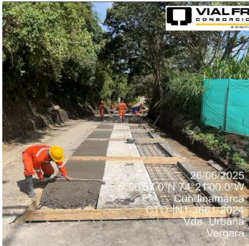
Avances de obra jun-2025. Vda Urbana, Vergara
