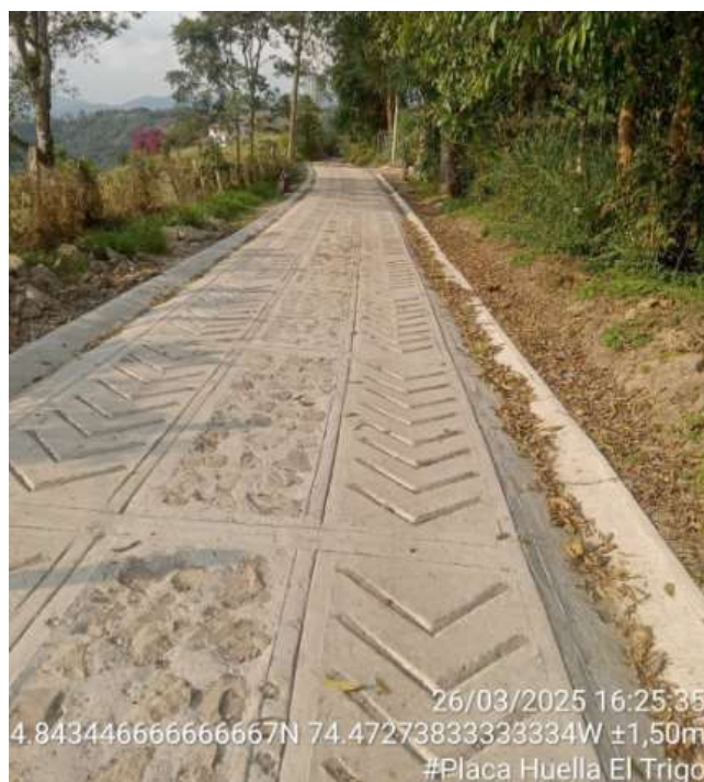
Placa huella terminada. Vda Trigo, Guayabal de Siquima
