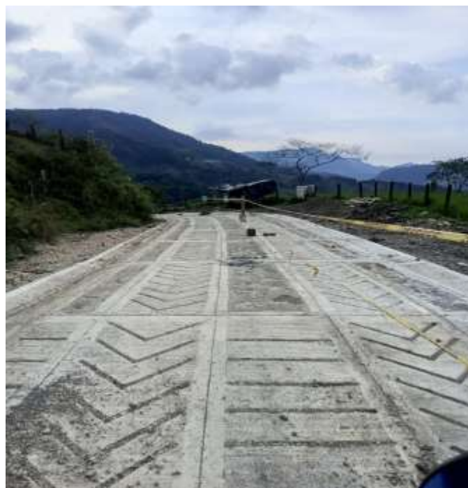
Placa huella terminada. Vda Camancha, San Cayetano
