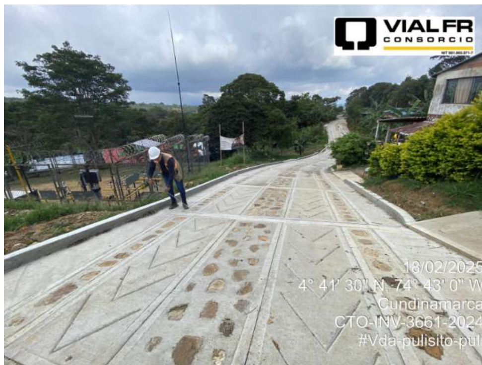
Estado actual del tramo a intervenir (Terminado). Vda Pulisito, Pulí
