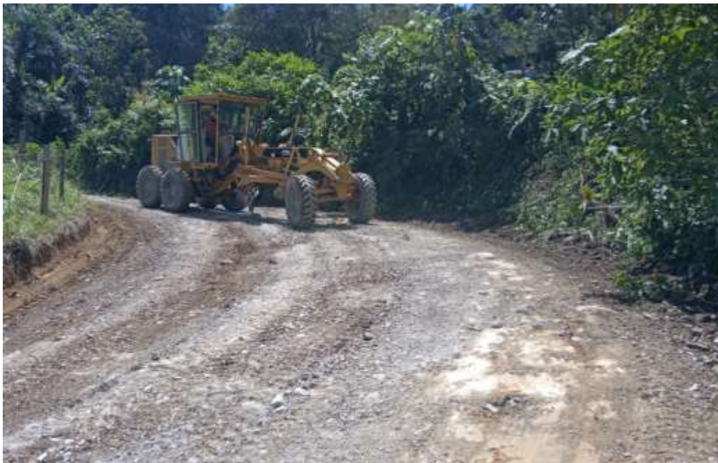
Replanteo y conformación del tramo vial objeto de intervención. Vda Liria, San Cayetano
