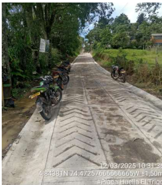
Placa huella terminada. Vda Trigo, Guayabal de Siquima
