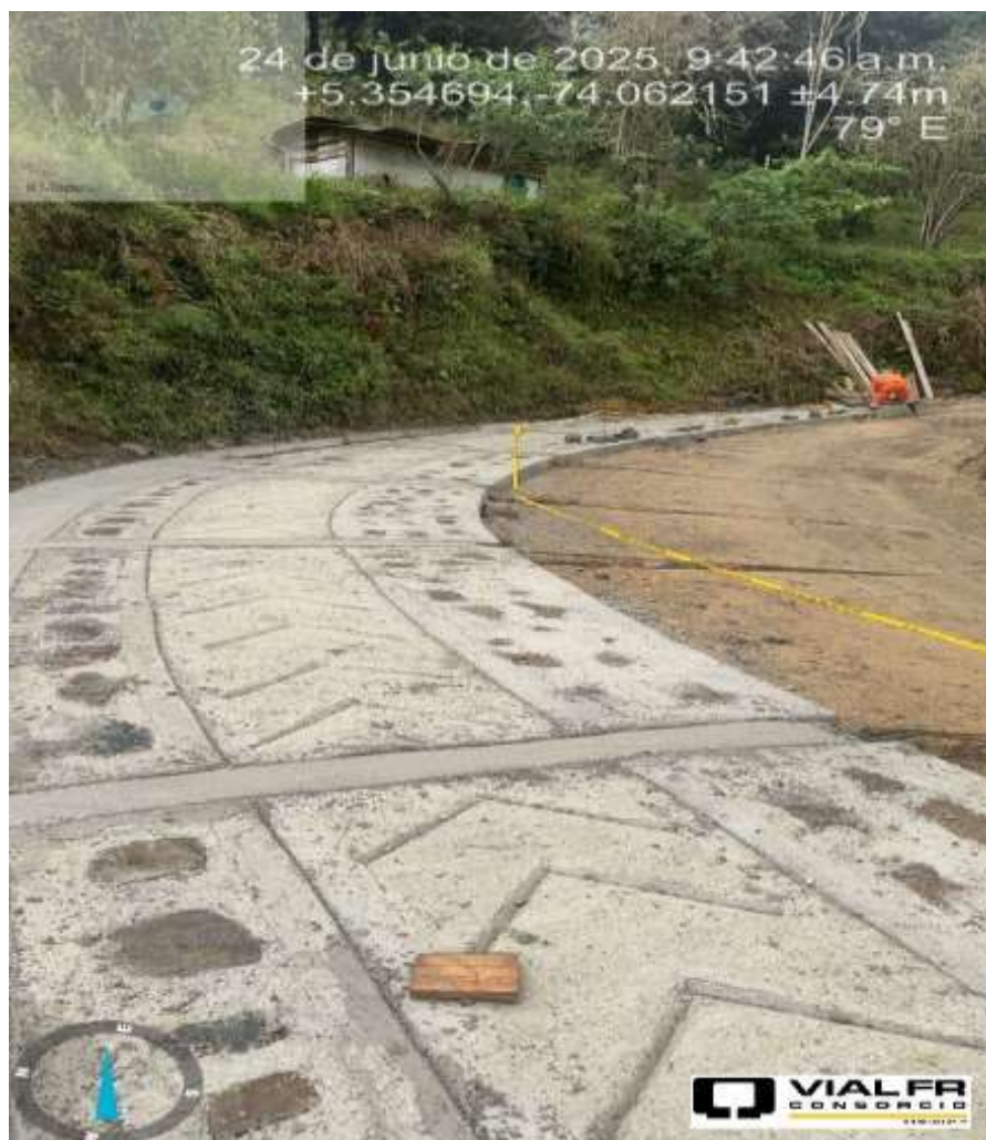
Avance general de la obra. Vda Liria, San Cayetano
