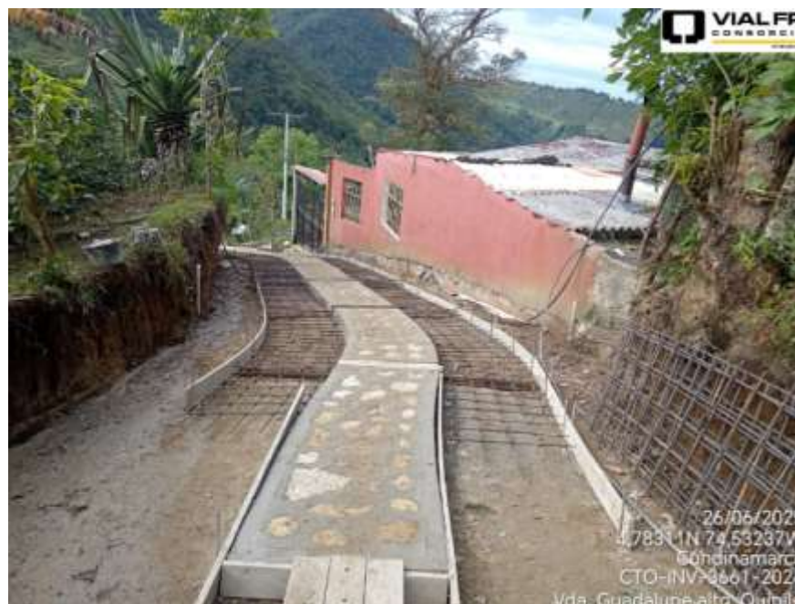
Vaciado de concreto de elementos de la placa huella. Vda Guadalupe, Quipile
