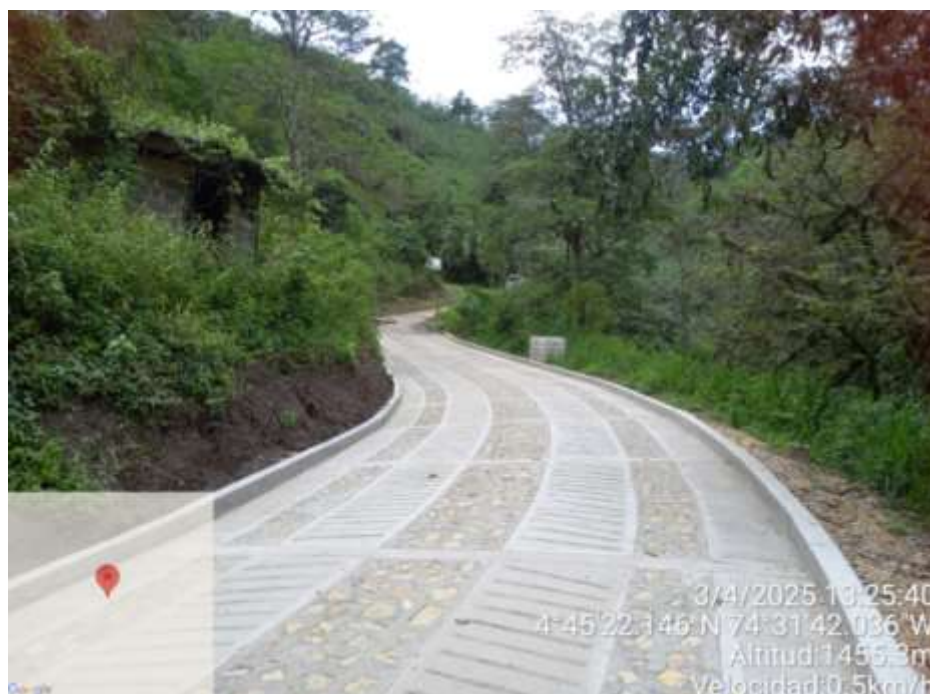
Placa huella terminada. Vda Argentina, Quipile
