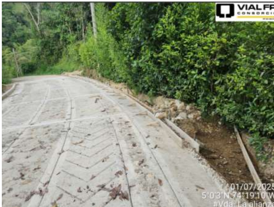
Avance general de la obra. Vda Alianza, La Vega
