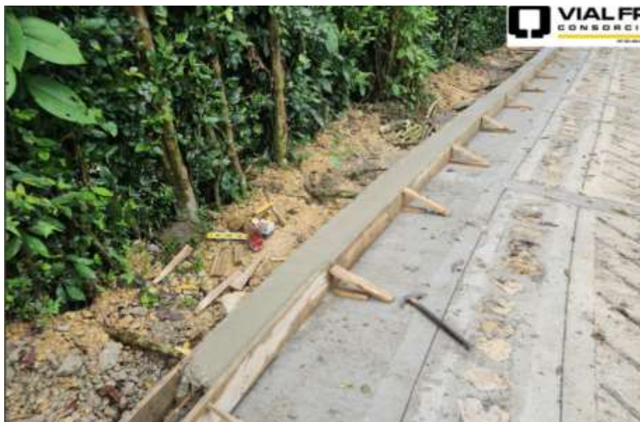
Extensión, conformación y compactación del tramo vial objeto de intervención. Vda Alianza, La Vega
