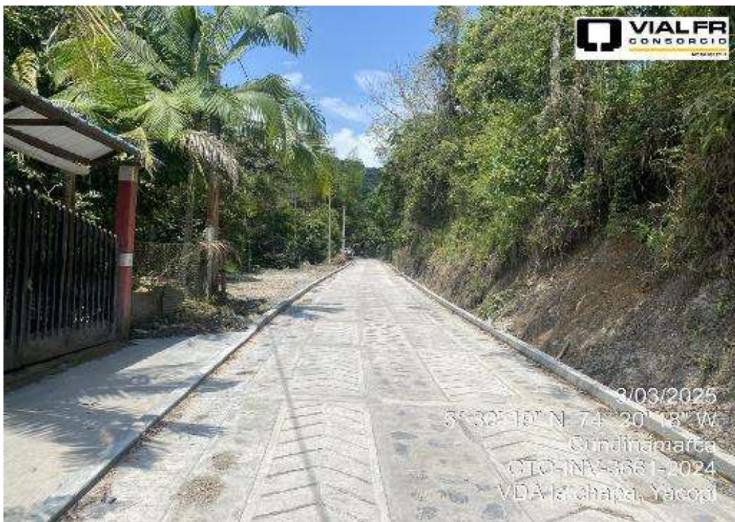
TERMINACION DE OBRA
