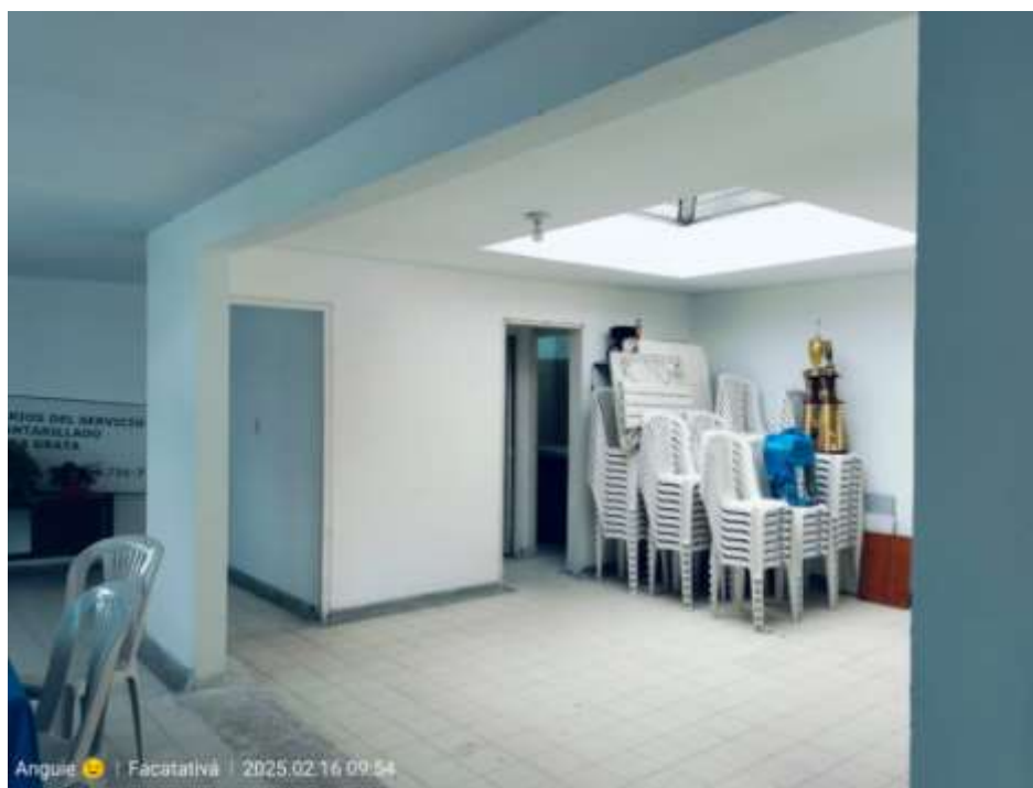
Actividades terminadas de remodelación en acueducto veredal (plan de inversión social). Vda Tierra Grata, Facatativá
