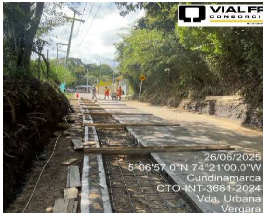
Avances de obra jun-2025. Vda Urbana, Vergara
