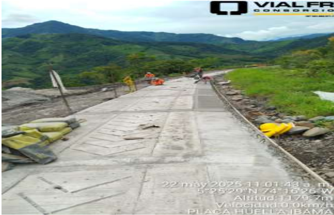
CONSTRUCCION DE CUNETA BERMA
