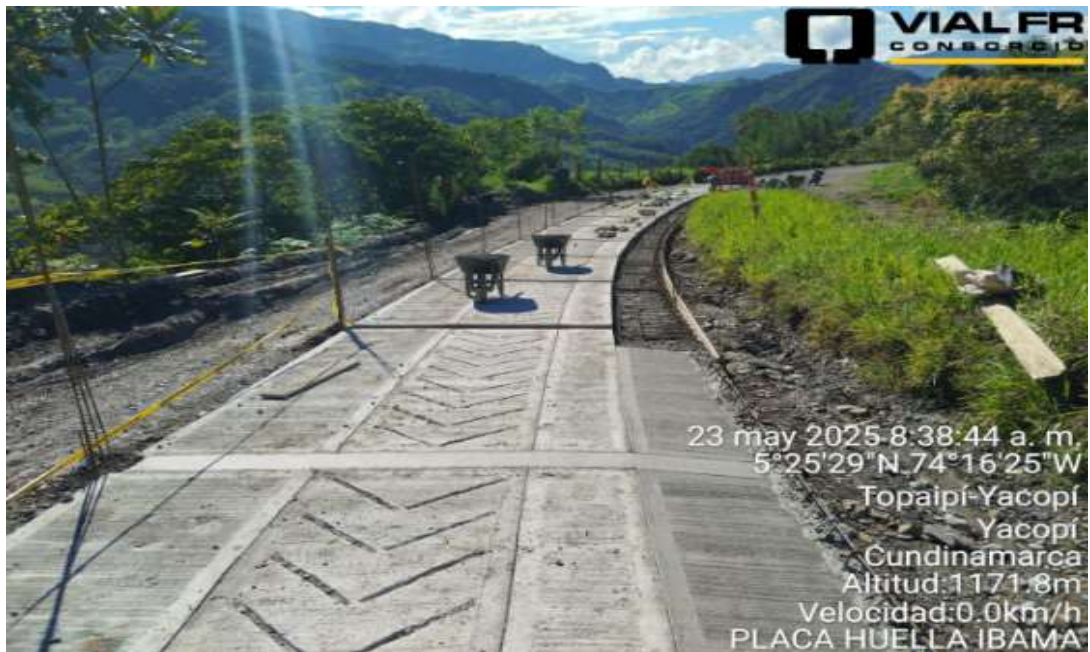
AVANCE GENERAL DE OBRA
