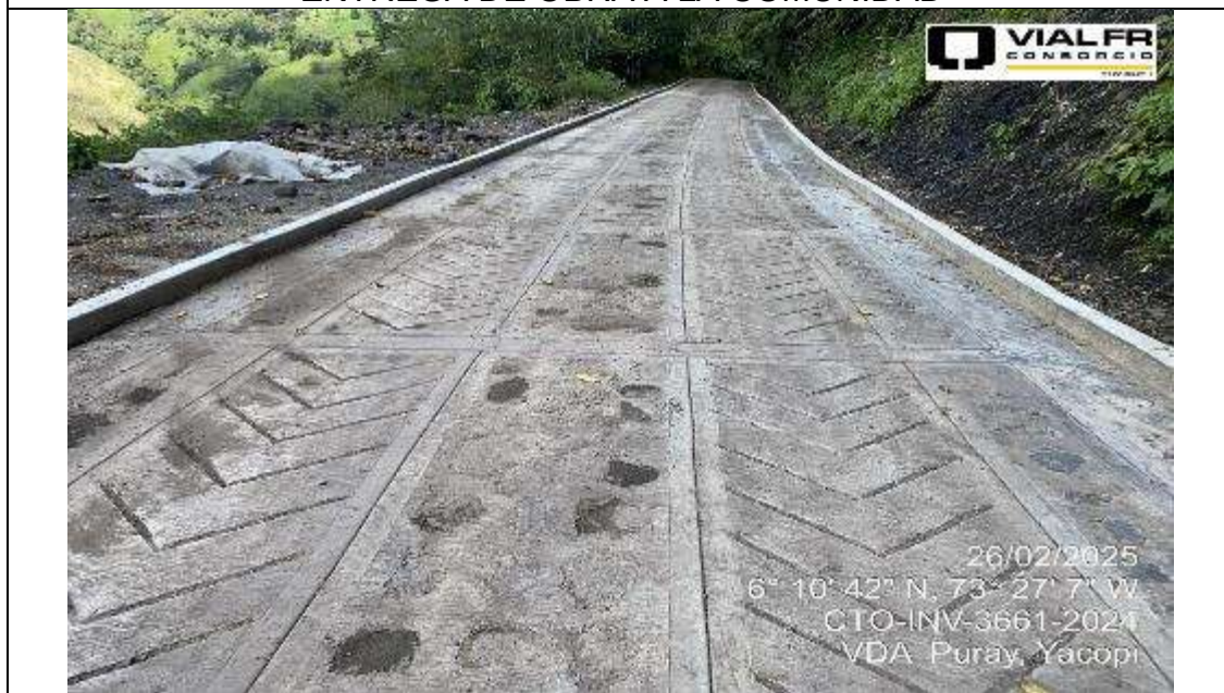
VISTA GENERAL DE LA OBRA
