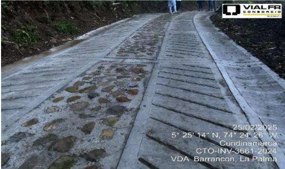
FUNDIDA DE CUNETAS
