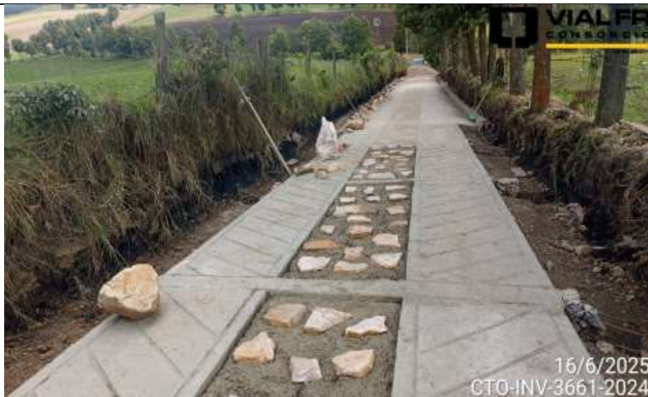
FUNDICIÓN DE CONCRETO CICLOPEO – FRANJA CENTRAL
