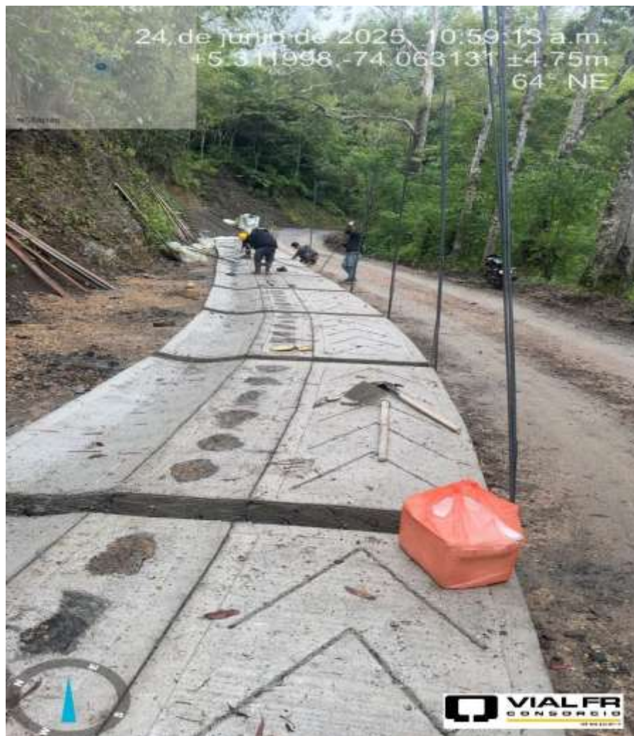
Avance general de obra a junio de 2025. Vda Centro Antiguo, San Cayetano
