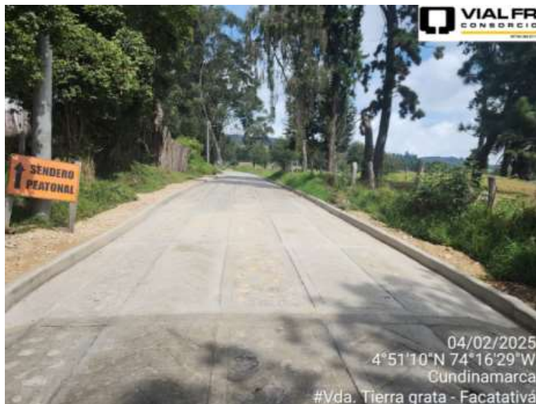
Placa huella terminada. Vda Tierra Grata, Facatativá
