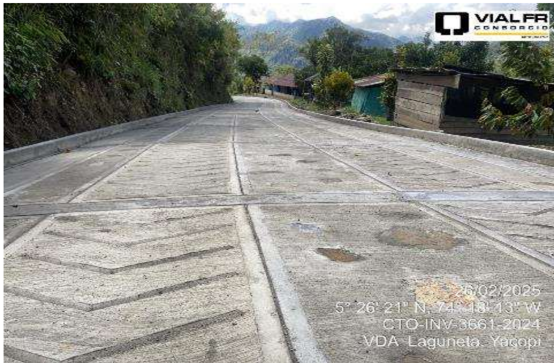
VISTA GENERAL DE OBRA
