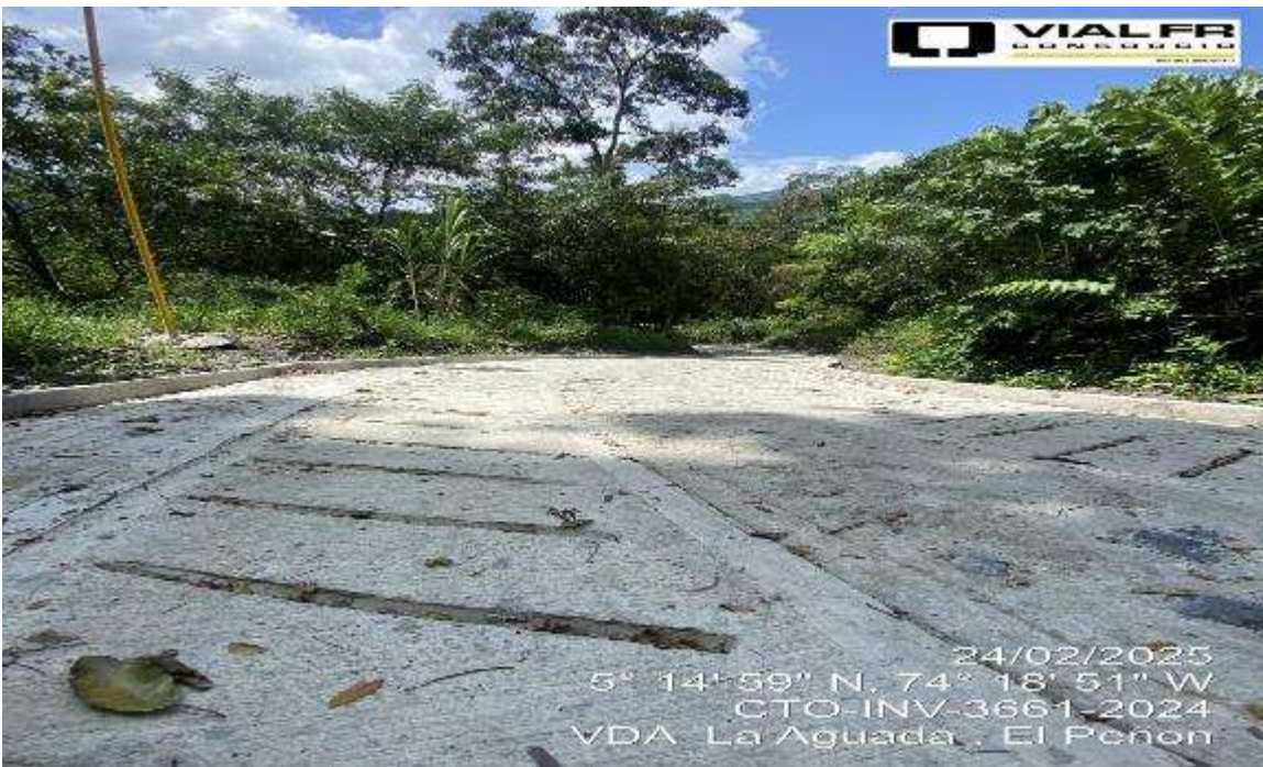
VISTA GENERAL DE LA PLACA HUELLA
