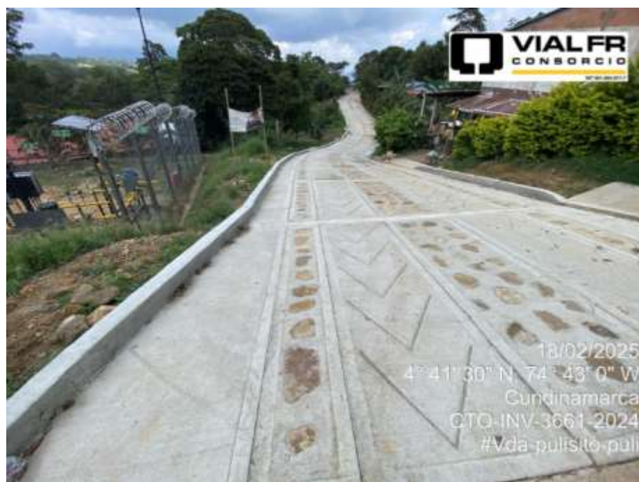
Placa huella terminada. Vda Pulisito, Pulí
