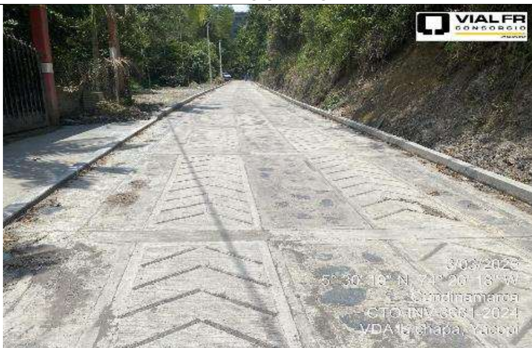
TERMINACION DE OBRA
