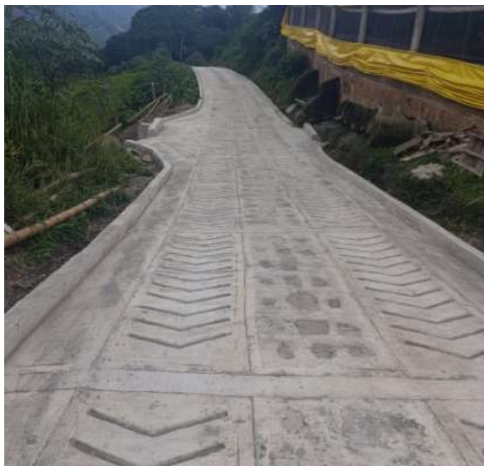
Placa huella terminada. Vda Robledal, Guayabal de Siquima
