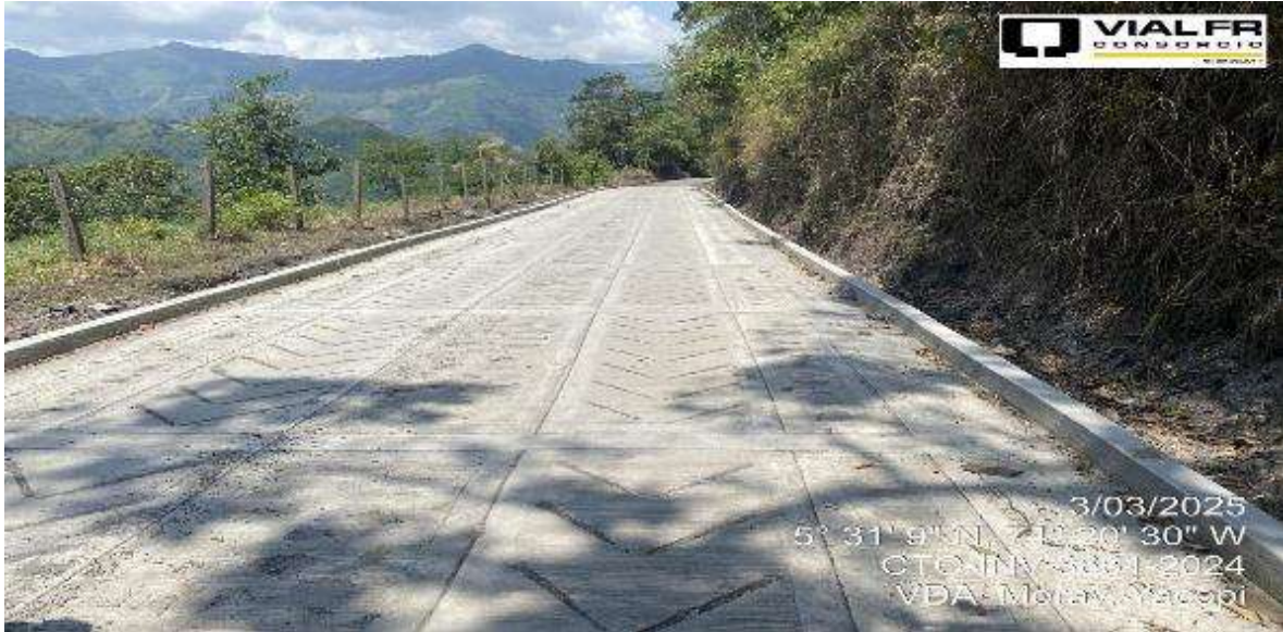
VISTA GENERAL DE OBRA
