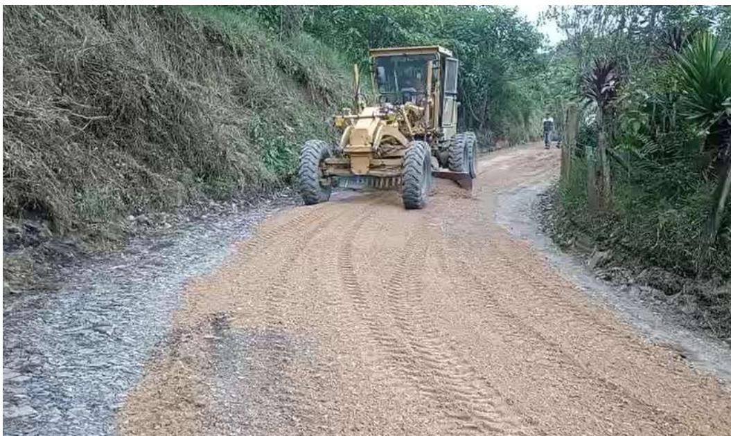
Extensión y conformación del tramo vial objeto de intervención. Vda Liria, San Cayetano
