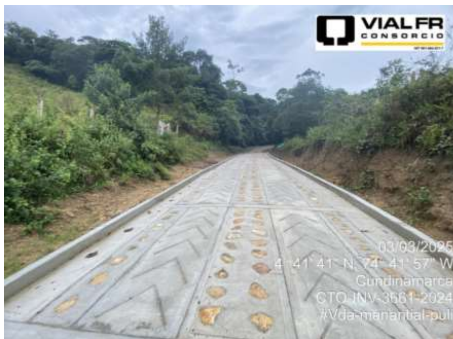
Placa huella terminada. Vda Manantial, Pulí
