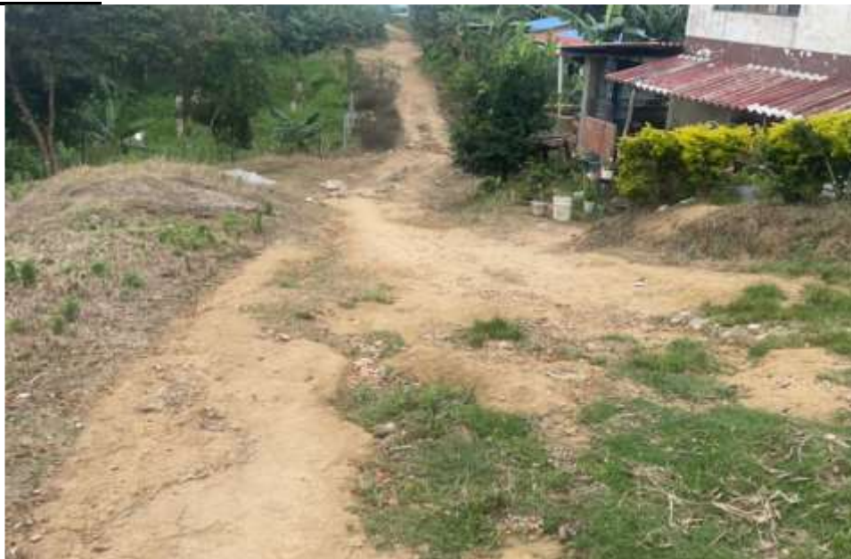
Estado inicial del tramo a intervenir. Vda Pulisito, Pulí
