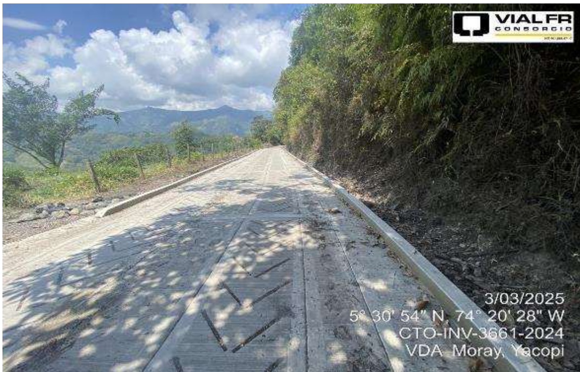
VISTA GENERAL DE OBRA
