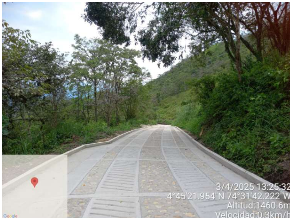
Placa huella terminada. Vda La Argentina, Quipile
