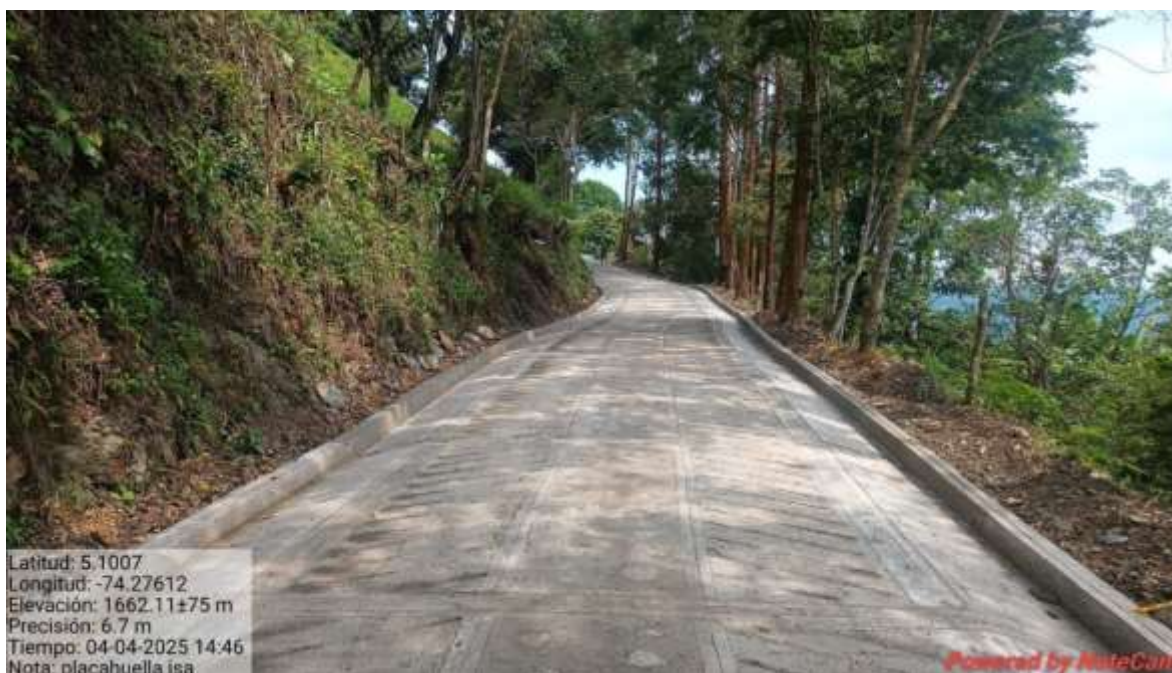
Placa huella terminada. Vda Imparal, Supatá
