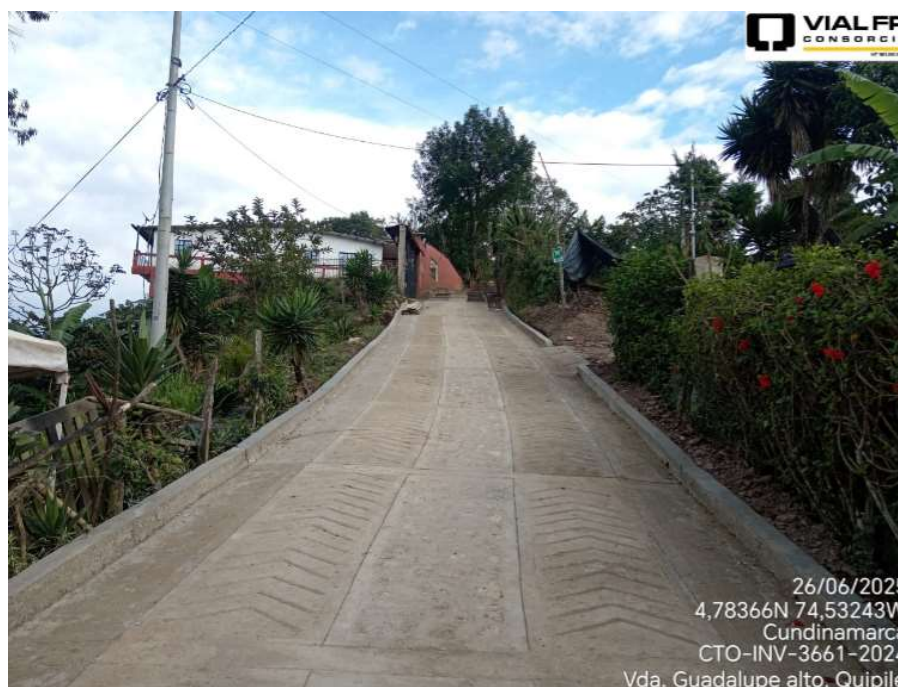
Avance general de la obra al jun-2025. Vda Guadalupe, Quipile
