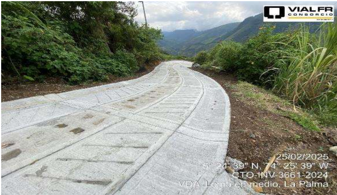
VISTA GENERAL DE OBRA
