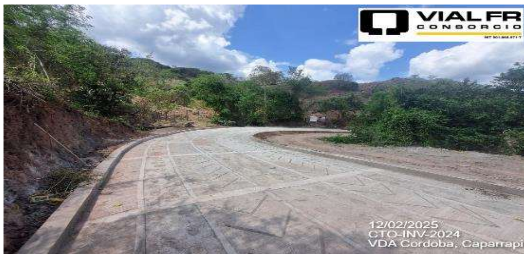
VISTA GENERAL PLACA HUELLA
