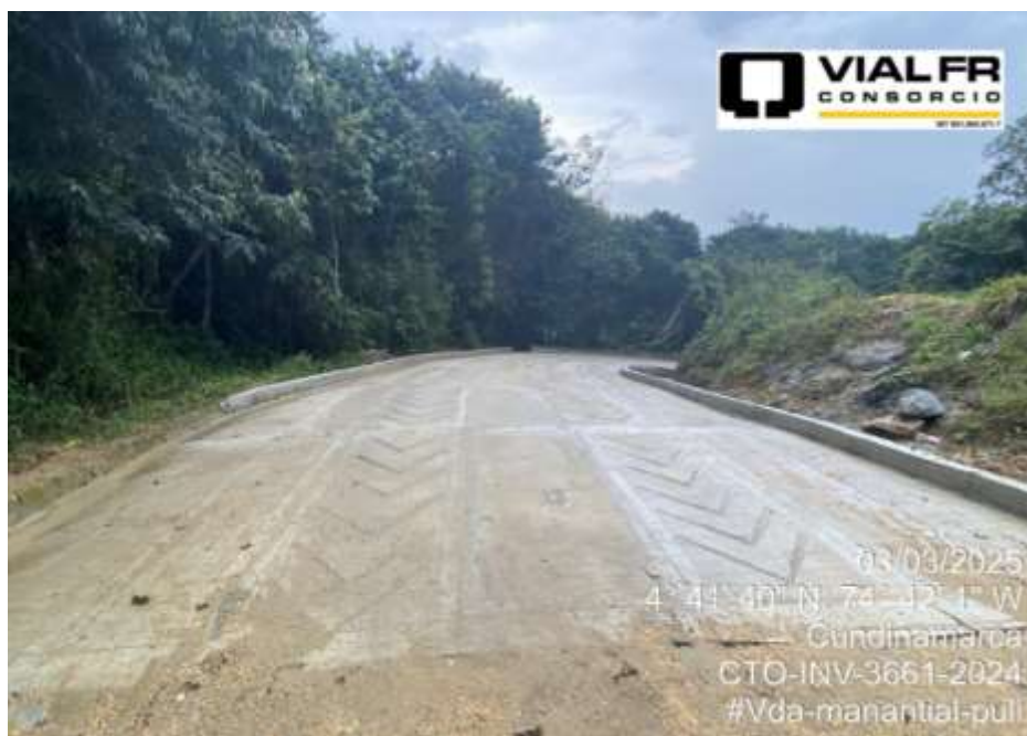
Placa huella terminada. Vda Manantial, Pulí
