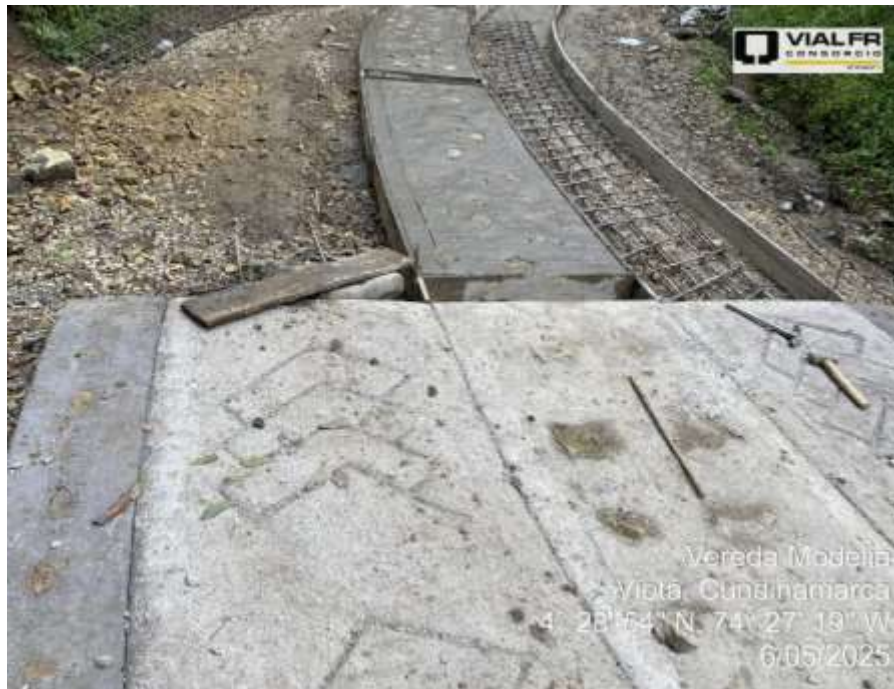
Avance general de obra con corte al 6-may-2025. Vda Modelia, Viotá
