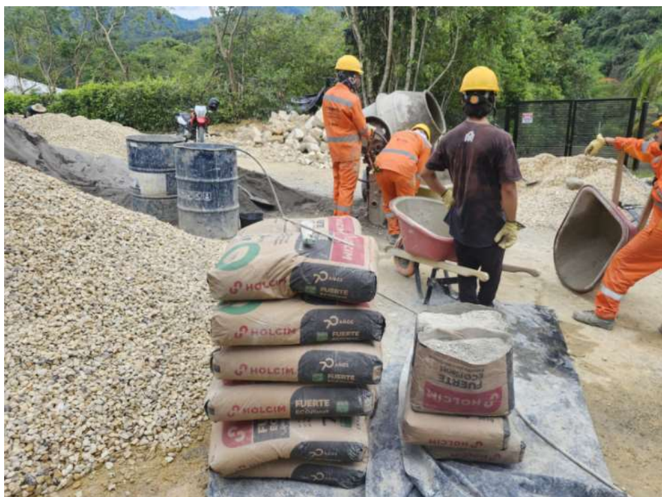
Conformación y replanteo del tramo vial objeto de intervención. Vda Alianza, La Vega
