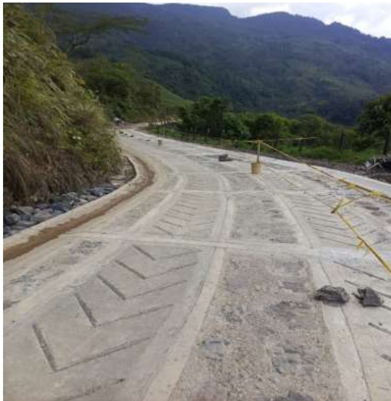
Placa huella terminada. Vda Camancha, San Cayetano
