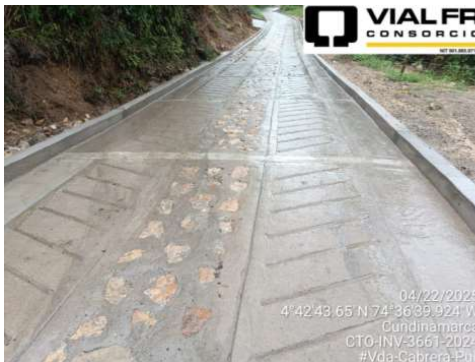
Placa huella terminada. Vda Cabrera, Pulí
