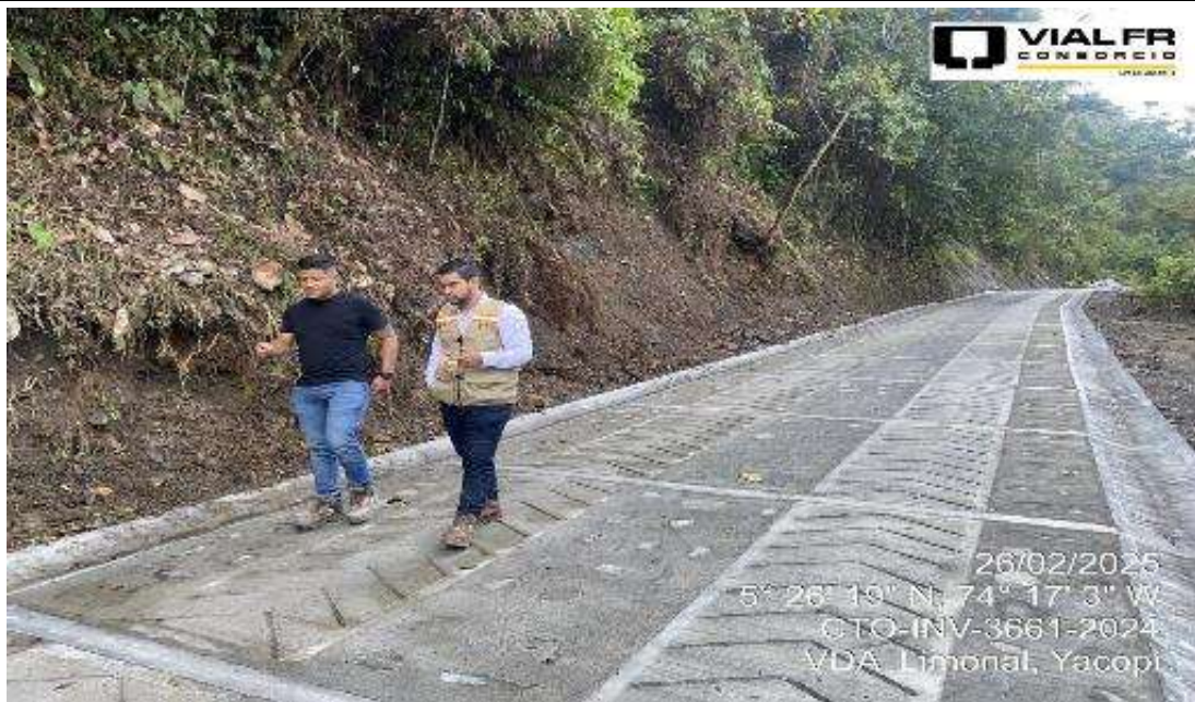
RECORRIDO DE OBRA CON EL RESIDENTE DE OBRA
