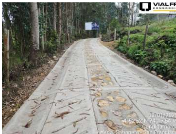
Estado final de la placa huella terminada. Vda Sabaneta, San Francisco
