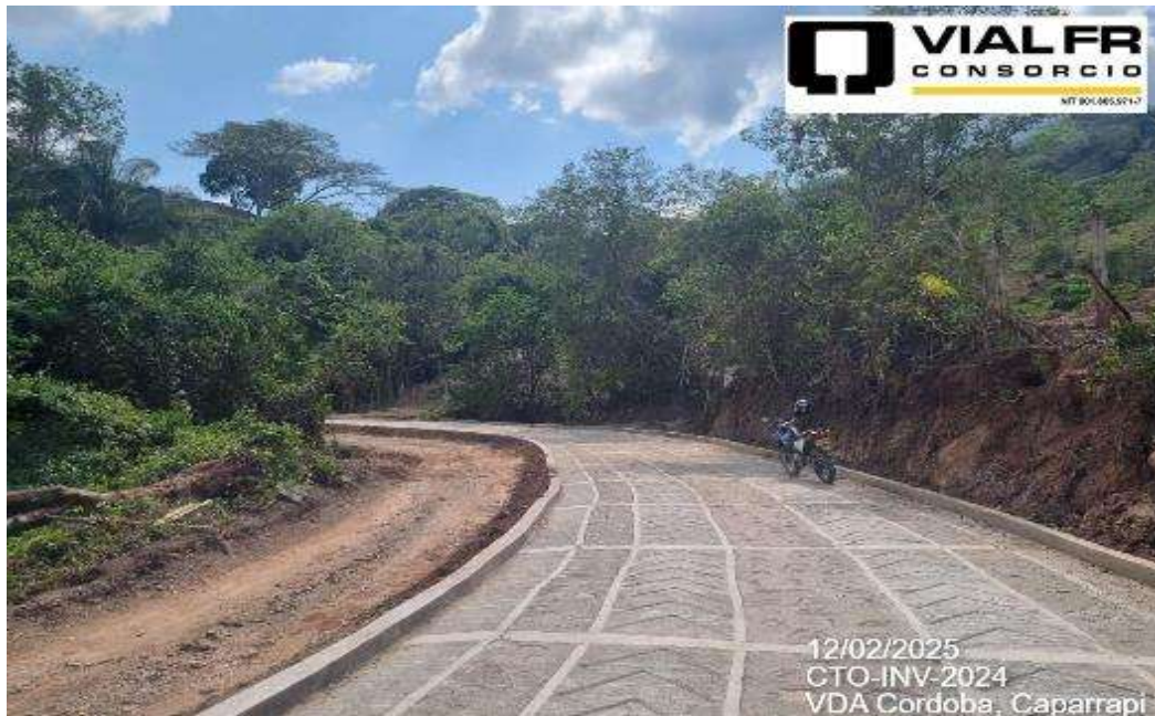
PLACA HUELLA TERMINADA
