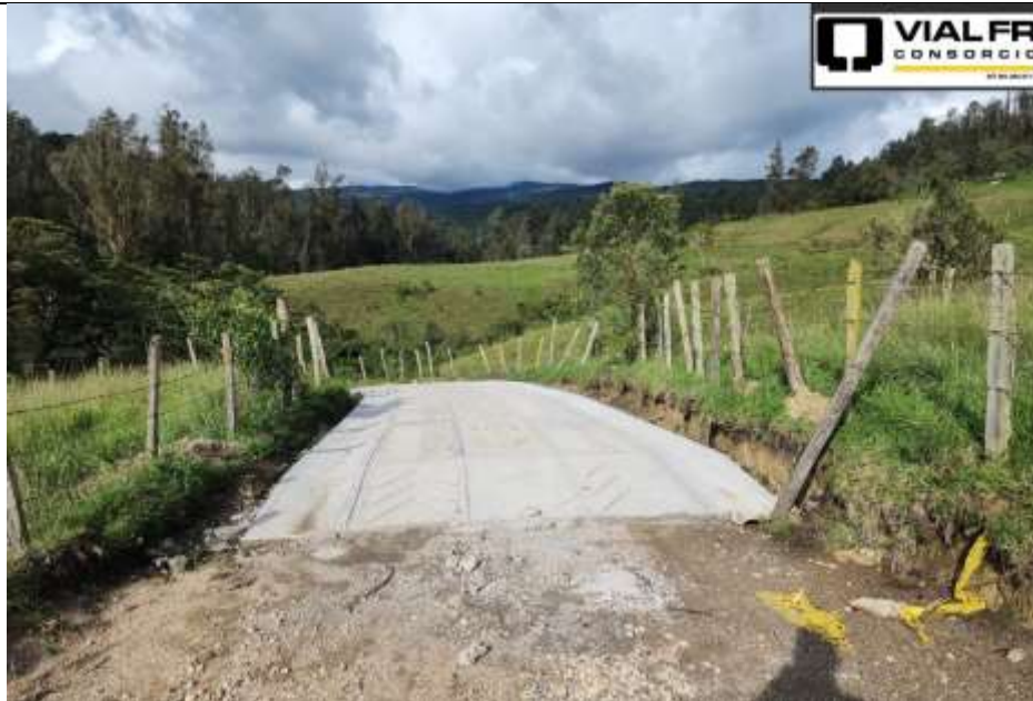
PLACA HUELLA – TRAMO 1
