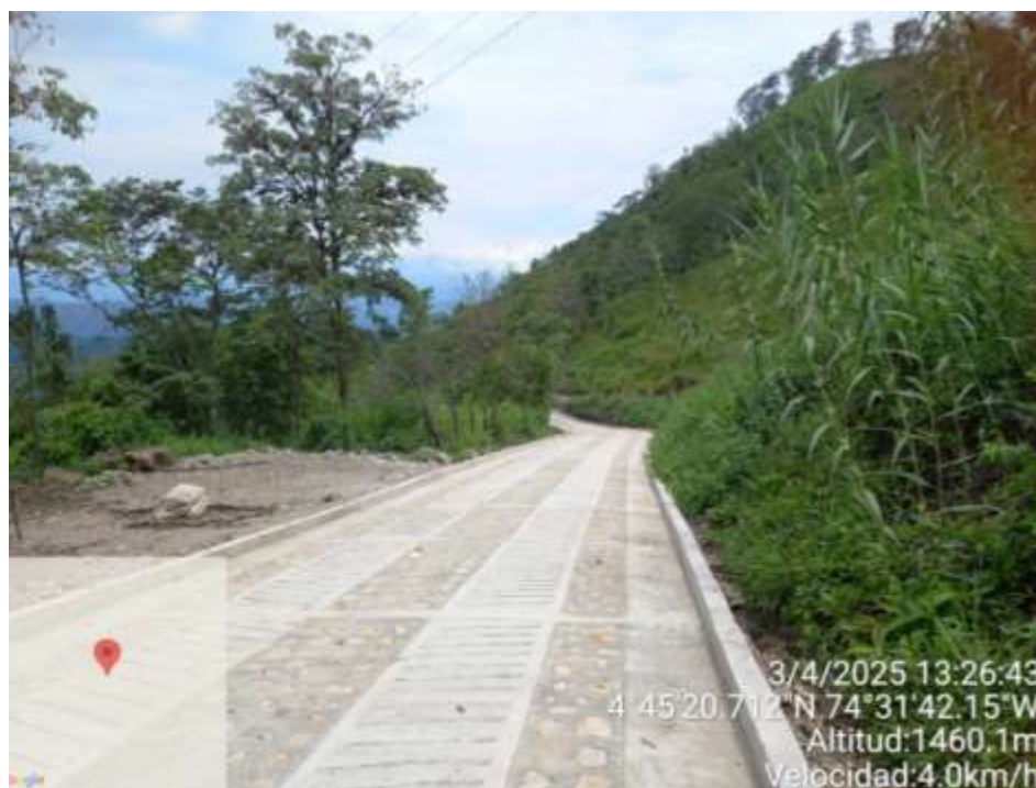
Placa huella terminada. Vda La Argentina, Quipile
