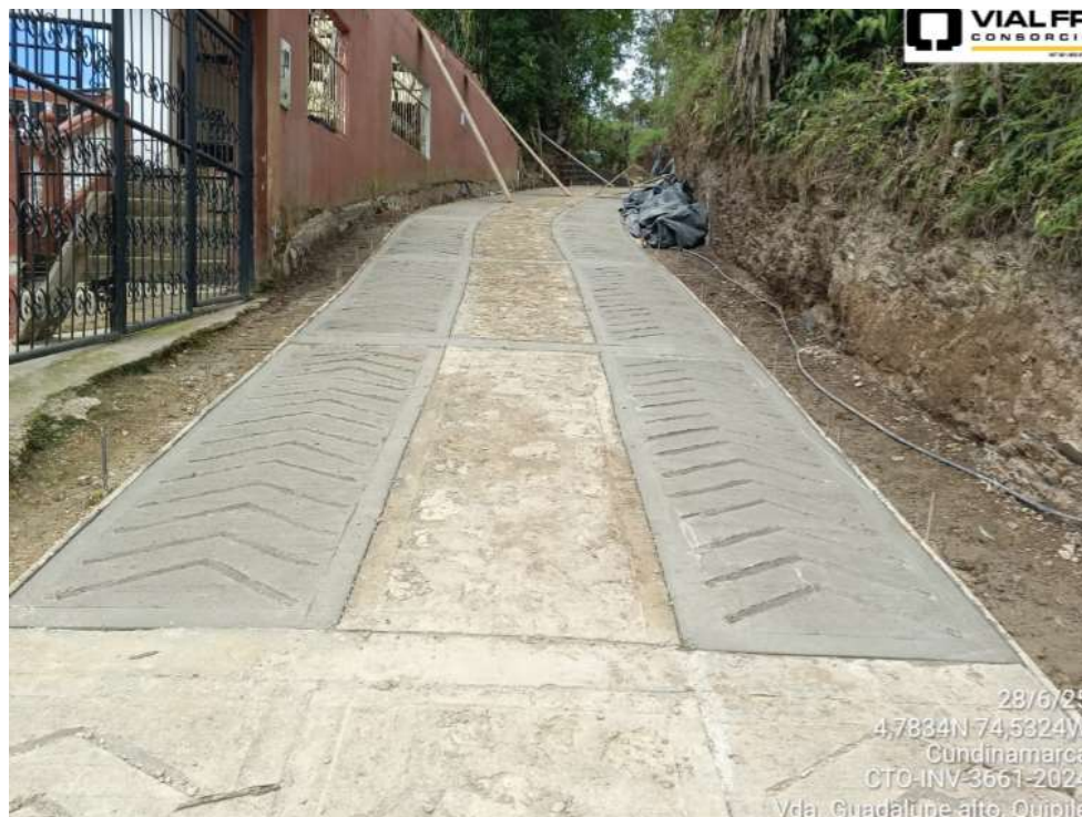
Avance general de la obra al jun-2025. Vda Guadalupe, Quipile
