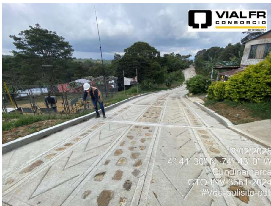
Estado final de la placa huella terminada. Vda Pulisito, Pulí
