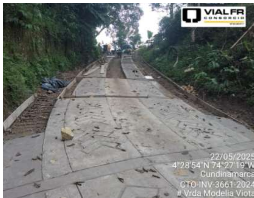
Avance general de obra con corte al 22-may-2025. Vda Modelia, Viotá
