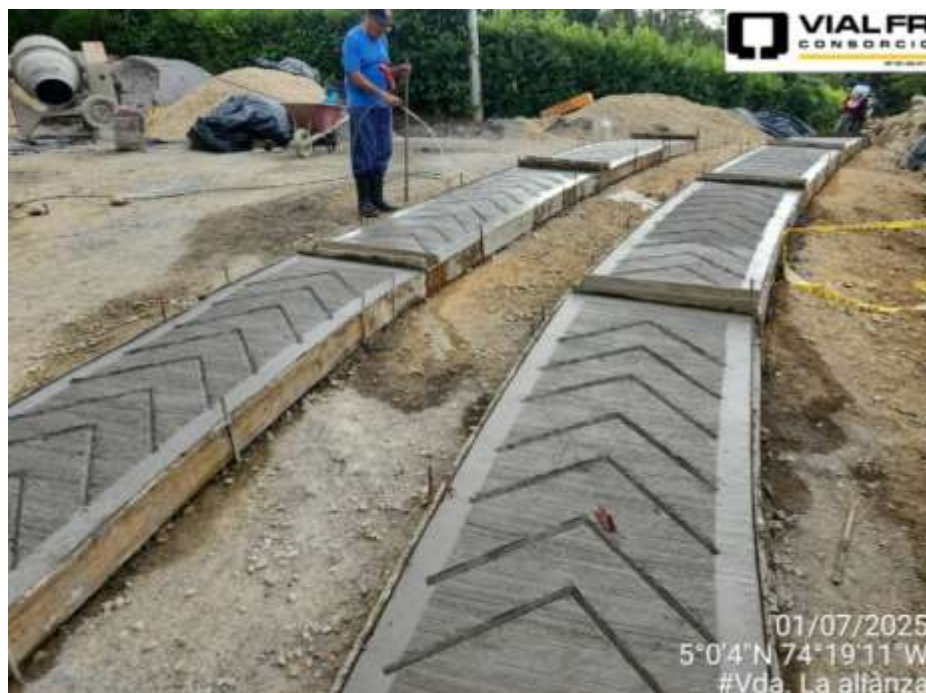
Amarre y armado de acero de refuerzo de elementos de placa huella. Vda Alianza, La Vega
