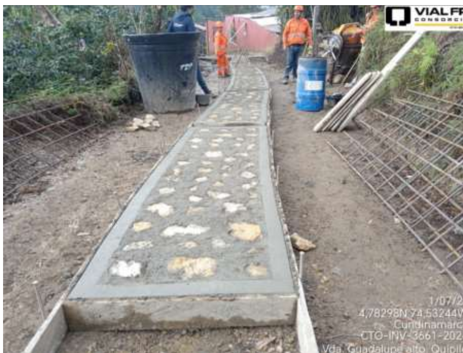
Vaciado de concreto de elementos de la placa huella. Vda Guadalupe, Quipile
