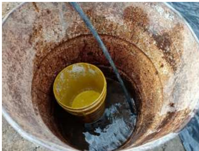
Ilustración 3. Tanque para almacenamiento de aguas lluvias
