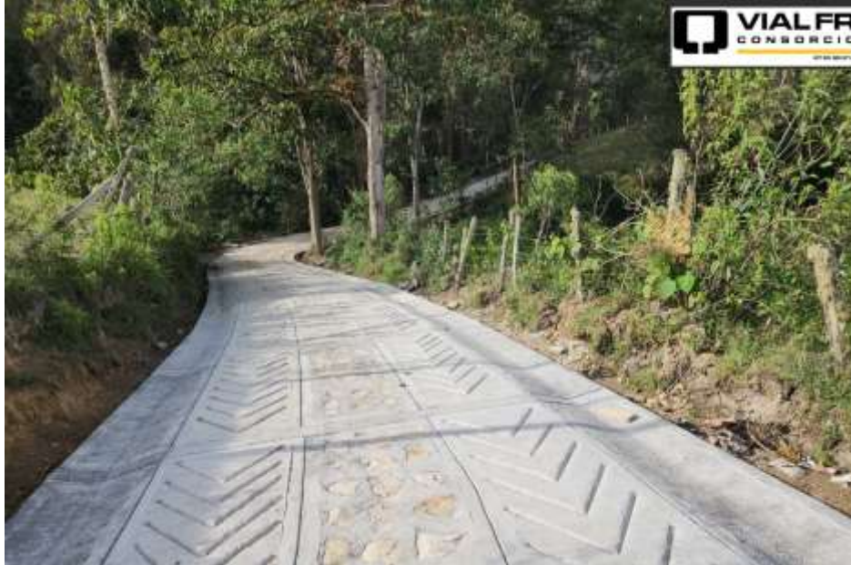
PLACA HUELLA – TRAMO 2
