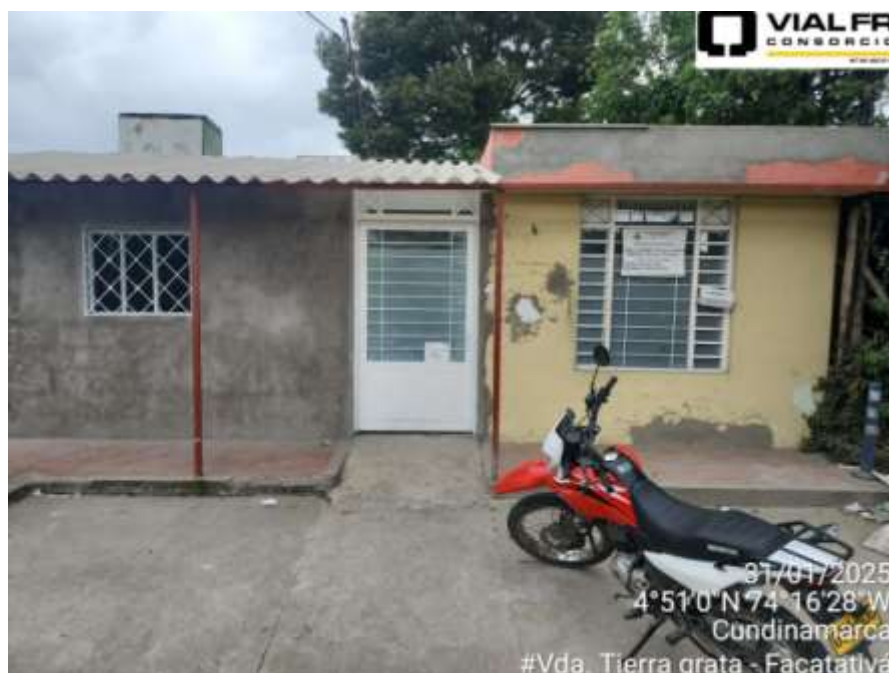
Actividades terminadas de ampliación en acueducto veredal (plan de inversión social). Vda Tierra Grata, Facatativá
