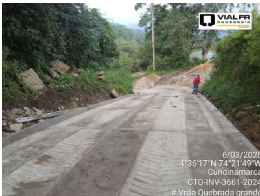
Placa huella terminada. Vda Quebrada Grande, San Antonio del Tequendama
