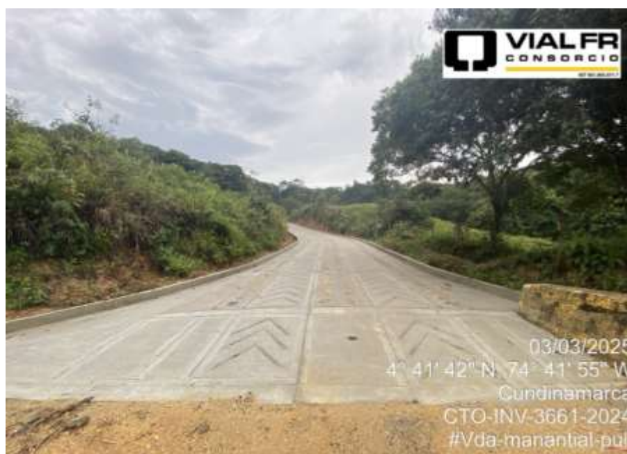
Placa huella terminada. Vda Manantial, Pulí
