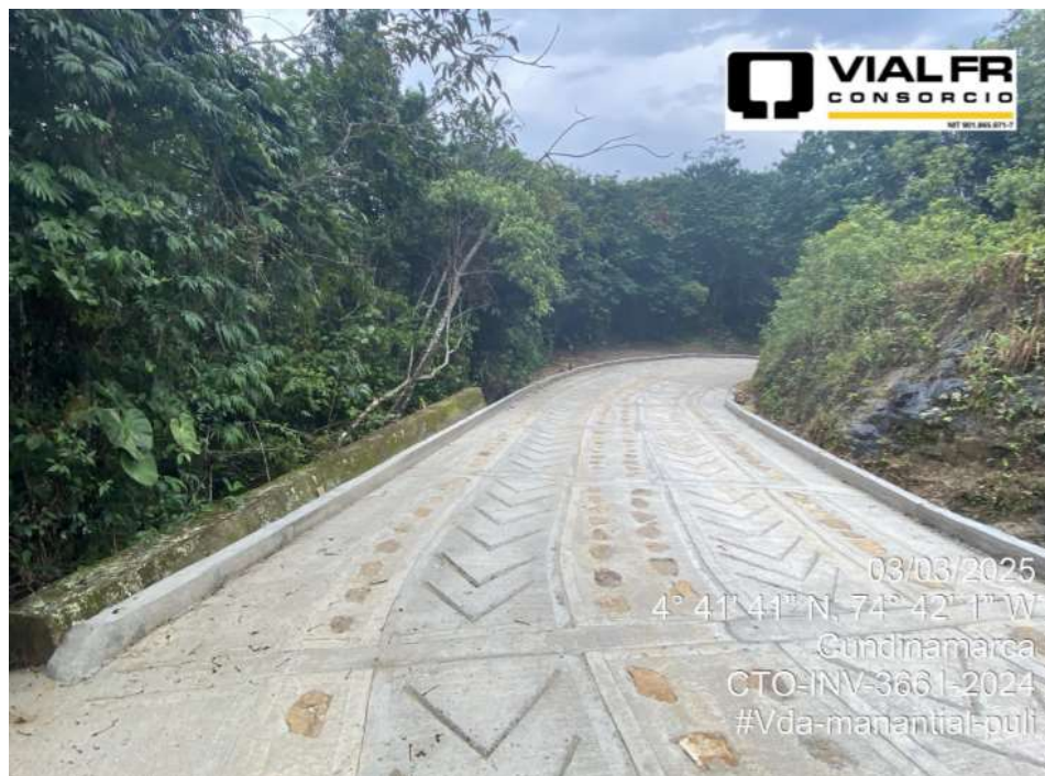
Placa huella terminada. Vda Manantial, Pulí
