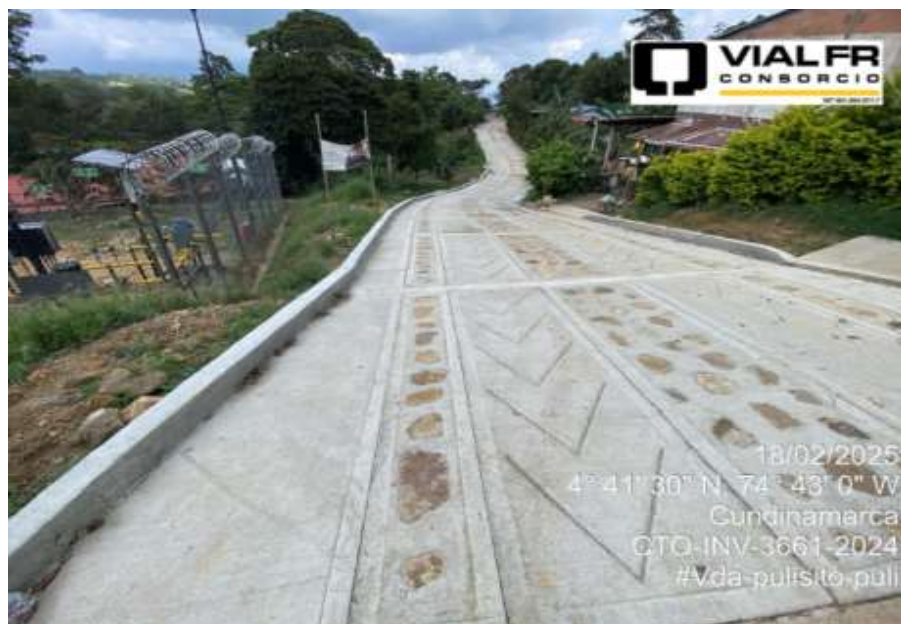
Placa huella terminada. Vda Pulisito, Pulí
