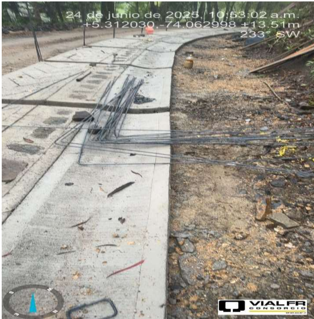
suministros de concretos del tramo vial objeto de intervención. Vda Centro Antiguo, San Cayetano
