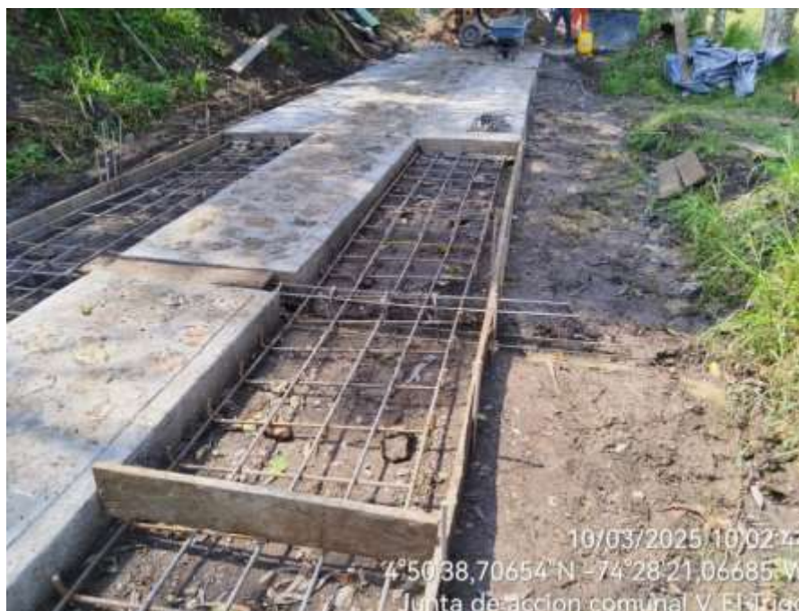
Avance general de obra con corte al 12-mar-2025. Vda Trigo, Guayabal de Siquima
