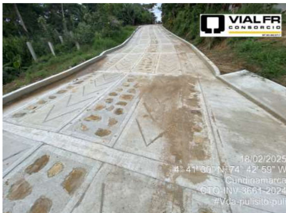
Placa huella terminada. Vda Pulisito, Pulí
