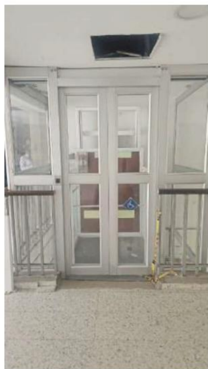
puerta de acceso segundo nivel
