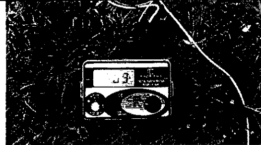
Medición de tierras: 7.7 Ohms de la torre. Requiere mejorar el sistema de tierra para proteger los equipos.
