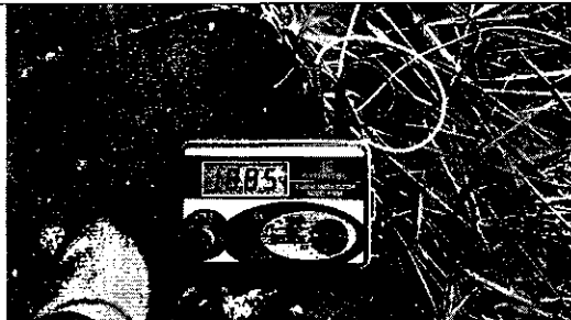
Medición de tierras: 18.85 Ohms del cuarto de equipos.
