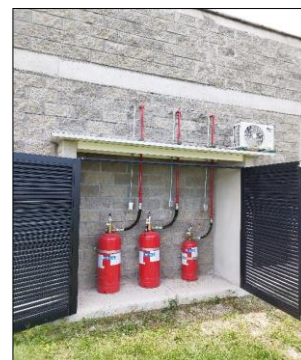
Imagen 9. Cuarto de cilindros para Agente Limpio
