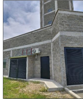
Imágen 12. Cuarto de Tableros Eléctricos
