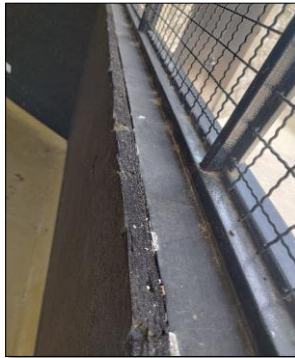
Imagen 2. Lámina de roca para protección acústica en Cuarto de Planta Eléctrica y Subestación Eléctrica.
