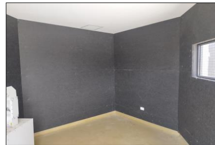
Imagen 3. Cuarto de Planta Eléctrica.
