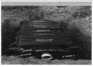
FECHA FOTO: 19/05/2025 DESCRIPCION: INSTALACIÓN Y NIVELACIÓN.
