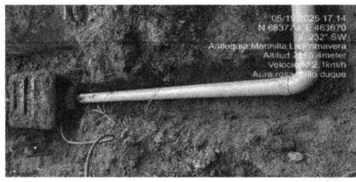
FECHA FOTO: 19/05/2025 DESCRIPCION: EXCAVACIÓN Y FIJACIÓN DE TUBERÍA.
