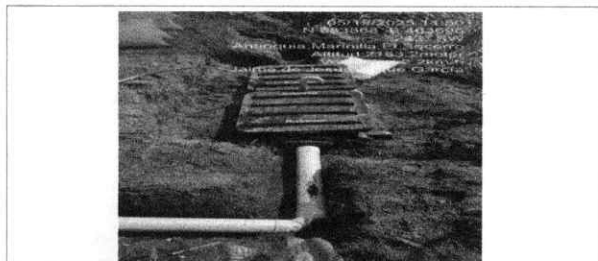
FECHA FOTO: 19/05/2025 DESCRIPCION: RELLENO CON MATERIAL DE SITIO Y CONEXIÓN
