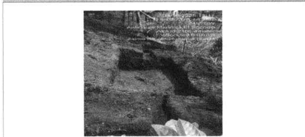
FECHA FOTO: 19/05/2025 DESCRIPCION: EXCAVACIÓN MANUAL PARA INSTALACIÓN DEL SISTEMA.
