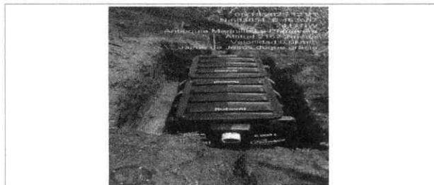
FECHA FOTO: 19/05/2025 DESCRIPCION: NIVELACIÓN E INSTALACIÓN DE POZO.
