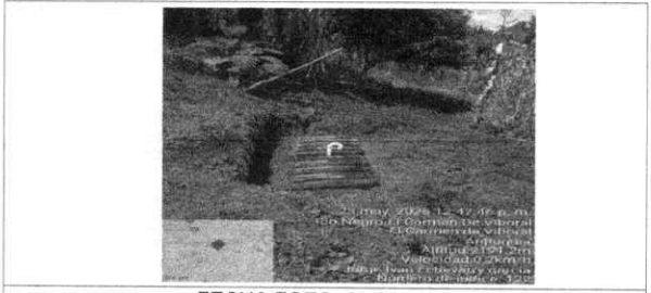
FECHA FOTO: 23/05/2025 DESCRIPCION: FINALIZACIÓN DE INSTALACIÓN.
