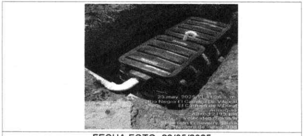
FECHA FOTO: 23/05/2025 DESCRIPCION: INSTALACIÓN Y NIVELACIÓN DE POZO SÉPTICO.
