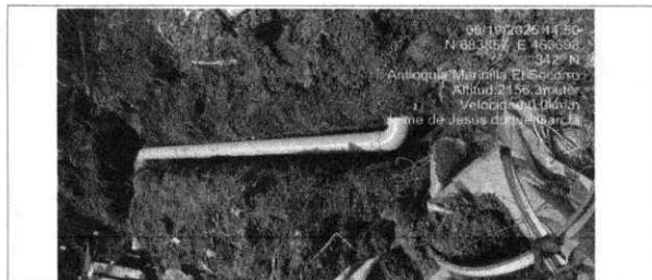
FECHA FOTO: 19/05/2025 DESCRIPCION: BRECHA E INSTALACIÓN DE TUBERÍA.
