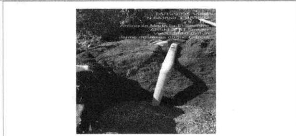
FECHA FOTO: 19/05/2025 DESCRIPCION: LLENO CON MATERIAL GRANULAR TRITURADO.
