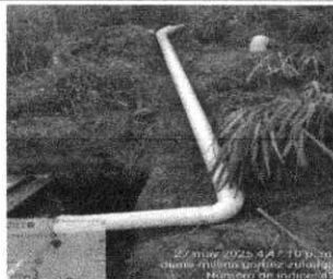
FECHA FOTO: 27/05/2025 DESCRIPCION: PUNTOS DE ANCLAJE.
