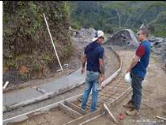
El contratista funde la huella izquierda de 3000 psi (0,15m x0,90m x 3.0 mx 20 ) en el tramo No 5 L = 240 m aproximadamente en el sector del codito San Daniel.
