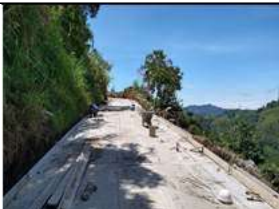
El contratista realiza la instalación de la formaleta de madera para bordillos en ambos costados en una distancia de 30m en concreto de 3000 psi en el tramo No 5 de placa huella de los 240 m proyectados para el sector del codito San Daniel.
