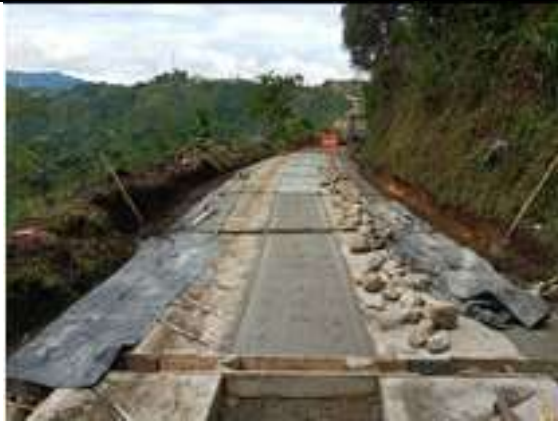
El contratista funde la huella central en concreto ciclópeo (40 m) (13 x 0.15 m x 3.00 m x 0.90 m) en el tramo No 5 de placa huella de los 240 m proyectados para el sector del codito San Daniel.
