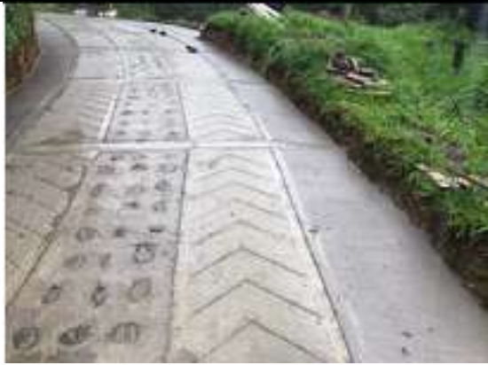
El contratista realiza instalación de concreto para berna cuneta 13 \times 0,95 \times 0,15 = 1,85 \text{ m}^3 costado derecho con un ancho de 3000 Psi tramo 3 Pr 7+000 al Pr 7+075 Vereda el Placer de 75 metros.
