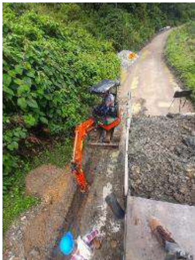
Construcción de Filtro de 40ml sector La Brillantina
