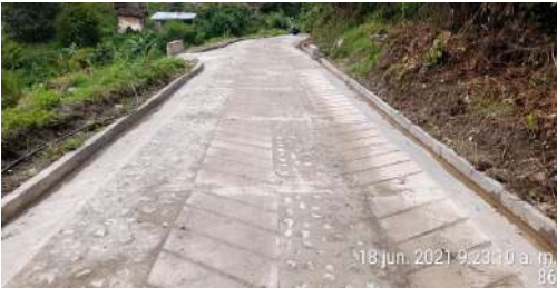
Placa huella 40m finalizada sector La brillante - K4+600
