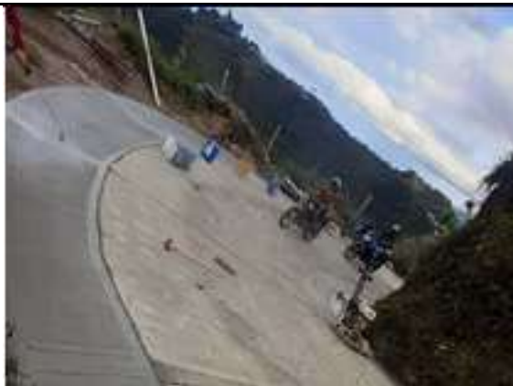
El contratista funde las cunetas de los dos lados de la placa huella en concreto de 3000 psi en el tramo No 5 de placa huella de los 240 m proyectados para el sector del codito San Daniel.
