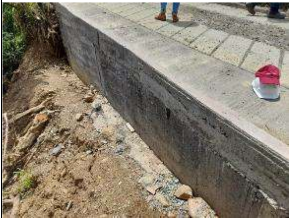
Estructura de soporte de cuneta sector Pisamal
