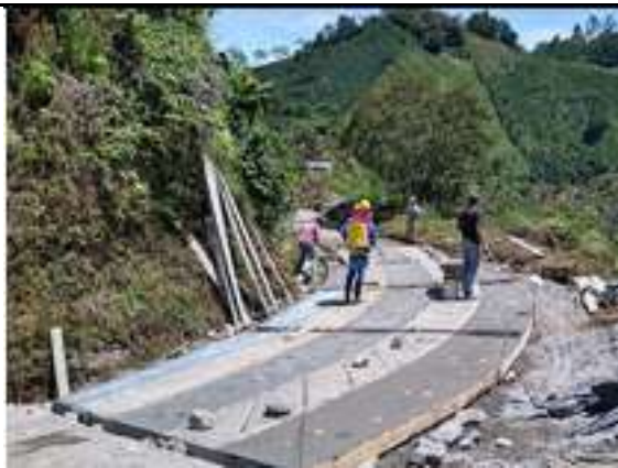
El contratista realiza la fundida de la huella central y el sobre anchos en concreto ciclópeo una distancia 20 m en el tramo No 5 de placa huella de los 240 m proyectados para el sector del codito San Daniel.
