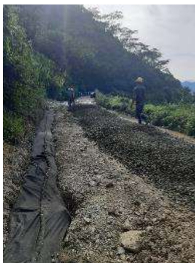
Construcción de Filtro y extensión de subbase sector La Brillantina
