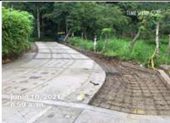
El contratista realiza instalación de acero para berna cuneta 18 m costado derecho con un ancho de 0,65 m tramo 3 Pr 7+000 al Pr 7+075 Vereda el Placer de 75 metros.
