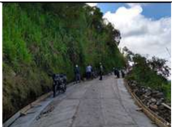
El contratista instala la formaleta y acero de refuerzo No 3 para el bordillo en ambos lados concreto de 3000 psi en 60 mt en el tramo No 5 L = 240 m aproximadamente en el sector del codito San Daniel.
