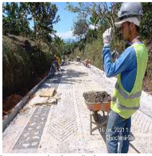
Relleno en costados de sardinel tramo 11
