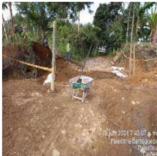
Relleno con material granular sobre tubería de alcantarilla tramo 11
