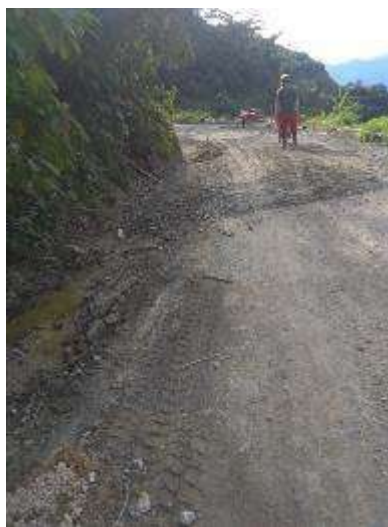
Instalación de subbase sector La Brillantina
