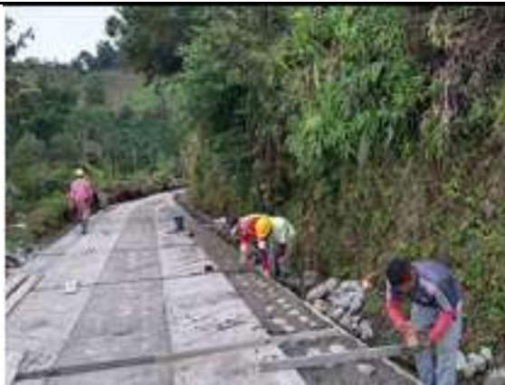
El contratista funde el sobre ancho derecho de en concreto ciclópeo en el tramo No 5 L = 240 m aproximadamente en el sector del codito San Daniel.
