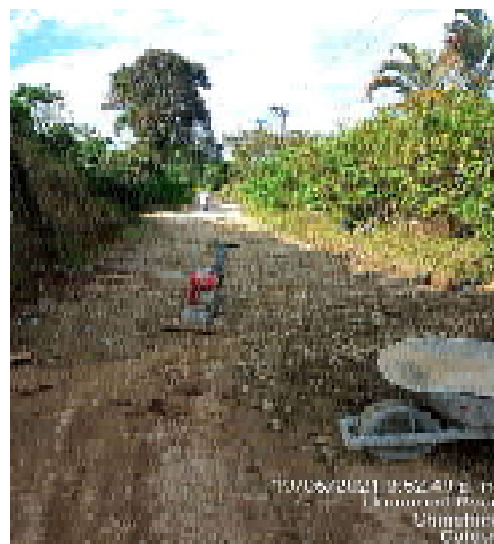
Adición y compactación de material granular en zona de mantenimiento
