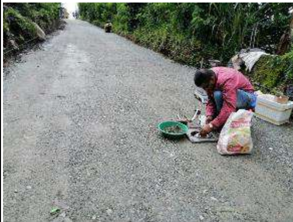
Instalación De Subbase sector El Diamante
