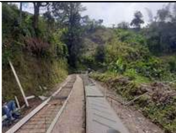
El contratista realiza la instalacion de la formaleta para las huellas en concreto de 3000 psi una distancia 40 m en el tramo No 5 de placa huella de los 240 m proyectados para el sector del codito San Daniel.
