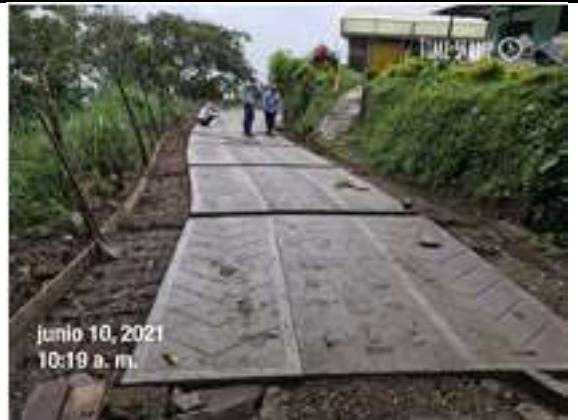
El contratista realiza instalación de acero para berna cuneta 15 m costado izquierdo con un ancho de 0,70 m tramo 3 Pr 7+000 al Pr 7+075 Vereda el Placer de 75 metros.
