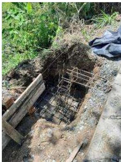
Instalación acero de refuerzo Soporte Cunetas
