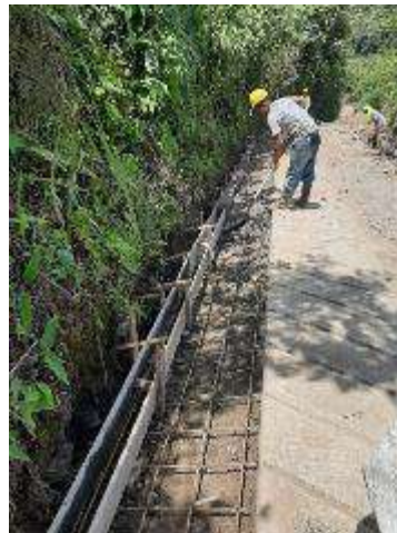
Concreto cuneta izquierda sector Pisamal
