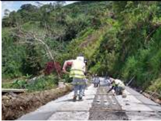
El contratista funde la huella en concreto ciclópeo ( 3 m x 0,90 m x 0,15 m x 20) concreto de 2000 psi en 60 mt en el tramo No 5 L = 240 m aproximadamente en el sector del codito San Daniel.
