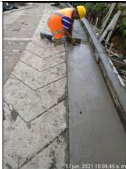
Tramo 3: Fundición de berma cuneta y bordillo
