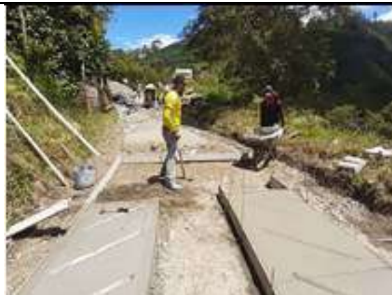
El contratista realiza la fundida de las huellas en concreto de 3000 psi (0,90 m x 3,00m x 0,15 m x 6 módulos) en una
