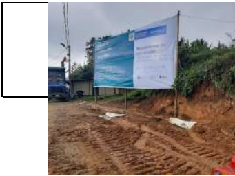
Instalación Valla Informativa sector Guayacanes - K15+000
