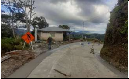
el contratista funde las cunetas de los dos lados de la placahuella en concreto de 3000 psi en el tramo No 5 de placahuella de los 240 m proyectados para el sector del codito San Daniel.
