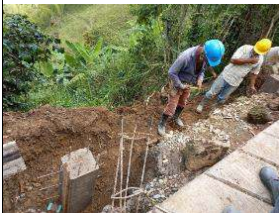
Enrocado Franja central Tramo Pisamal
