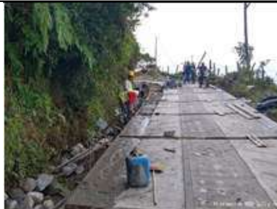
El contratista funde el sobre ancho derecho de en concreto ciclópeo en el tramo No 5 L = 240 m aproximadamente en el sector del codito San Daniel.
