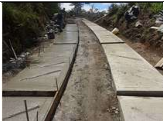
El contratista funde la huella izquierda en ( 3 m x 0,90 m x 0,15 m x 20) concreto de 3000 psi en 60 mt en el tramo No 5 L = 240 m aproximadamente en el sector del codito San Daniel.
