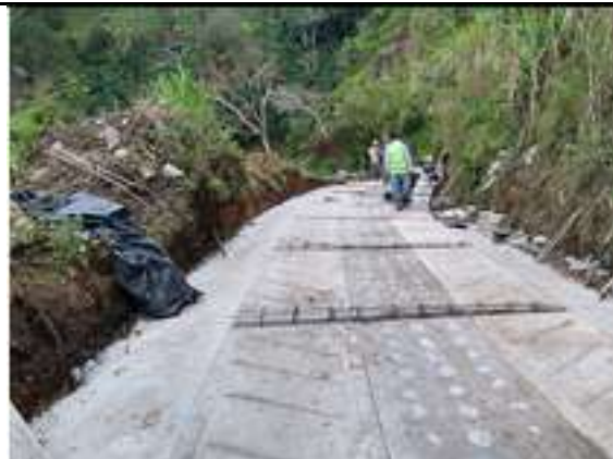
El contratista instala el acero de refuerzo y funde la viga riostra en concreto de 3000 psi ( 4,5 m x 0,20 m x 0,25 m x
