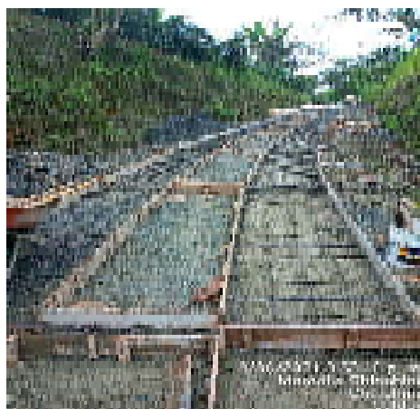
Instalación de acero en ambos sentidos para placa huella tramo 11
