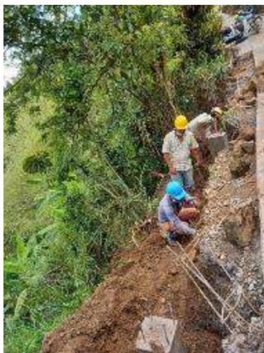
Columnas Soporte de cunetas Tramo Pisamal
