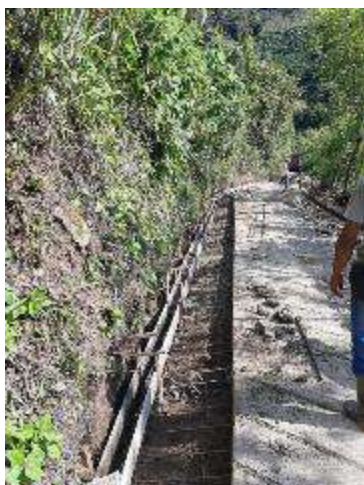
Concreto Cuneta Izquierda sector Pisamal
