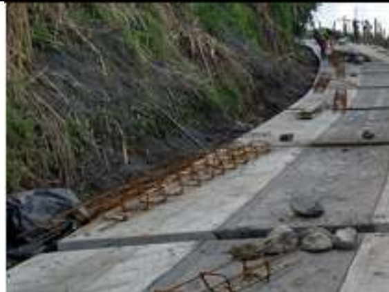
El contratista realiza la instalación del acero de refuerzo No 3 para vigas de amarre de (0,20 m x 0,25 m x 4,40 m X 19 vigas) en una distancia 60 m en el tramo No 5 de placa huella de los 240 m proyectados para el sector del codito San Daniel.
