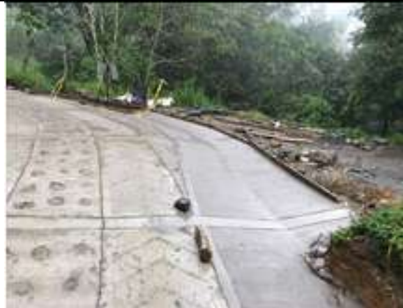
contratista realiza instalación de concreto para sobre ancho de 10 \times 1,50 \times 0,15 = 2,25 \text{ m}^3 costado derecho de 3000 Psi tramo 3 Pr 7+000 al Pr 7+075 Vereda el Placer de 75 metros.
