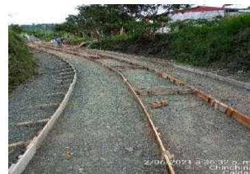
Imagen 3. Armado de formaletas y aceros de refuerzo para placa huella (K8+030)
