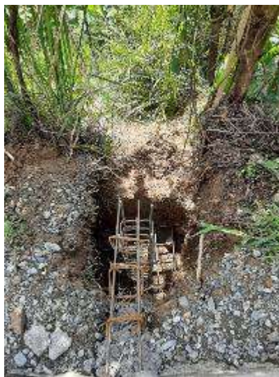
Instalación acero de refuerzo Soporte Cunetas
