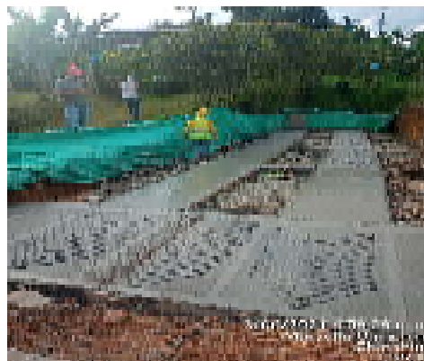
Cerramiento con polisombra para proteger el concreto fresco
