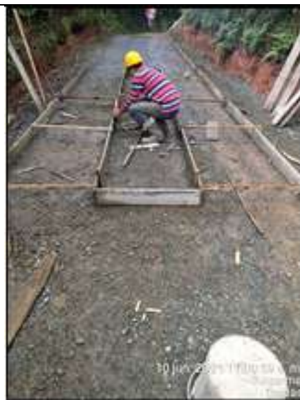
Tramo 3: Instalación de formaletas en placa huellas
