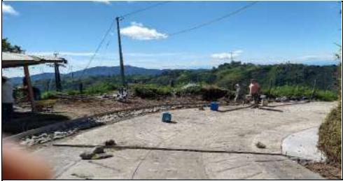
el contratista realiza el replanteo de la cuneta derecha en concreto de 3000 psi en el tramo No 5 de placahuella de los 240 m proyectados para el sector del codito San Daniel.
