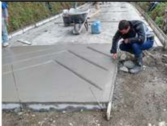
El contratista funde la placa de acceso en concreto de 3000 psi (0.15 m x 3.00 m x 2.70 m) en el tramo No 5 de placa huella de los 240 m proyectados para el sector del codito San Daniel. PR 13+000 al PR 13+240.
