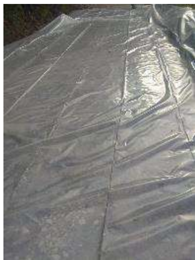
Protección de subbase sector La Brillantina
