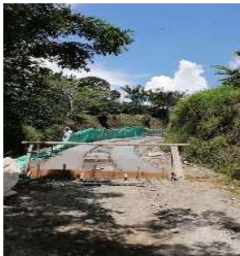
Cerramiento de obra para proteger concreto fresco tramo 11
