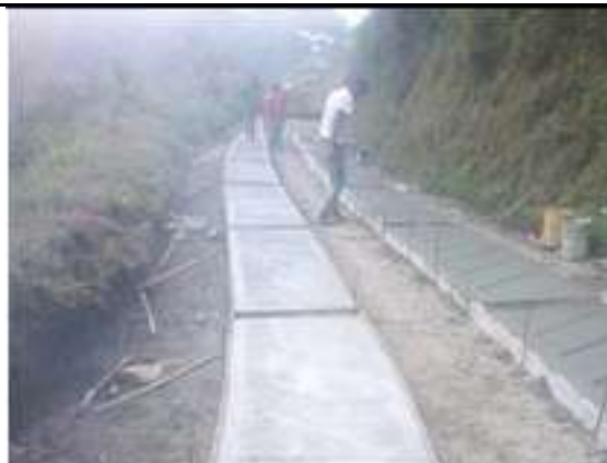
El contratista funde las huellas en concreto de 3000 psi (40 m) (26 x 0.15 m x 3.00 m x0.90 m) en el tramo No 5 de placa huella de los 240 m proyectados para el sector del codito San Daniel.
