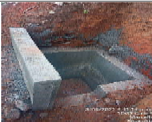
Desmantelación de formaletas en poseta de alcantarilla
