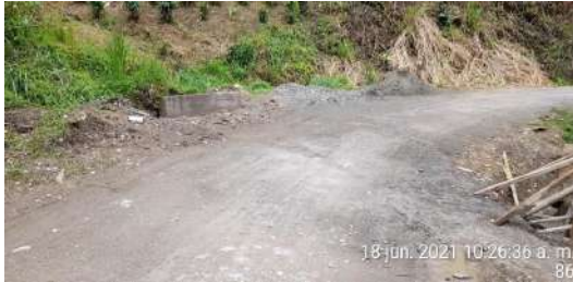
Alcantarilla Travesía de los González - K9+800
