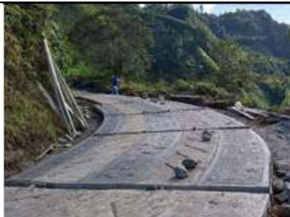
El contratista realiza la fundida de los huella central y sobre anchos en concreto ciclópeo una distancia 20 m en el tramo No 5 de placa huella de los 240 m proyectados para el sector del codito San Daniel.
