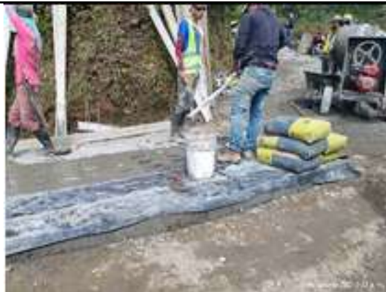
El contratista funde la huella central en concreto ciclópeo 2000 psi (0,15m x0, 90m x 3.0 mx 20) en el tramo No 5
