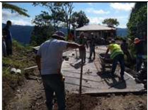
el contratista realiza el replanteo de la cuneta derecha en concreto de 3000 psi en el tramo No 5 de placa huella de los 240 m proyectados para el sector del codito San Daniel.
