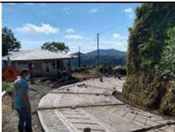
El contratista realiza el replanteo de la cuneta derecha en concreto de 3000 psi en el tramo No 5 de placa huella
