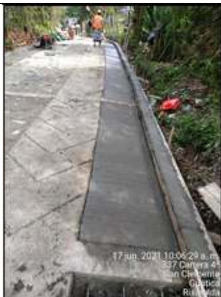
Tramo 3: Fundición de berma cuneta y bordillo
