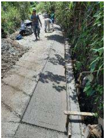
Concreto Cuneta Izquierda sector Pisamal
