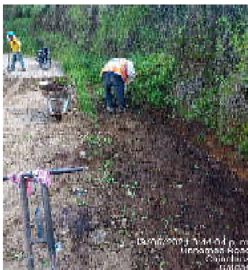
Remoción de vegetación en costados de la vía
