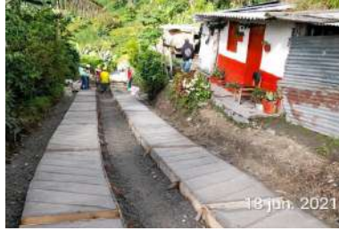
Construcción Placa Huella 80m El Diamante - K10+800
