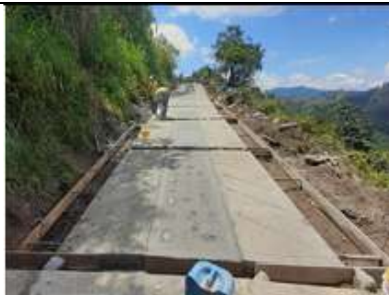
El contratista instala la formaleta y acero de refuerzo No 3 para cunetas de ( 3 m x 0,60 m x 0,15 m x 20) concreto de 3000 psi en 60 mt en el tramo No 5 L = 240 m aproximadamente en el sector del codito San Daniel.
