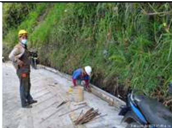
El contratista instala la formaleta y acero de refuerzo No 3 para el bordillo en ambos lados concreto de 3000 psi en
