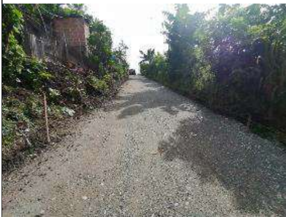
Instalación De Subbase sector El Diamante
