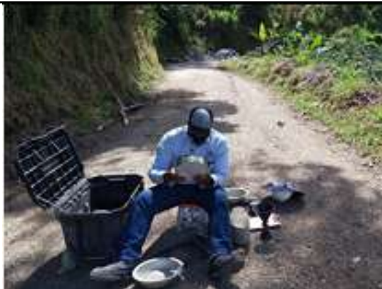
La interventoría realiza la toma de densidades por parte del laboratorio Ingeniería y Laboratorio de Materiales S.A.S. en
