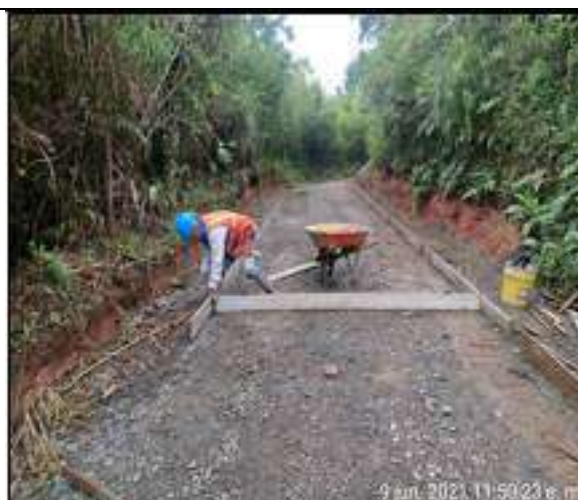
Tramo 3: Instalación de formaletas en placa huellas
