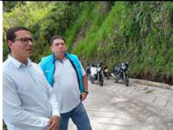
Se realiza visita por parte del Alcalde , Secretario de Planeación y Veeduría a la obra en el corregimiento de San Daniel en el tramo 5 L =240 m aprox.
