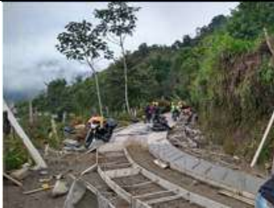
El contratista instala la formaleta y acero de refuerzo No 3 para huella derecha de 3000 psi (0,15m x0,90 m x 3.0 mx 20 ) en el tramo No 5 L = 240 m aproximadamente en el sector del codito San Daniel.
