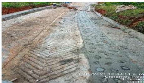
Imagen 2. Vaciado de concreto ciclopeo y cunetas (K6+800)
