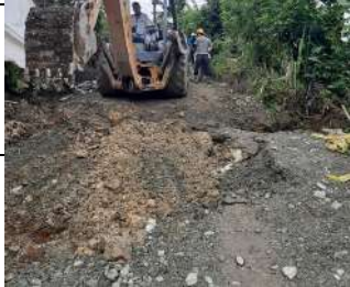
Alcantarilla Travesía de los González - K9+800
