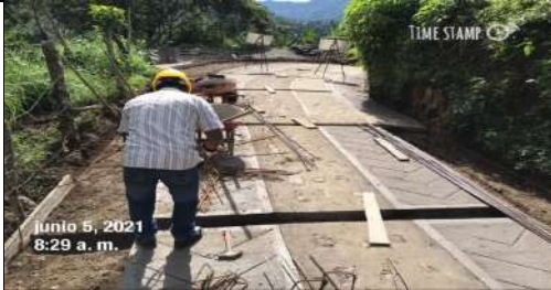
El contratista realiza instalación de acero para bermas de 15 m costado izquierdo con un ancho de 0,70 m tramo 3 Pr 7+000 al Pr 7+075 Vereda el Placer de 75 metros.
