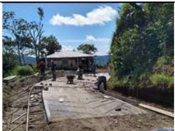
El contratista realiza la instalacion de la formaleta para el sobre ancho en concreto ciclópeo en ambos lados de la placa huella (0,9 m x 3,10m x 0,15 m) en el tramo No 5 de
