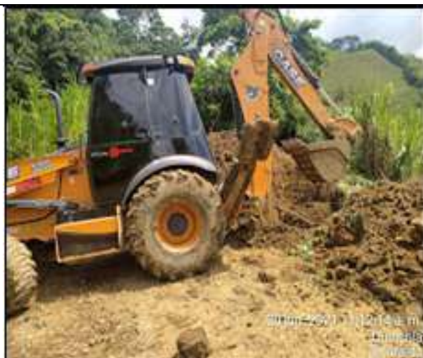
Tramo 5: Excavación mecánica alcantarilla
