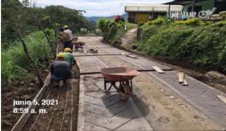
El contratista realiza instalación de acero para bermas de 15 m costado derecho con un ancho de 0,65 m tramo 3 Pr 7+000 al Pr 7+075 Vereda el Placer de 75 metros.
