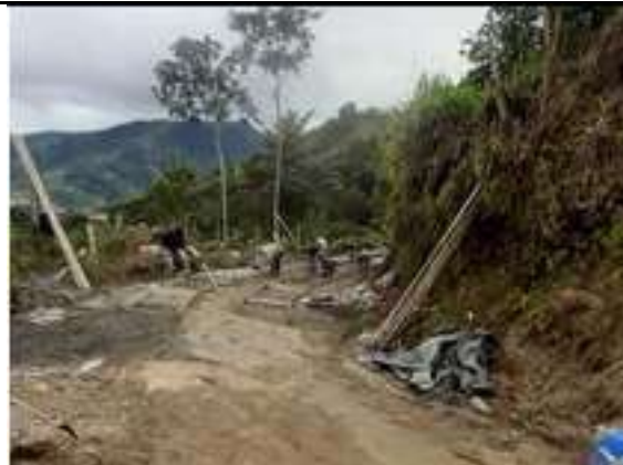
El contratista instala la sub base (0,15m x4,5m x 60m ) y compactación de la misma en el tramo No 5 L = 240 m aproximadamente en el sector del codito San Daniel.
