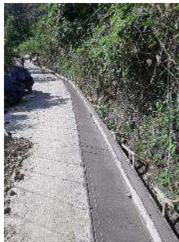
Concreto cuneta izquierda sector Pisamal
