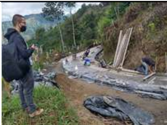
El contratista funde la huella central en concreto ciclópeo 2000 psi (0,15m x0,90 m x 3.0 mx 20 ) en el tramo No 5 L = 240 m aproximadamente en el sector del codito San Daniel.
