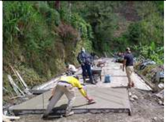
El contratista funde la placa de acceso en concreto de 3000 psi (0.15 m x 3.00 m x 2.70 m) en el tramo No 5 de placa huella de los 240 m proyectados para el sector del codito San Daniel.
