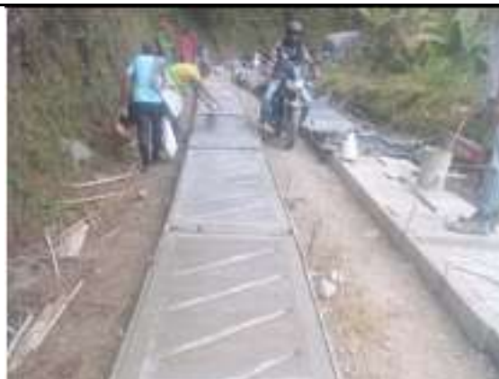
El contratista funde las huellas en concreto de 3000 psi (40 m) (26 x 0.15 m x 3.00 m x0.90 m) en el tramo No 5 de
