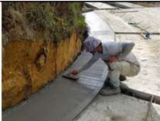
El contratista realiza la fundida de la cuneta izquierda en concreto de 3000 psi en una distancia 40 m en el tramo No
