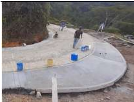
El contratista funde las cunetas de los dos lados de la placa huella en concreto de 3000 psi en el tramo No 5 de placa huella de los 240 m proyectados para el sector del codito San Daniel.
