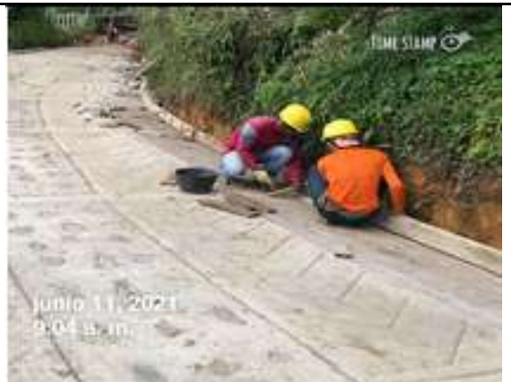
El contratista realiza instalación de acero y formaleta para
