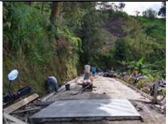
El contratista funde la placa de acceso en concreto de 3000 psi (0.15 m x 3.00 m x 2.70 m) en el tramo No 5 de
