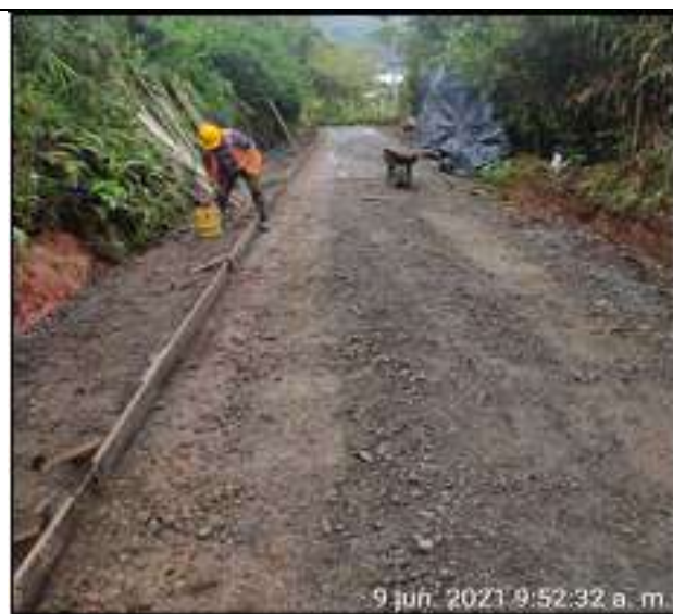
Tramo 3: Instalación de formaletas en placa huellas
