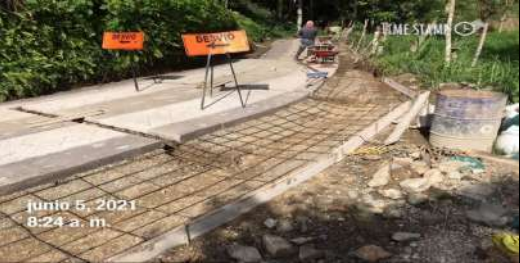
El contratista realiza instalación de acero para sobreancho de 10 m costado derecho con un ancho de 1,50 m tramo 3 Pr 7+000 al Pr 7+075 Vereda el Placer de 75 metros.
