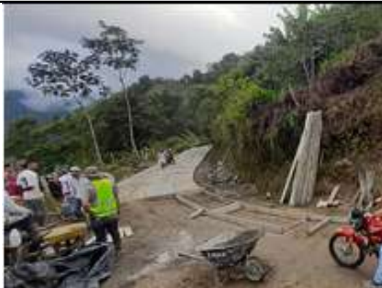
El contratista instala la formaleta la sub base (0,15m x3,0 m x ,90m ) en el tramo No 5 L = 240 m aproximadamente en el sector del codito San Daniel.
