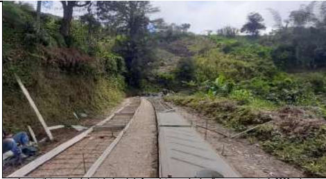
el contratista realiza la instalacion de la formaleta para las huellas en concreto de 3000 psi una distancia 40 m en el tramo No 5 de placahuella de los 240 m proyectados para el sector del codito San Daniel.
