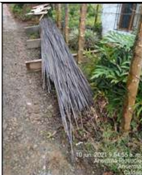
Tramo 3: Suministro y figuración de acero
