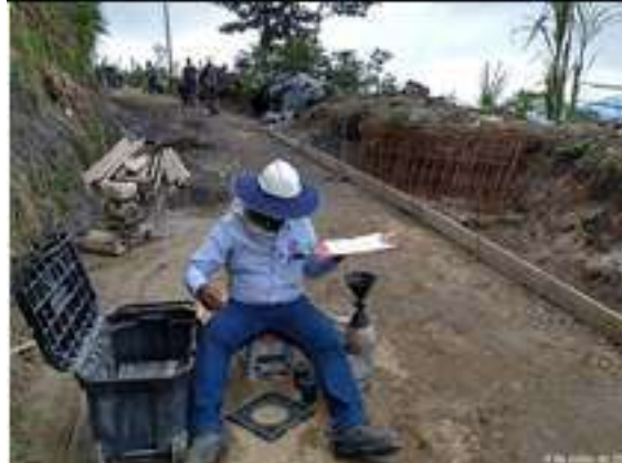
La interventoría realiza la toma de densidades por parte del laboratorio Ingeniería y Laboratorio de Materiales S.A.S. en el tramo No 5 L = 240 m aproximadamente en el sector del codito San Daniel.
