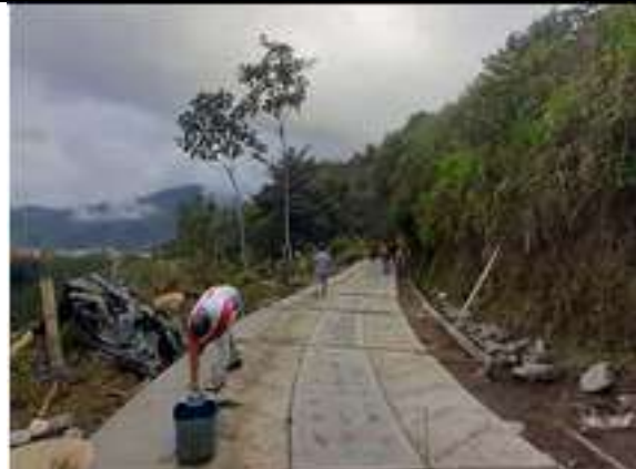
El contratista instala la formaleta y acero de refuerzo No 3 para cuneta en el lado izquierdo para (0,15m x0,70 m x 60m ) en el tramo No 5 L = 240 m aproximadamente en el sector del codito San Daniel.
