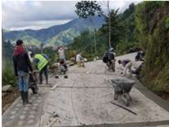
El contratista realiza la fundida de la cuneta izquierda en concreto de 3000 psi en una distancia 40 m en el tramo No 5 de placa huella de los 240 m proyectados para el sector del codito San Daniel.
