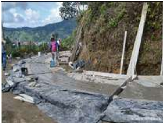
El contratista funde la huella central en concreto ciclópeo 2000 psi (0,15m x0, 90 m x 3.0 mx 20) en el tramo No
