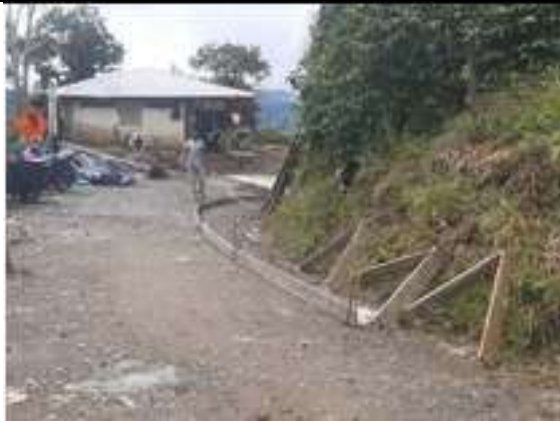
El contratista realiza la instalación de la formaleta de madera con módulos de (0,90 m x 3,00 m x 0,15 m) en una distancia 40 m en el tramo No 5 de placa huella de los 240 m proyectados para el sector del codito San Daniel.
