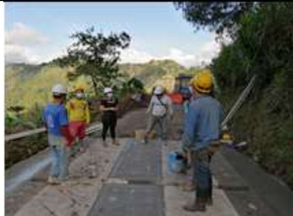
El contratista realiza capacitaciones y pausas activas por parte de SST en el tramo No 5 de placa huella de los 240 m proyectados para el sector del codito San Daniel.
