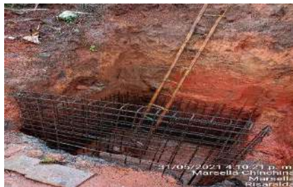
Imagen 1. Instalacion de formaleta y acero de refuerzo para cabezal de alcantarilla (K6+110).
