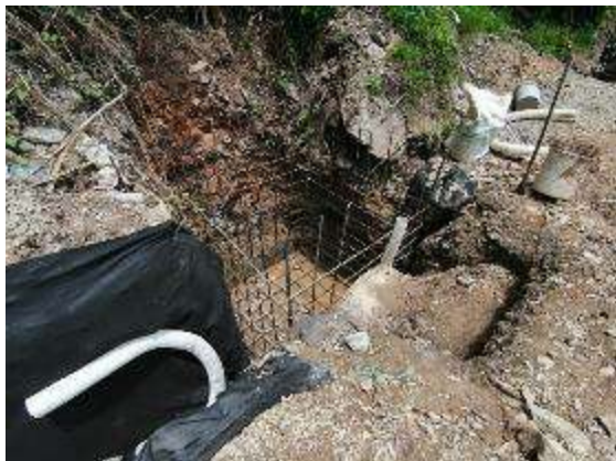
Instalación acero de Poceta sector La Brillantina
