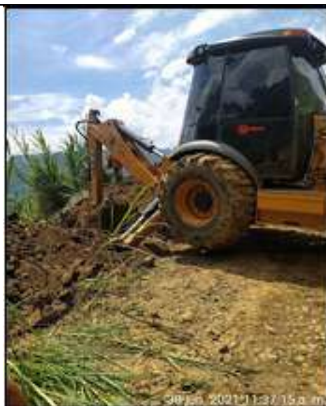
Tramo 5: Excavación mecánica alcantarilla
