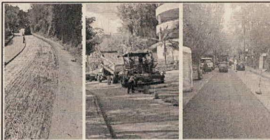
DESCRIPCIÓN: Imprimación y pavimentación de la vía El Chingul con MDC19 más fibra.
