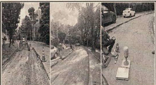
DESCRIPCIÓN: Fresado y mejoramiento de la estructura (según diseño) en la vía Biocity.
