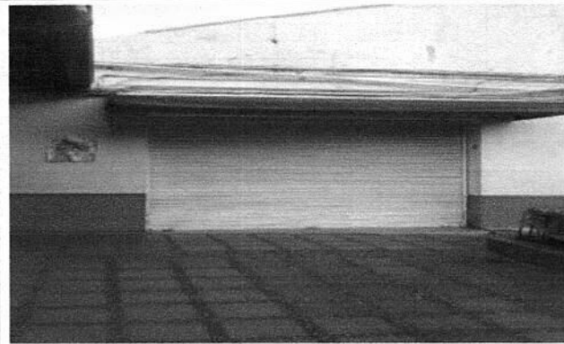
1-PANORAMICA FACHADA PPAL. Y HALL ACCESO CAFETERIA
