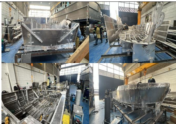
Foto No. 89 a 92 – Bote No. 11 REFUERZOS, TUBERÍA Y FORRO DEL CASCO
