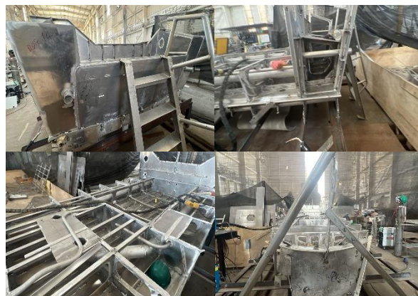
Foto No 133 a 136 – Bote No. 14 REFUERZOS, ESPEJO, CUADERNAS, Y TUBERÍA
