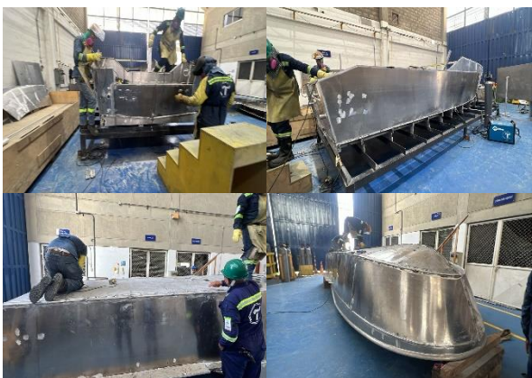
Foto No. 93 a 96 – Bote No. 12 REFUERZOS, TUBERÍA Y FORRO DEL CASCO
