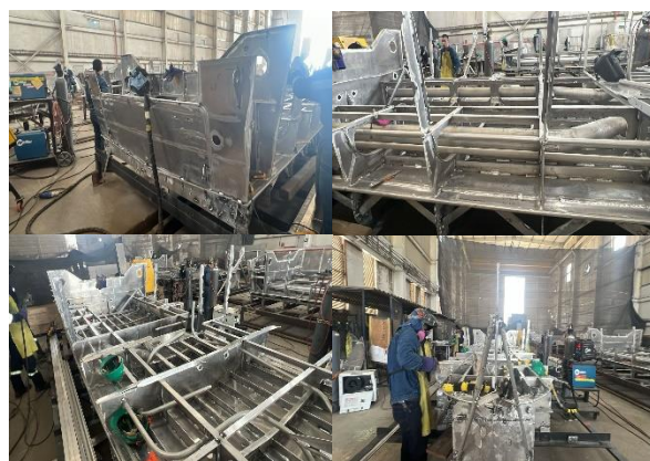
Foto No 129 a 132 – Bote No. 13 REFUERZOS, ESPEJO, CUADERNAS, Y TUBERÍA
