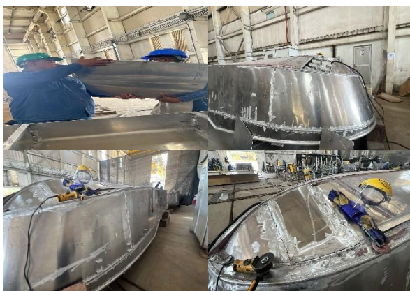
Foto No 117 a 120 –Bote No. 10 CUADERNA X-10 Y LAMINA DE FONDO
