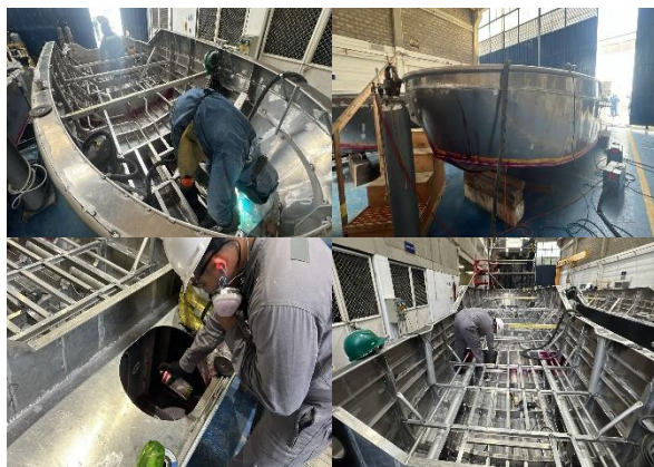
Foto No 125 a 128 –Bote No. 12 REFUERZOS, FORRO DEL CASCO Y END
