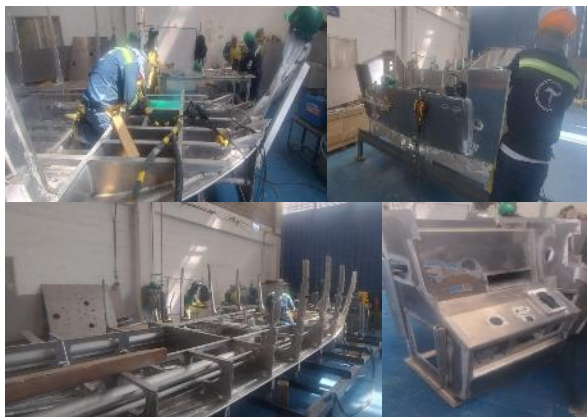
Foto No. 65 a 68 – Bote No. 12 refuerzos, cuadernas y consolas
