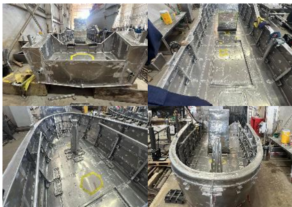
Foto No. 11 a 14 – Bote No. 5 Cubierta principal consola y outfitting
