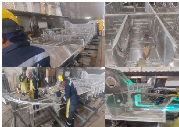
Foto No. 69 a 72 – Bote No. 13 Láminas de fondo, barras y cuadernas
