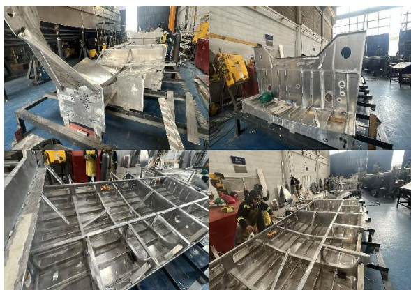
Foto No 205 a 208 –Bote No. 18 LAMINAS DE FONDO, REFUERZOS, CUADERNAS, MANPAROS
