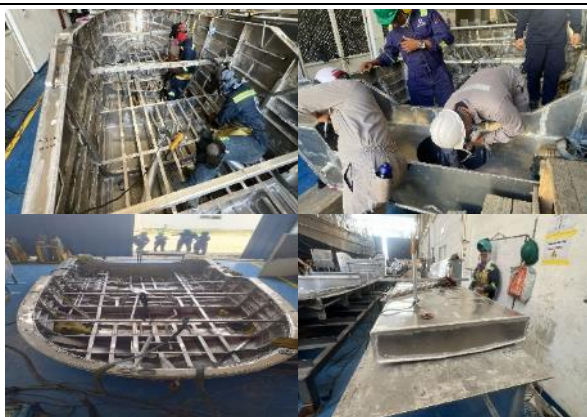
Foto No 147 a 150 –Bote No. 7 fondo, END y tanque de combustible
