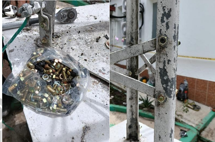
Cambio de tornillería del soporte de la antena.
