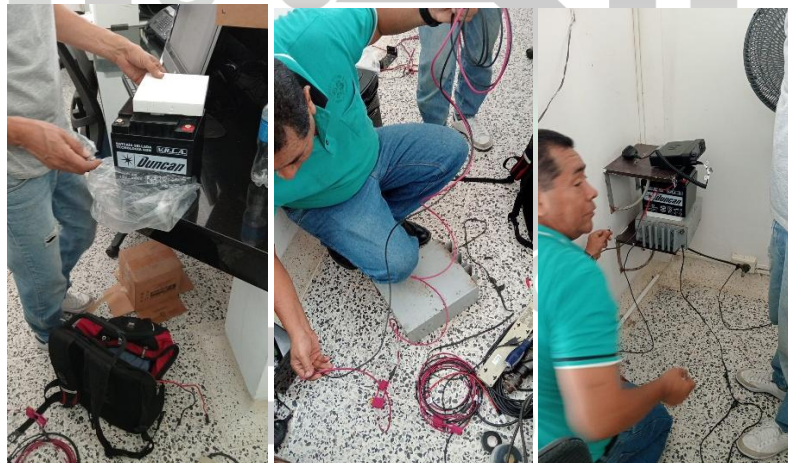
Instalación de la batería nueva y radio base.
