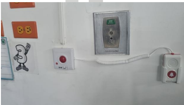
Botones instalados en cada cama. Compuesto por una base sobre la pared y un control de mano.
