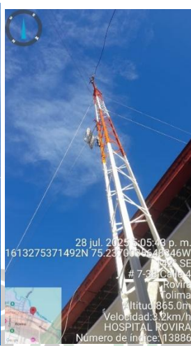
Instalación de pararrayos y antena sobre la estructura pintada.
