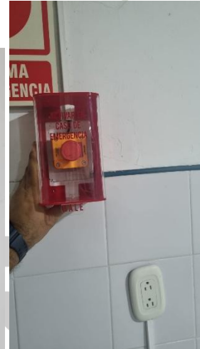
Botones instalados para la activación de alarma.
