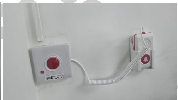
Botones instalados en cada cama. Compuesto por una base sobre la pared y un control de mano.
