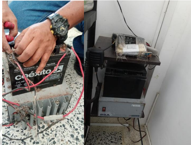
Bateria anterior retirada – Radio base reemplazado
