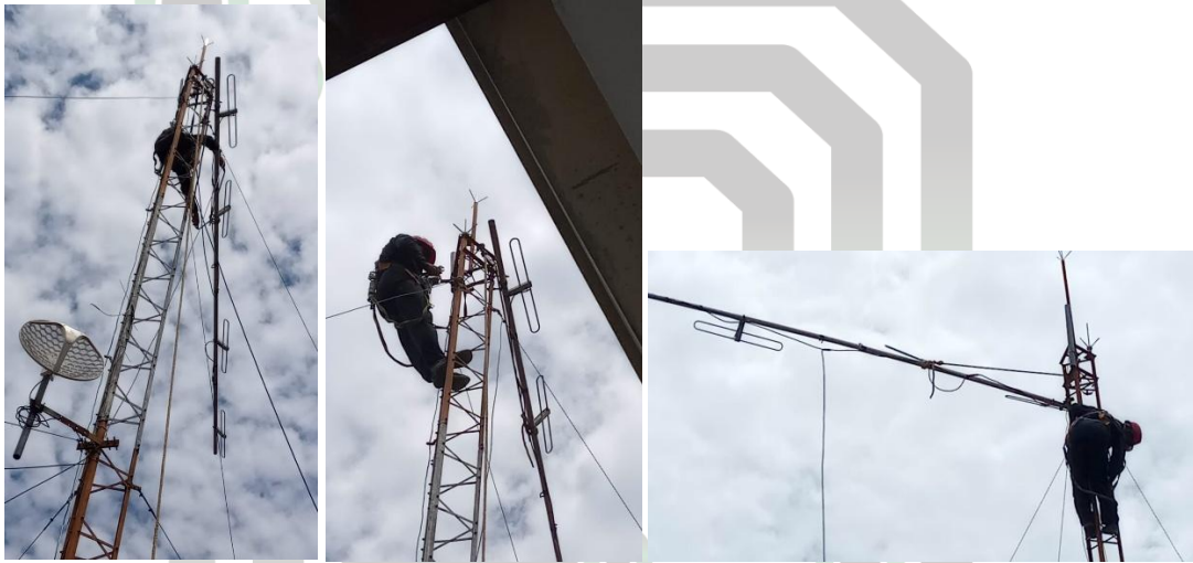
Desmante de antena Dipolo.
