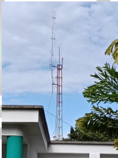
Instalación de pararrayos y antena sobre la estructura pintada.
