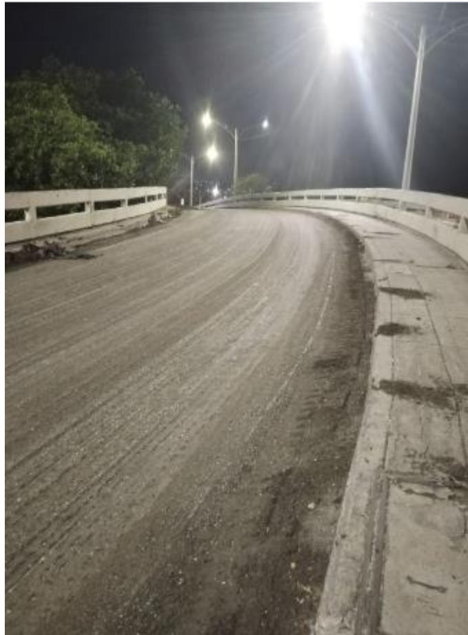
Fresado de carpeta asfáltica- PUENTE ROMER AGUIRRE
