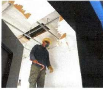
DESMONTE DE CIELO RASO EN DRYWALL Y ENTRAMADO INCLUYE RETIRO DE ESCOMBROS
