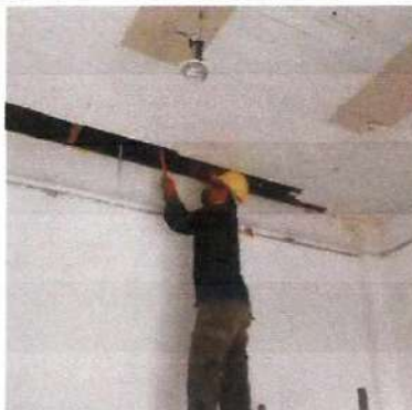
DESMONTE DE CIELO RASO EN DRYWALL Y ENTRAMADO
