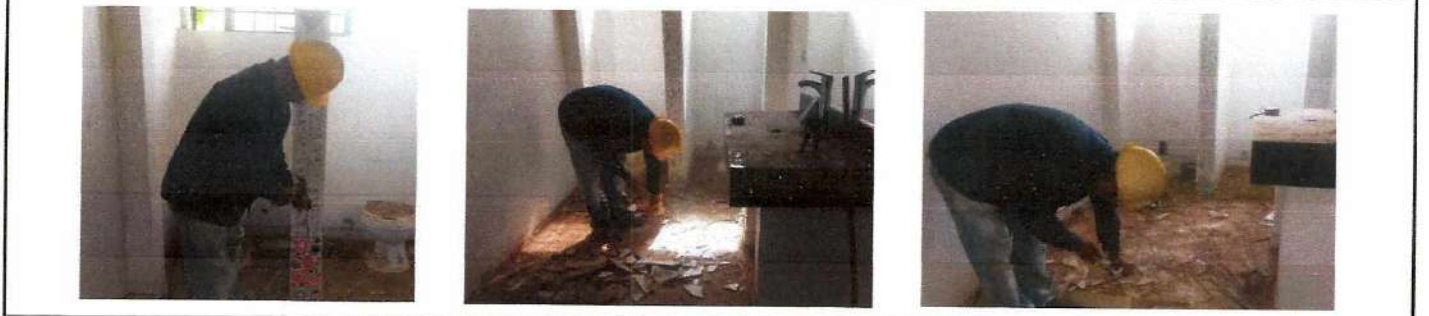
REMOCION DE ENCHAFE PARED INCLUYE RETIRO DE ESCOMBROS
