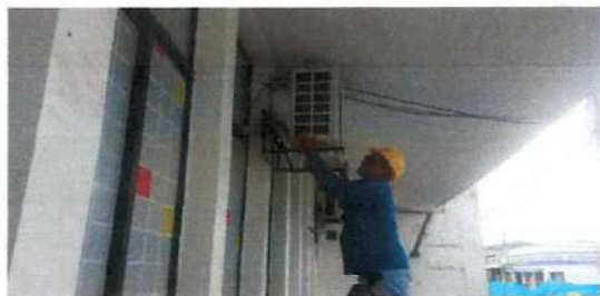
DESMONTE DE AIRES ACONDICIONADO INCLUYE DESMONTE DE CONDENSADOR
