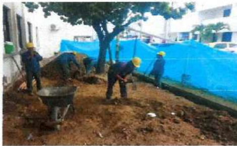
EXCAVACIÓN MANUAL
