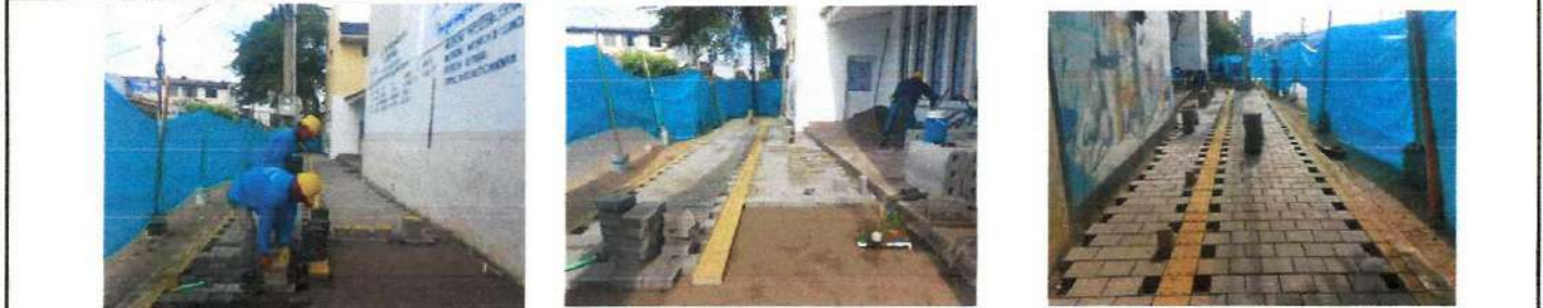
ACABADO DE PISO CON ADOQUÍN PREFABRICADO EN CONCRETO
