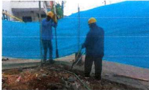
RELLENO CON MATERIAL SELECCIONADO COMPACTADO RETIRO DE ESCOMBROS, DESMONTE DE AIRES ACONDICIONADO INCLUYE DESMONTE DE CONDENSADOR RETIRO DE ESCOMBROS
