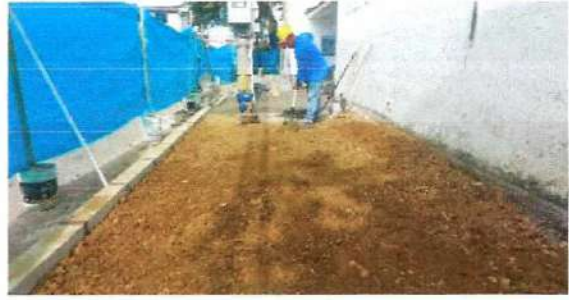
RELLENO CON MATERIAL SELECCIONADO COMPACTADO RETIRO DE ESCOMBROS, DESMONTE DE AIRES ACONDICIONADO INCLUYE DESMONTE DE CONDENSADOR RETIRO DE ESCOMBROS
