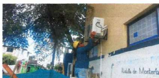
DESMONTE DE AIRES ACONDICIONADO INCLUYE DESMONTE DE CONDENSADOR
