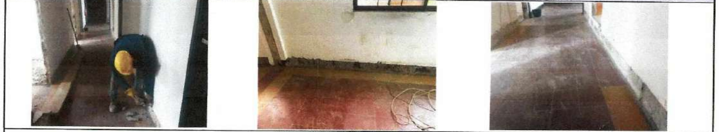
DEMOLICIÓN DE ZOCALOS INCLUYE RETIRO DE ESCOMBROS
