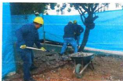
DEMOLICIÓN DE ENCHAPE PISO Y PLANTILLA DE CONCRETO
