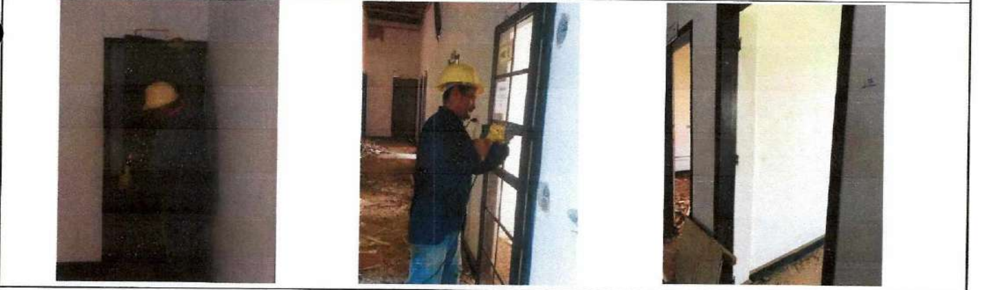
DESMONTE DE PUERTA Y MARCO
