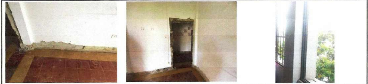
DEMOLICIÓN DE ZOCALOS INCLUYE RETIRO DE ESCOMBROS, DESMONTE DE VENTANAS, MARCO EN ALUMINIO Y/O MADERA
