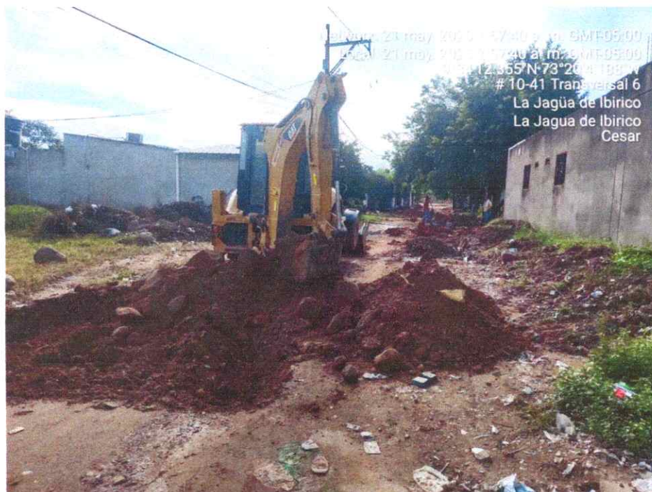
Imagen 2. Fallo presentado en un tramo.
