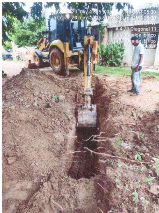
Imagen 3. Excavación para acometidas.
