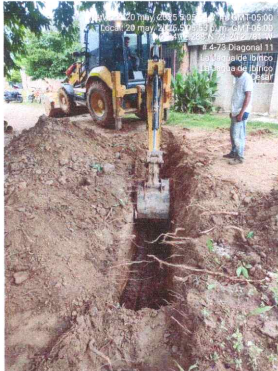
Imagen 3. Excavación para acometidas.
