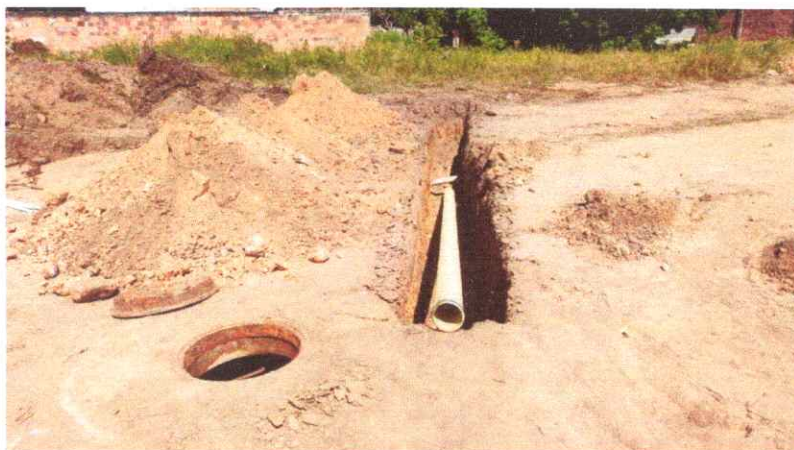
Imagen 4. Excavación para acometidas y tuberías.
