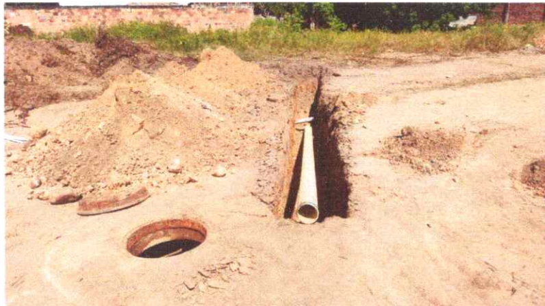
Imagen 4. Excavación para acometidas y tuberías
