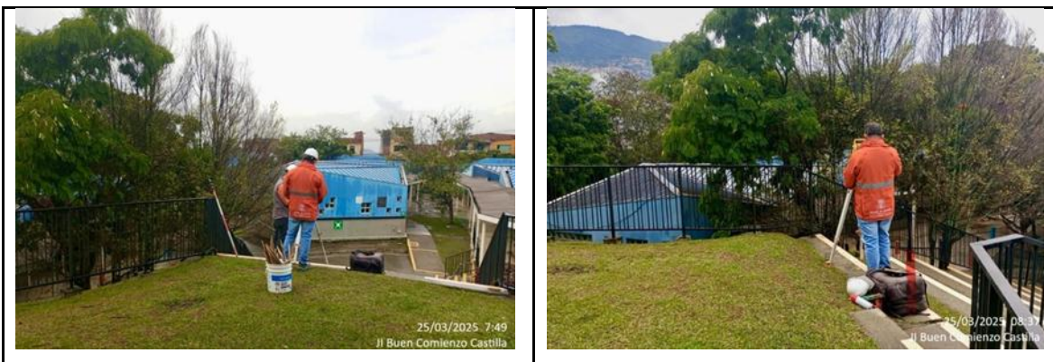
Fotografía 1. Replanteo topográfico y demarcación de la ampliación
