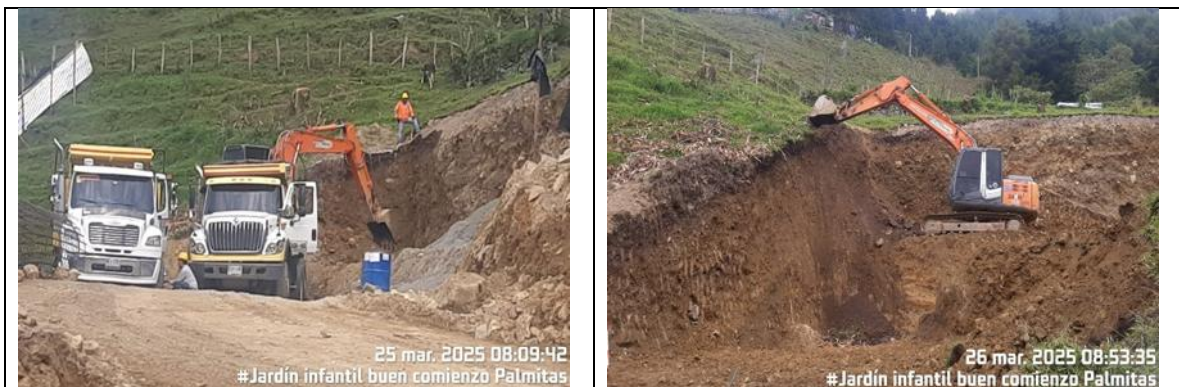
Explanación y nivelación mecánica del terreno Bloque No.01
