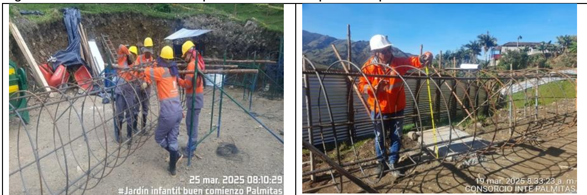
Figurado de acero de refuerzo para canastas de pilas Bloque No.02
