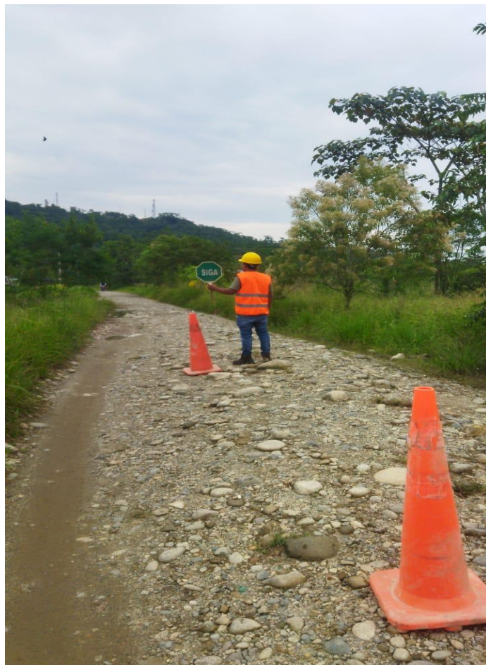
Imagen No 12 -13. Auxiliares de tránsito en obra con uso de chalecos reflectivos y paleta pare-siga, control vehicular y peatonal.
