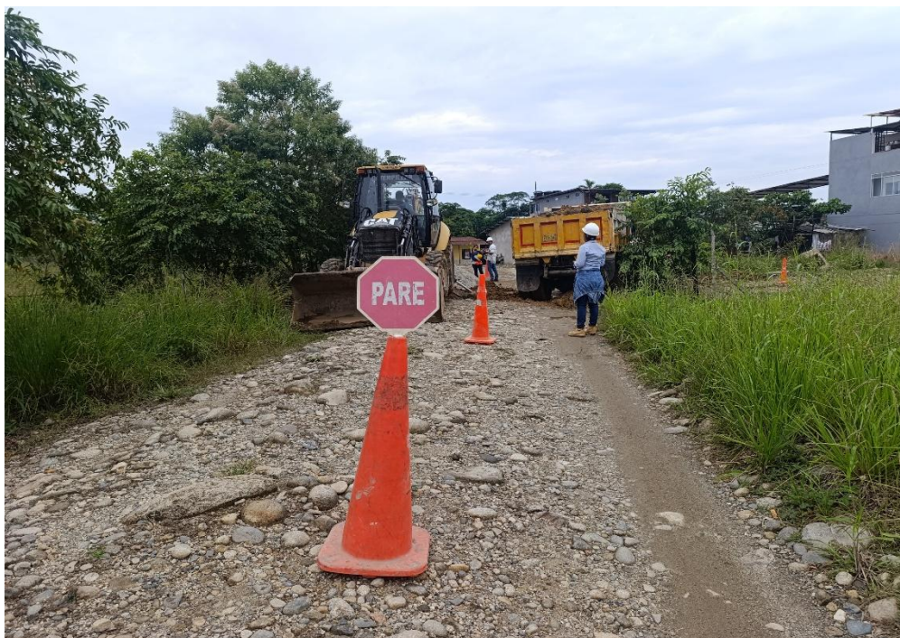
Imagen No 1-9. Implementación señalización informativa, preventiva, reglamentaria- conos, vías intervenidas en obra
