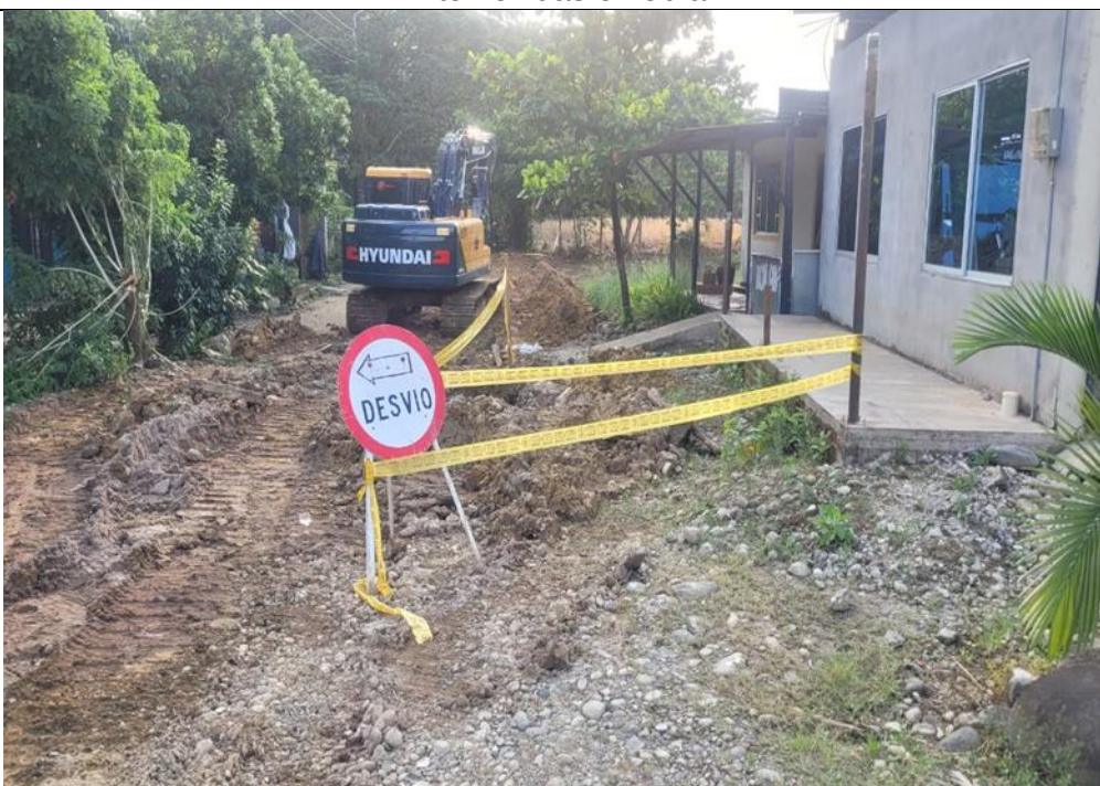
Imagen No 1-9. Implementación señalización informativa, preventiva, reglamentaria- conos, vías intervenidas en obra
