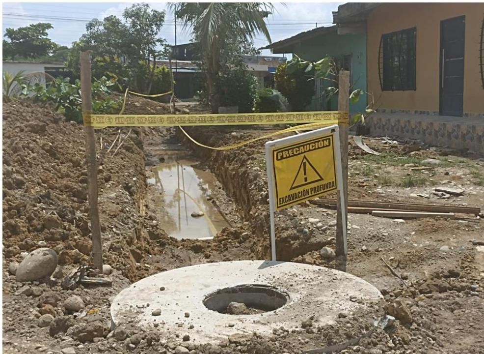
Imagen No 10-11. Señalización con cinta peligro de áreas intervenidas en la obra
