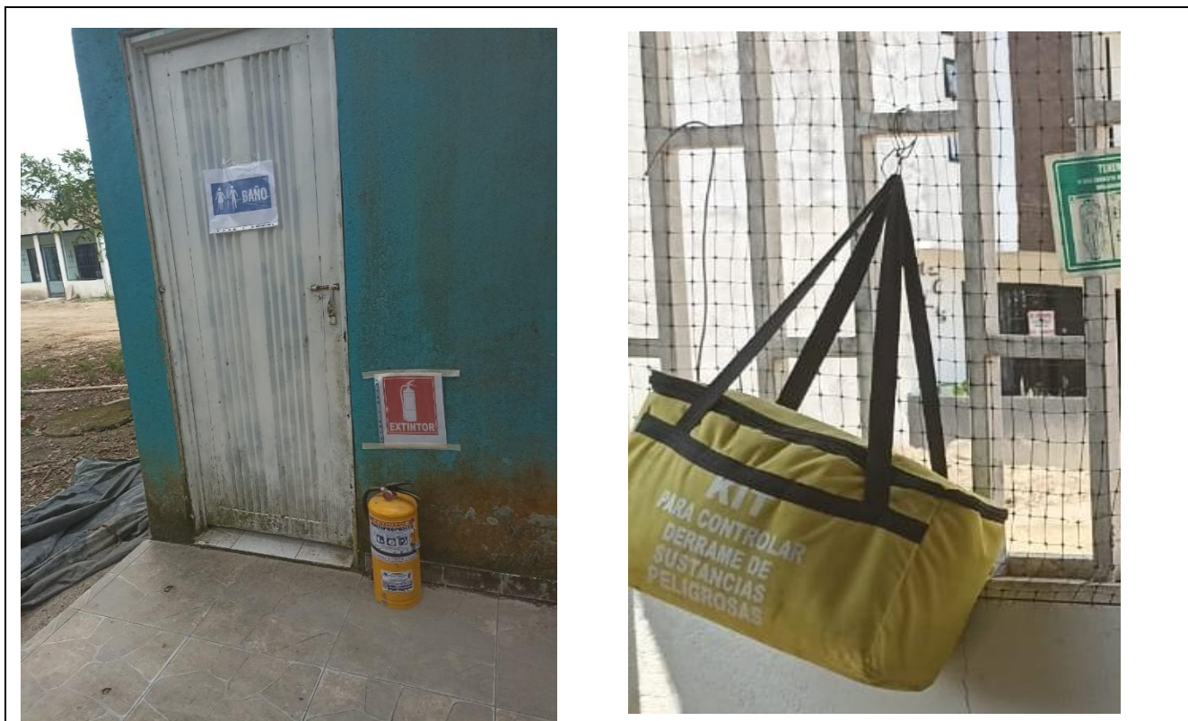
Imagen No 12-13. Baño en campamento- instalación de equipo contraincendios
